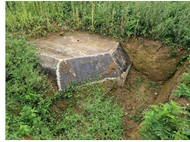
Vue de l'angle nord-est du bunker - abri de type 502 pour deux groupes de combat (B 25/8) (+ 86,07 au-dessus du niveau de la mer). On peut lire 30/11/42 sur la dalle de couverture Phot. Guillaume Lécueillier IVR53_20242910319NUCA
