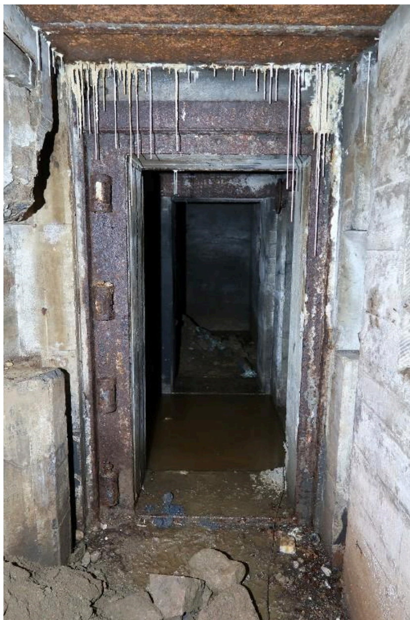
Vue intérieure du bunker - abri de type 502 pour deux groupes de combat (B 25/8) : entrée du sas depuis le nord. L'huissierie témoigne du montage d'une porte blindée. De part et d'autre du couloir, un puits d'antenne radio (photographie réalisée après dépollution pyrotechnique)
