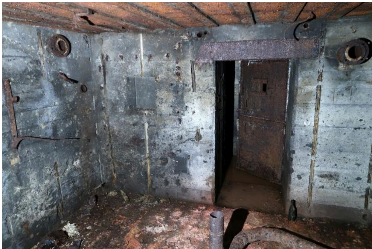
Vue intérieure du bunker - abri de type 502 pour deux groupes de combat (B 25/7) : angle nord-est, accès de la petite salle avec sa porte blindée. A gauche de la porte, niche murale et emplacement du boîtier de connexion téléphonique. Les murs sont constellés d'éclats et noircis par la fumée (photographie réalisée après dépollution pyrotechnique)
