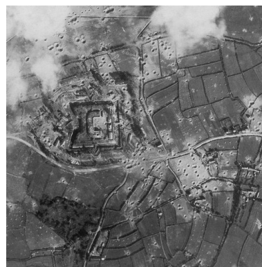
Vue aérienne verticale du fort Montbarey et des fossés antichars situés à l'ouest de Brest, 8 septembre 1944 (photographie du 542e Escadron de la Royal Air Force) Phot. Guillaume Lécullier IVR53_20062904781NUCA
