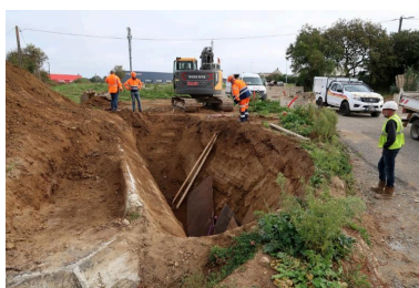
Vue des préparatifs de l'intervention du centre de déminage de Brest dans les deux bunkers du lotissement Alfred Nakache (mercredi 11 octobre 2023). Une pelle mécanique hydraulique a été utilisée pour dégager l'un des deux accès au bunker sud Phot. Guillaume Lécueillier IVR53_20242910464NUCA
