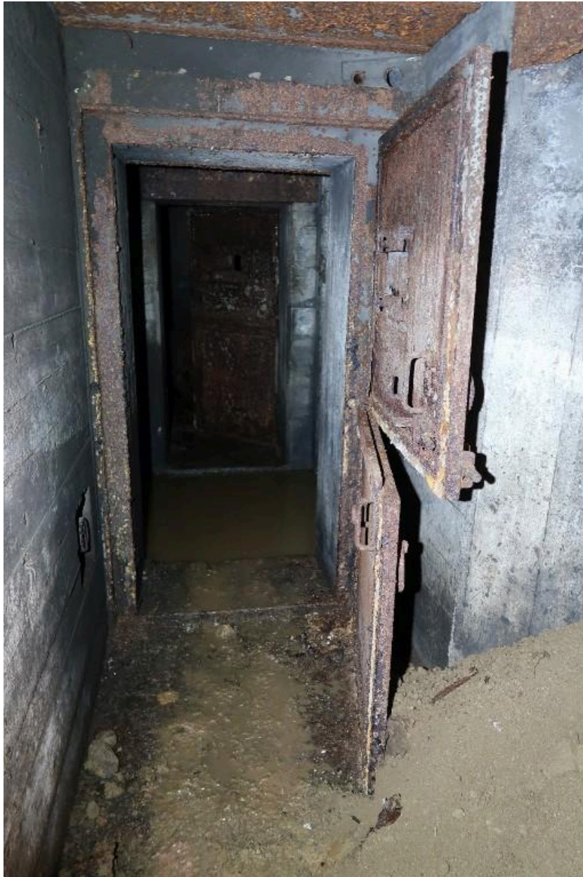
Vue intérieure du bunker - abri de type 502 pour deux groupes de combat (B 25/7) : l'entrée du sas depuis le sud avec sa porte blindée à deux vantaux (photographie réalisée après dépollution pyrotechnique)
