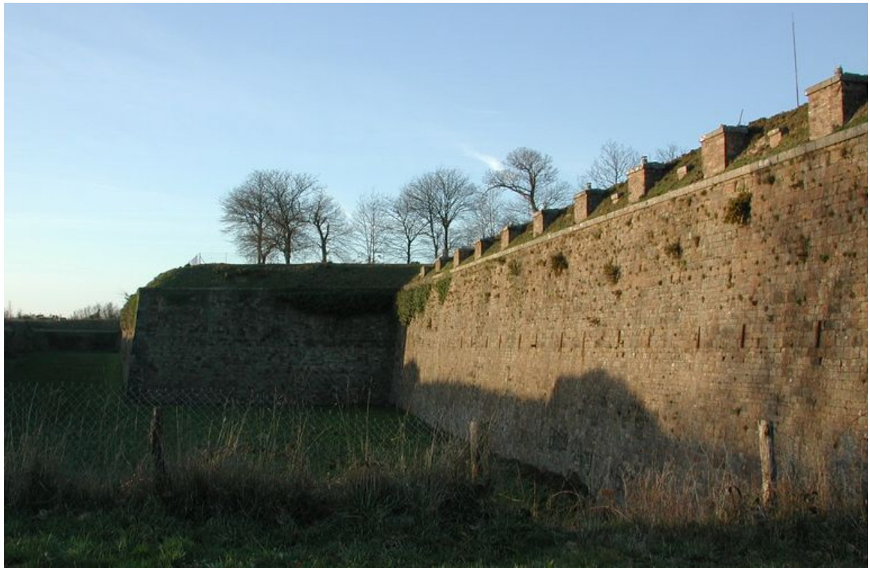
Elévation Sud : détail de la courtine. Noter les souches de cheminée de la caserne aménagée dans l'épaisseur du rempart
