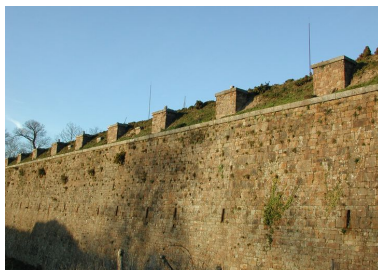
Elévation Sud : détail de la courtine. Noter les créneaux de fusillade Phot. Guillaume Lécueillier IVR53_20042904260NUCA
