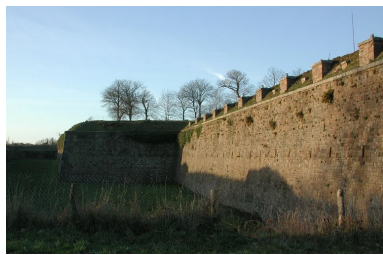
Elévation Sud : détail de la courtine. Noter les souches de cheminée de la caserne aménagée dans l'épaisseur du rempart Phot. Guillaume Lécueillier IVR53_20042904259NUCA
