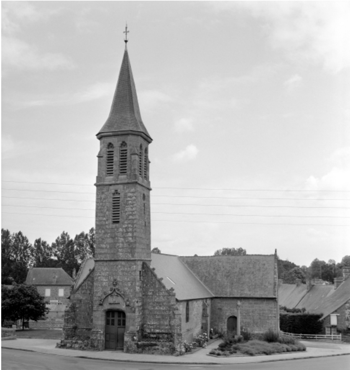
Elévation Ouest : vue générale
