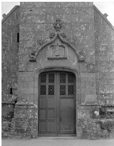
Elévation Ouest, porte principale : vue générale
