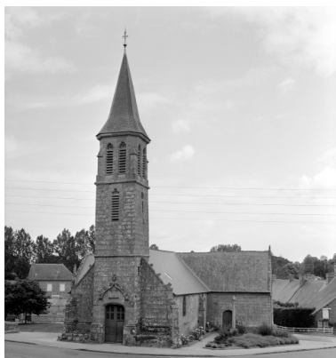
Elévation Ouest : vue générale
