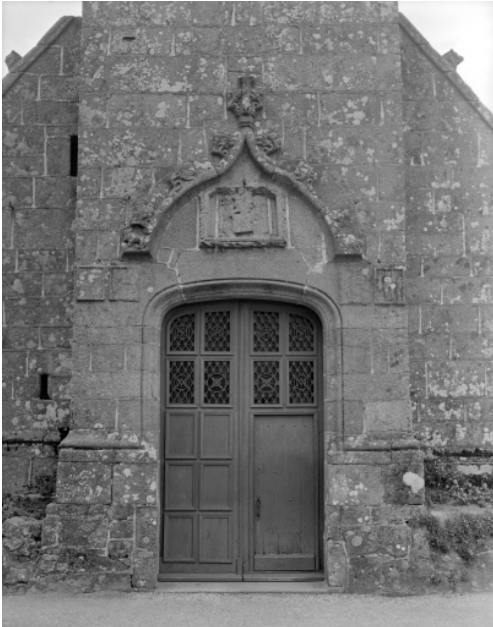
Elévation Ouest, porte principale : vue générale
