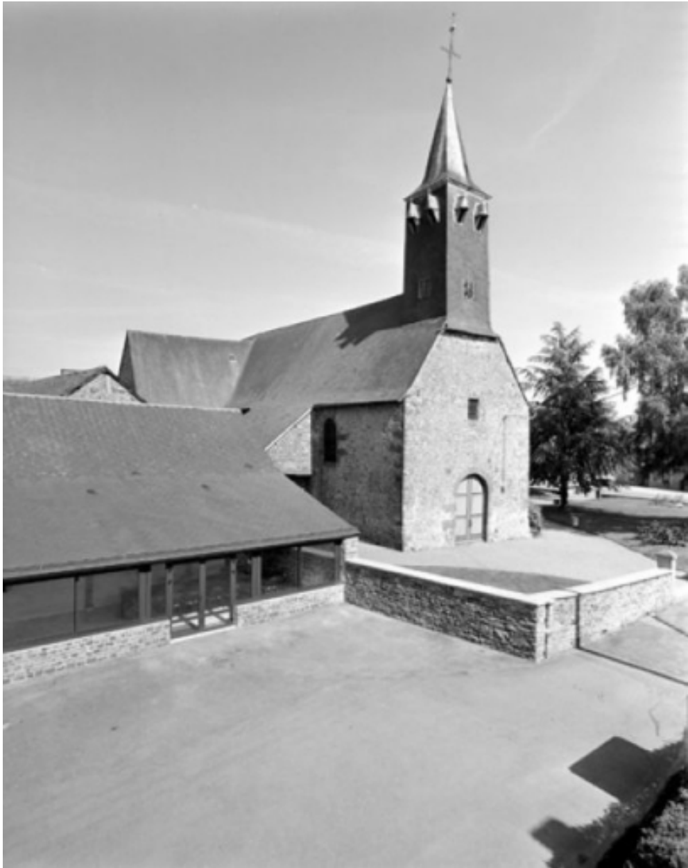
Elévation nord-ouest : vue générale
