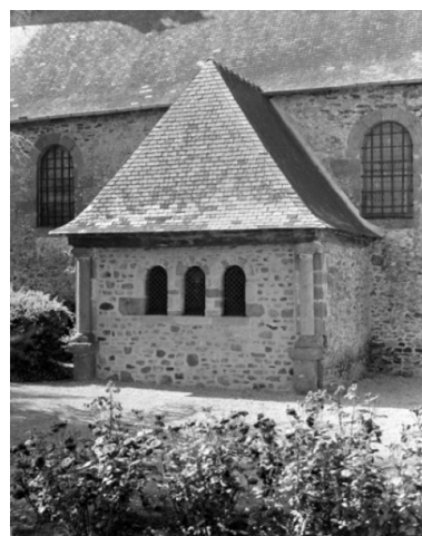
Elévation sud, ancien porche Phot. Guy Artur, Phot. Norbert Lambart IVR53_19943501022X
