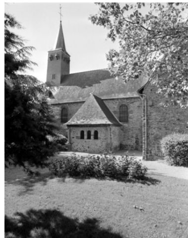
Elévation sud : vue générale Phot. Guy Artur, Phot. Norbert Lambart IVR53_19943501023X
