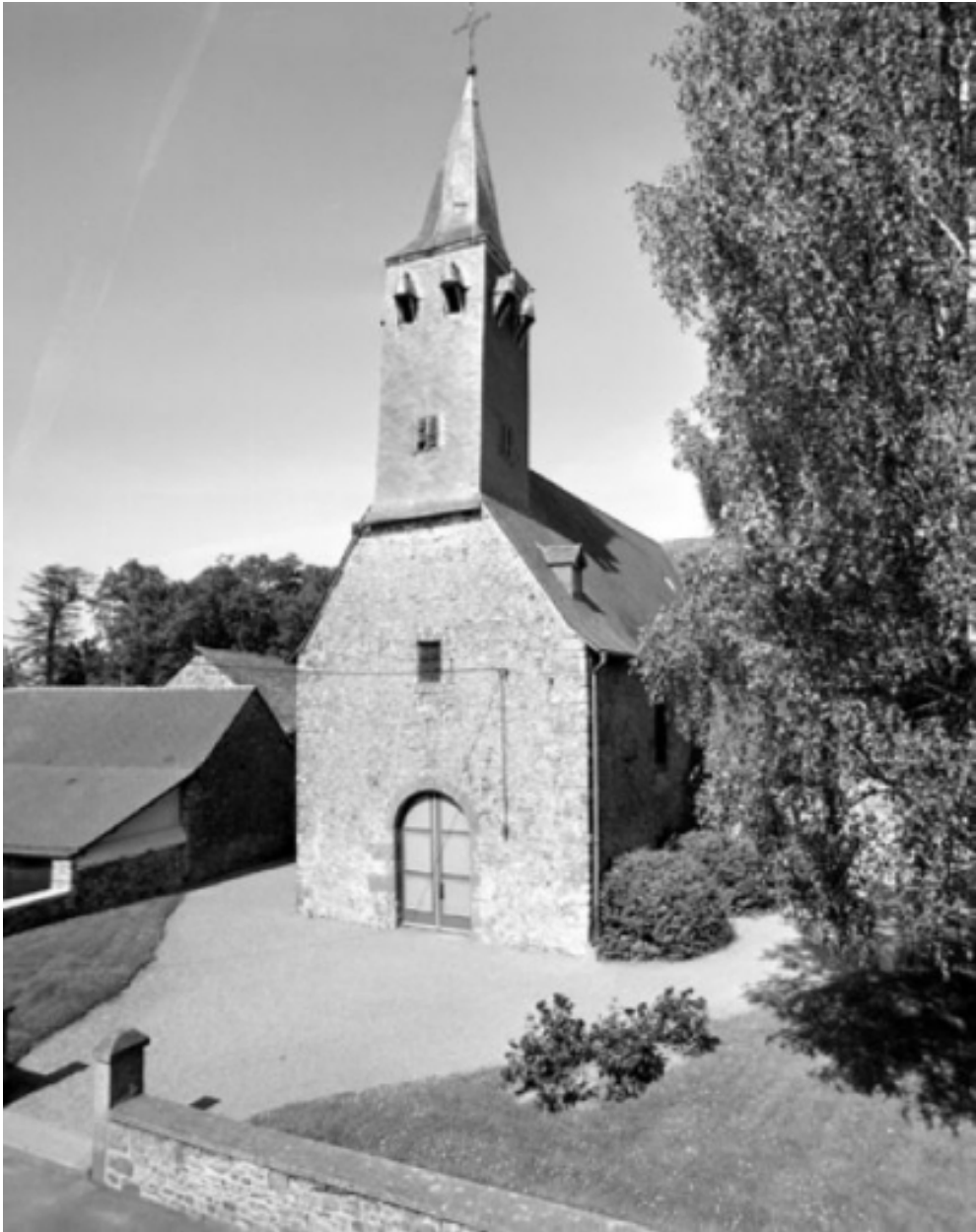
Elévation ouest : vue générale
