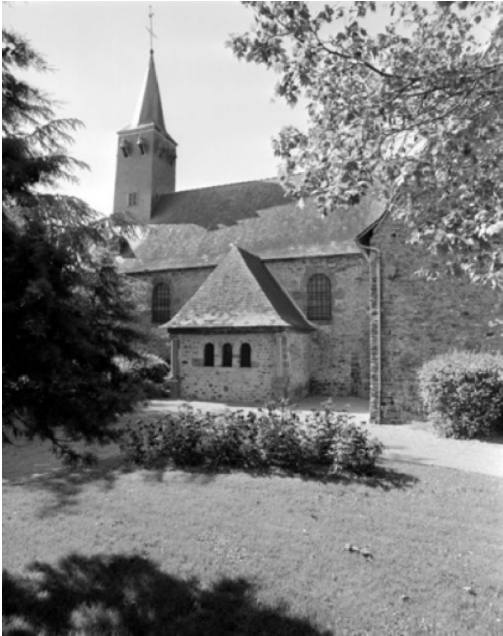
Elévation sud : vue générale
