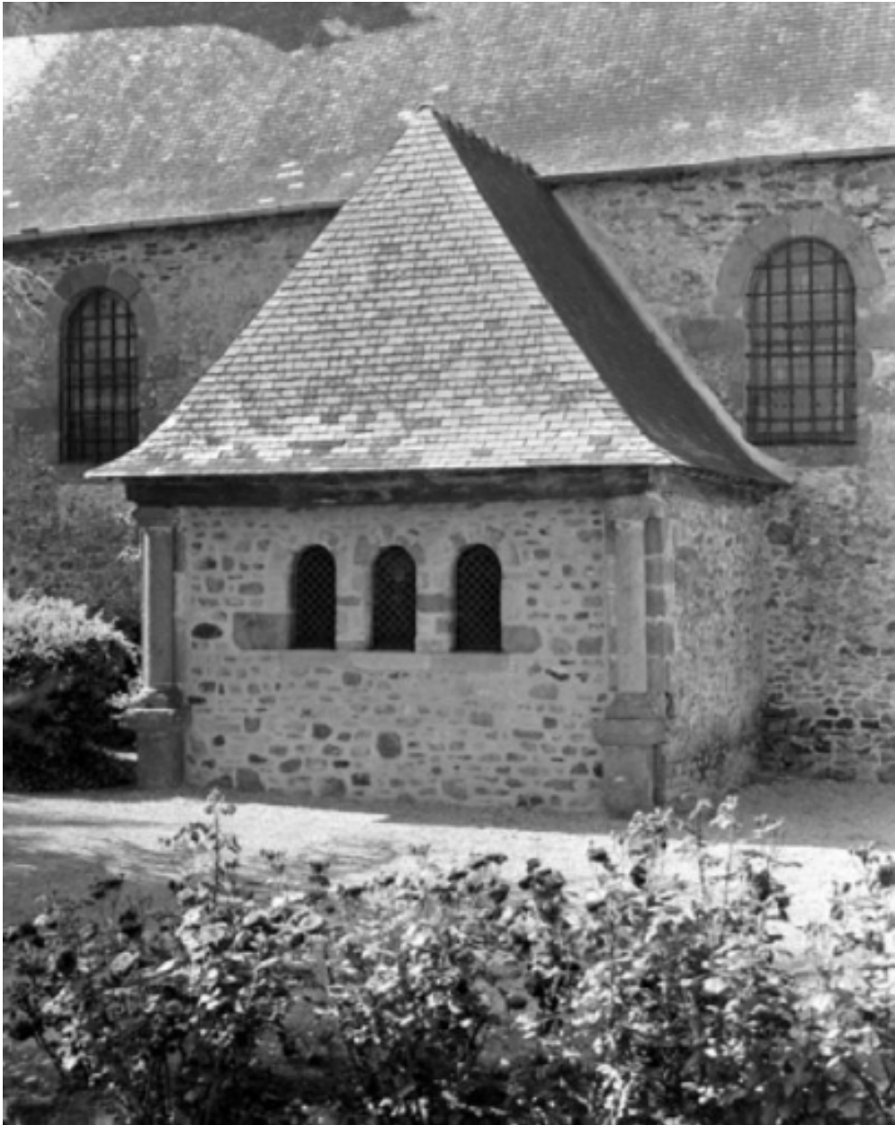
Elévation sud, ancien porche
