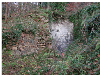
Vue du four à chaux dans son environnement Phot. Guy Prigent IVR53_20082207767NUCA
