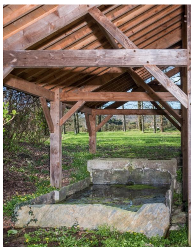
Vue générale est Phot. Barraud Charlotte IVR53_20242200244NUCA
