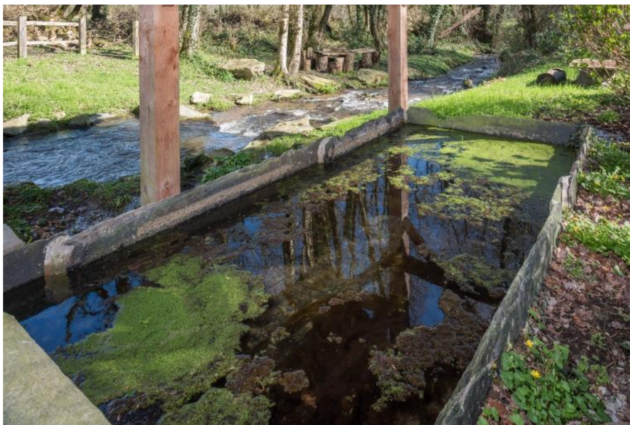
Vue générale ouest du bassin et ruisseau voisin
