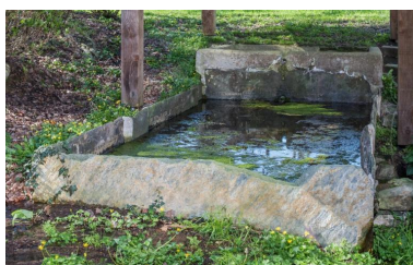
Vue générale est Phot. Barraud Charlotte IVR53_20242200245NUCA
