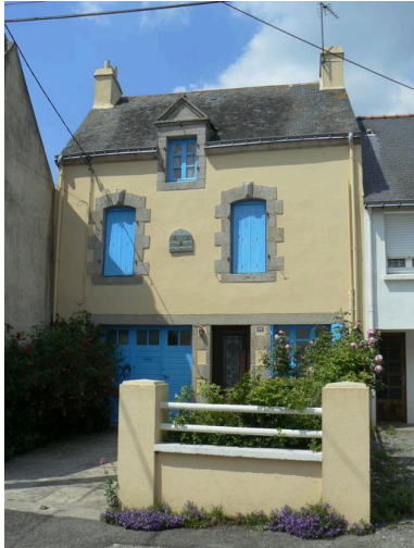
Vue générale de la maison de pêcheur du 30 rue de Cadouarn Phot. Johan Vincent IVR53_20075605683NUCA
