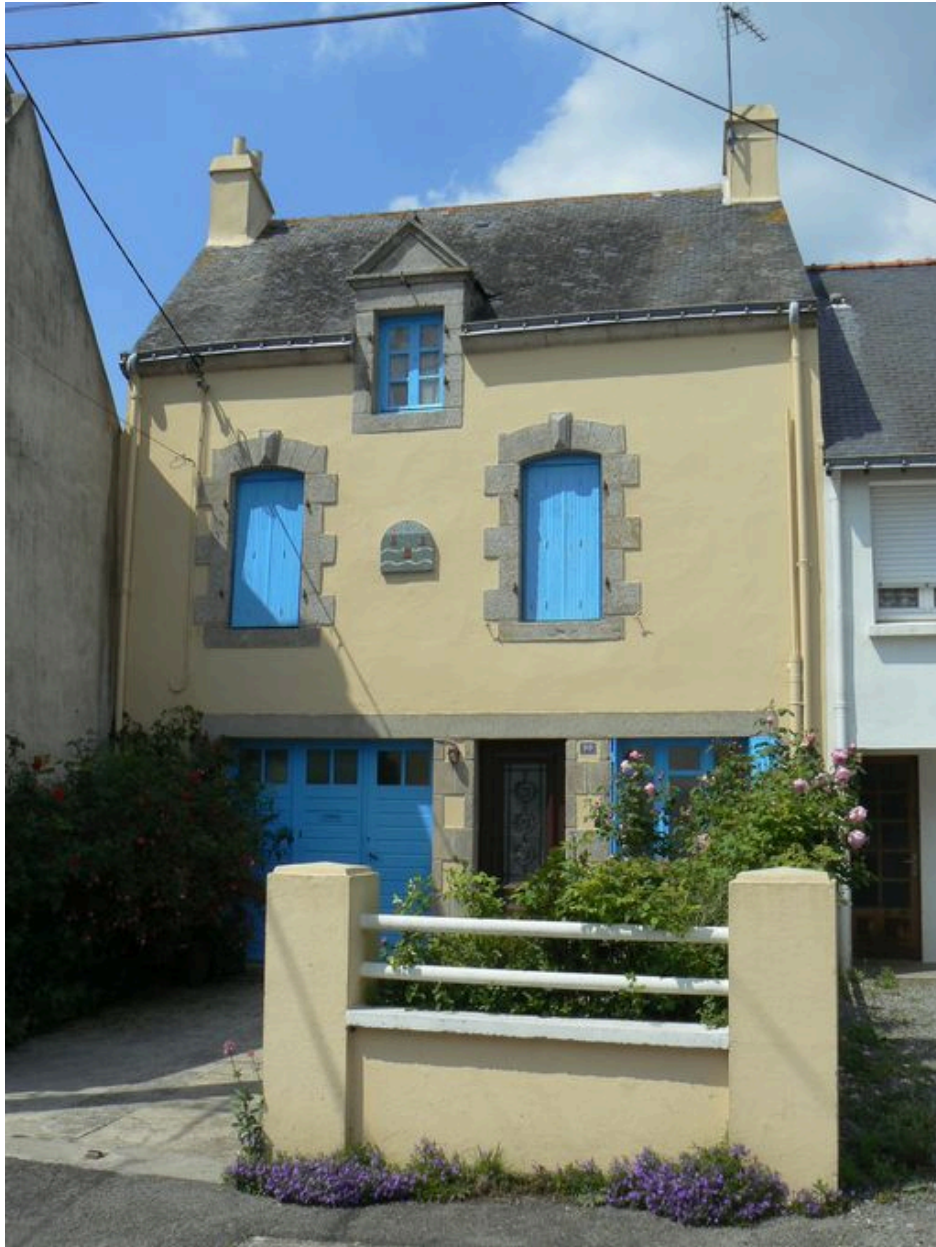
Vue générale de la maison de pêcheur du 30 rue de Cadouarn
