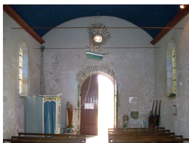
Plonéour-Lanvern, chapelle Notre-Dame-de-Bonne- Nouvelle : vue axiale ouest Phot. Gwénaél Fauchille IVR53_20082905872NUCA
