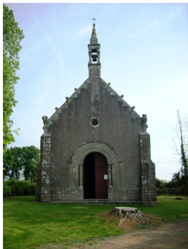
Plonéour-Lanvern, chapelle Notre-Dame-de-Bonne- Nouvelle : élévation ouest Phot. Gwénaél Fauchille IVR53_20082905869NUCA
