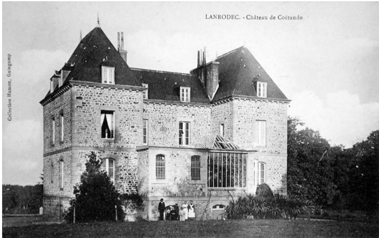
Vue de la façade postérieure
