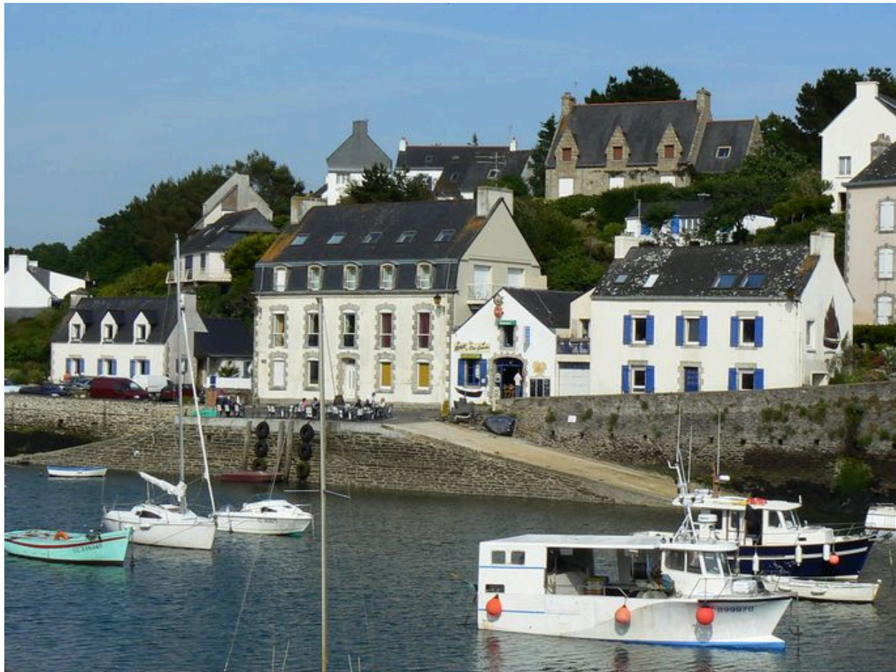
Vue générale du Quai de Kernabat et des deux cales
