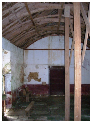
Plourin-lès-Morlaix, chapelle Saint-Michel : vue axiale ouest Phot. Gwénaél Fauchille IVR53_20082906547NUCA
