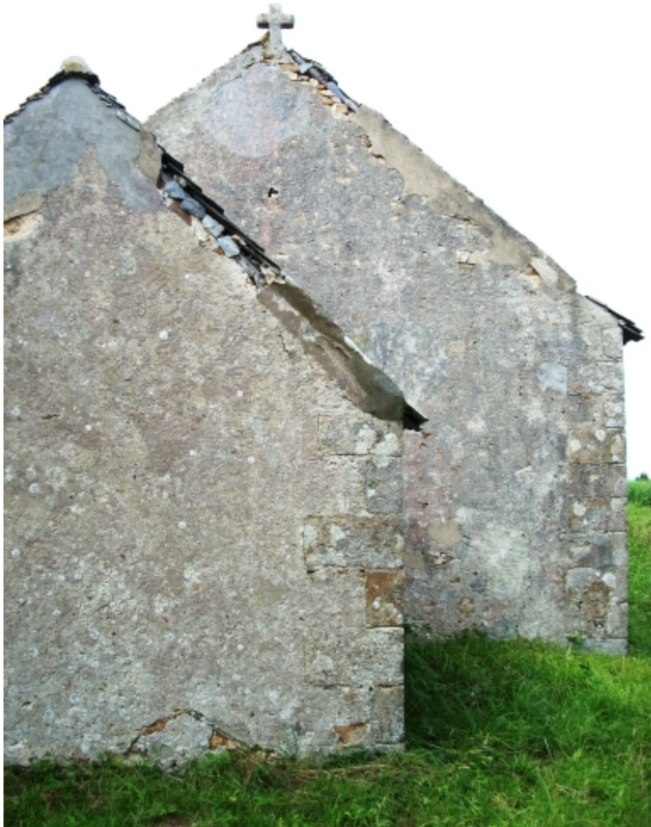
Plourin-lès-Morlaix, chapelle Saint-Michel : élévation est
