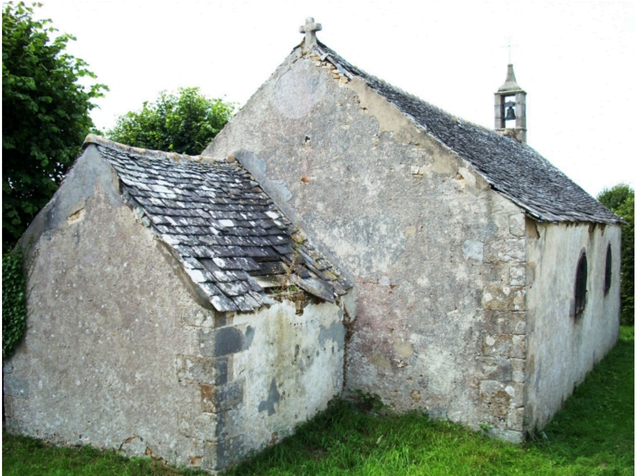
Plourin-lès-Morlaix, chapelle Saint-Michel : vue générale nord-est
