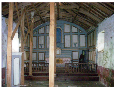
Plourin-lès-Morlaix, chapelle Saint-Michel : vue axiale est Phot. Gwénaél Fauchille IVR53_20082906546NUCA
