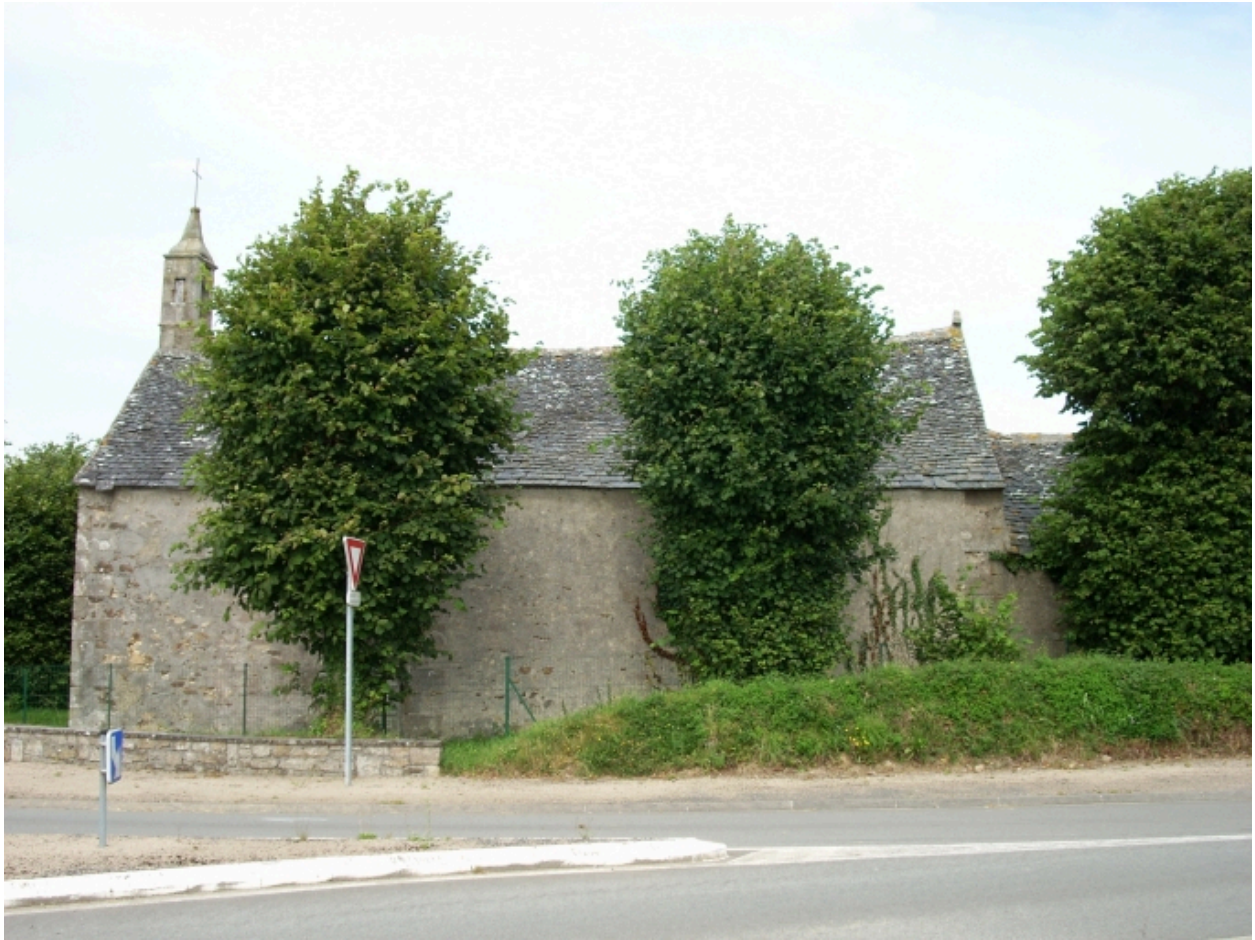
Plourin-lès-Morlaix, chapelle Saint-Michel : élévation sud
