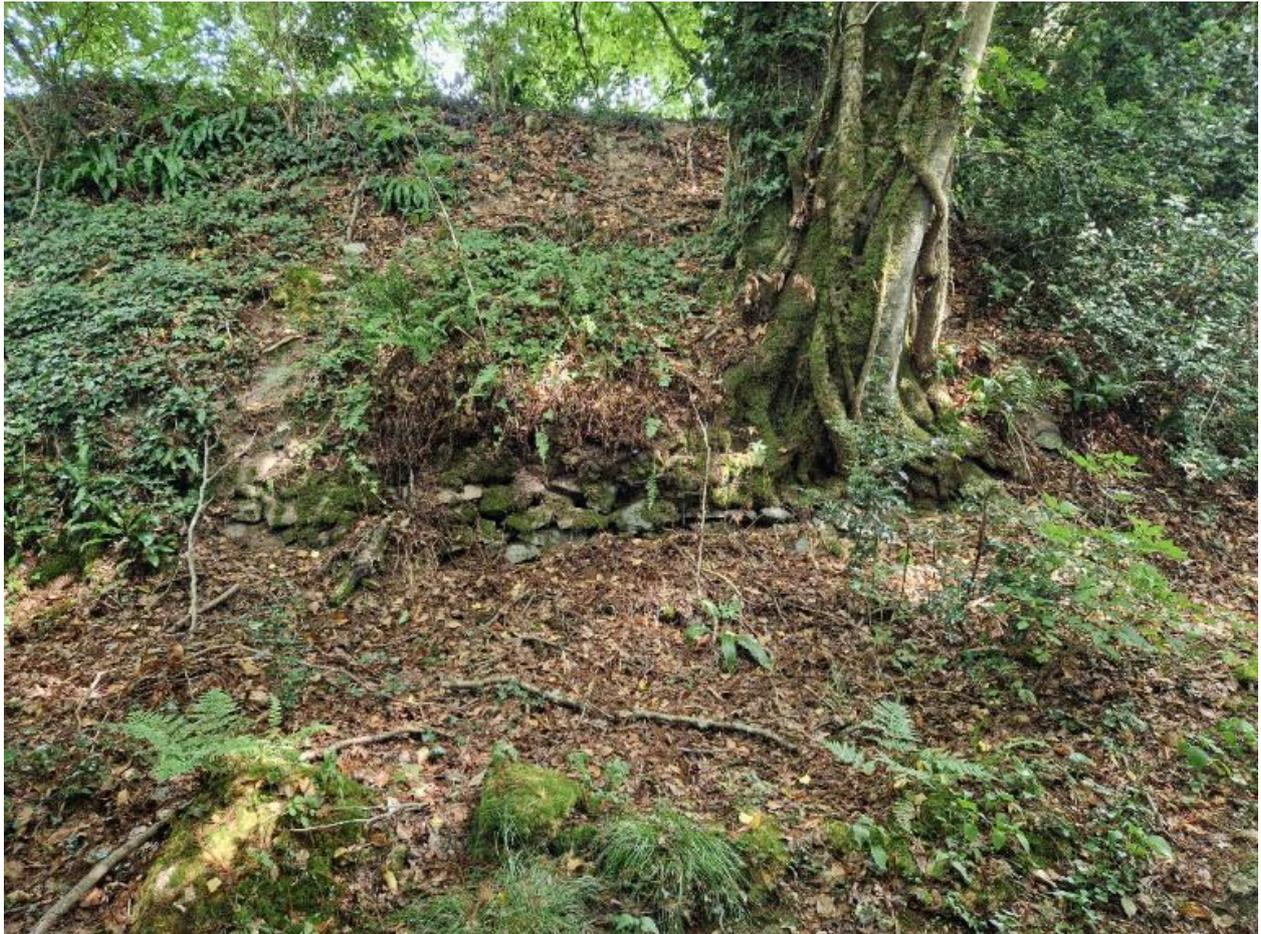
Vue de la contrescarpe à l'ouest en maçonnerie de moellon. En mauvais état, elle est masquée par la végétation
