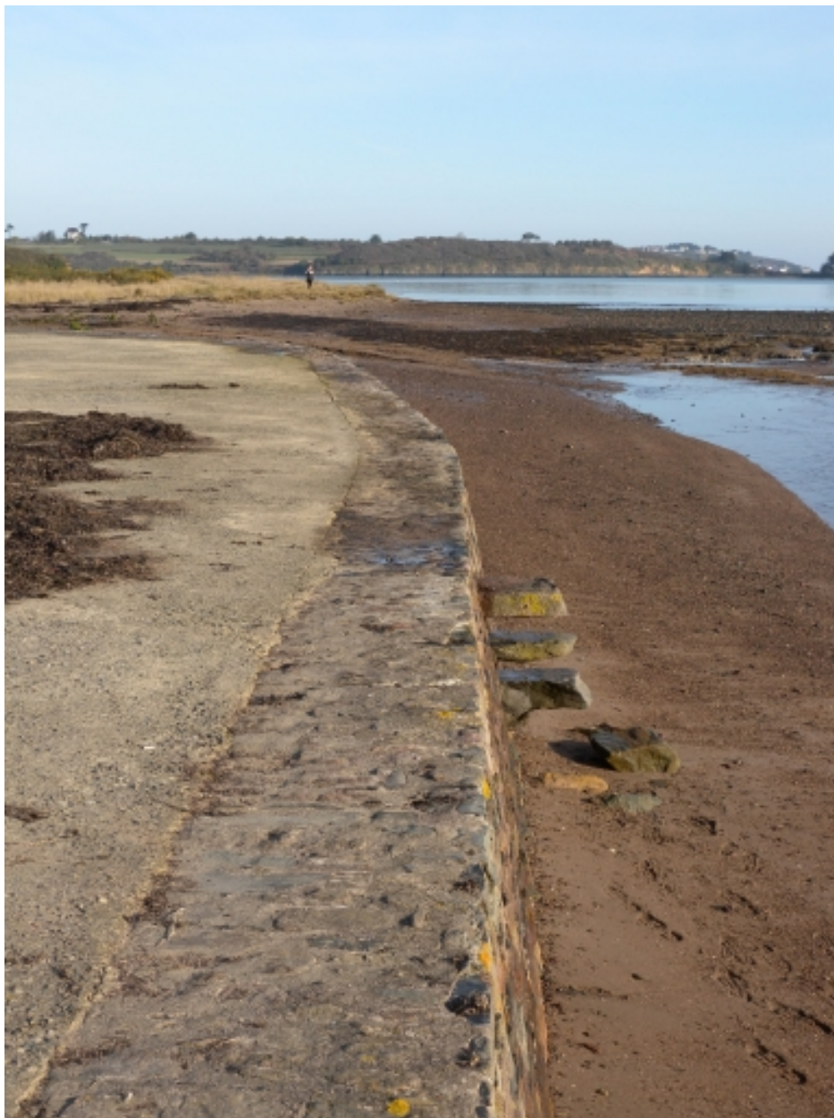
Vue de l'ancien quai rejointoillé
