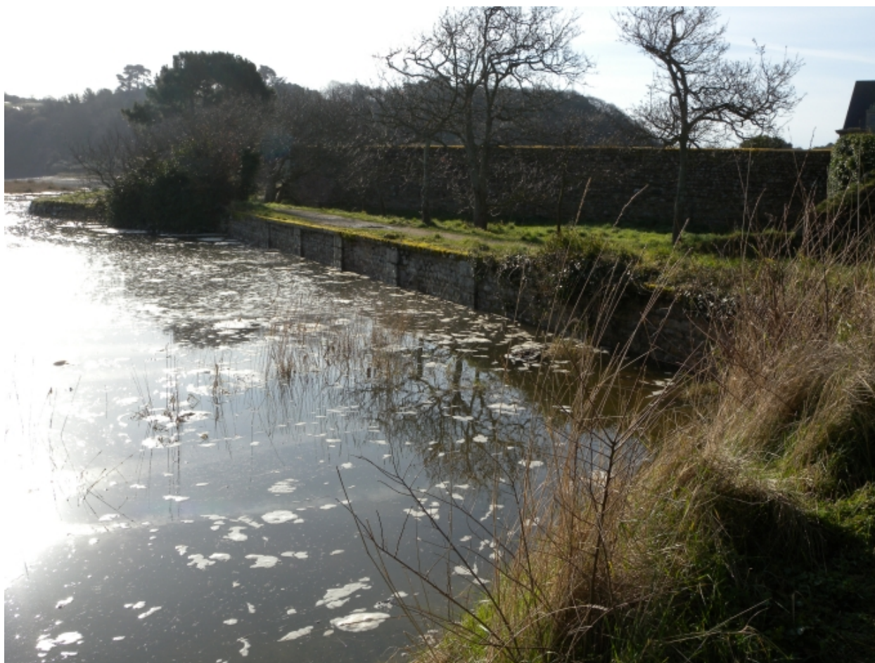
Vue de l'ancien mur de quai de défense littorale et de soutènement pour la voie ferrée
