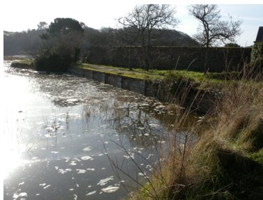
Vue de l'ancien mur de quai de défense littorale et de soutènement pour la voie ferrée Phot. Guy Prigent IVR53_20092212612NUCA
