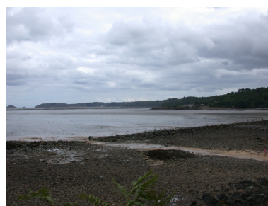
Vue générale des vestiges de la grande digue Phot. Guy Prigent IVR53_20092212630NUCA
