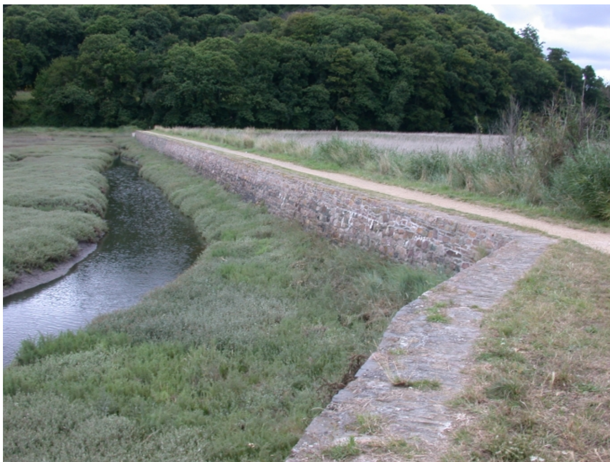
Vue de la digue (ou ancien quai) refait devant l'étier au Sud-Est de Beauport
