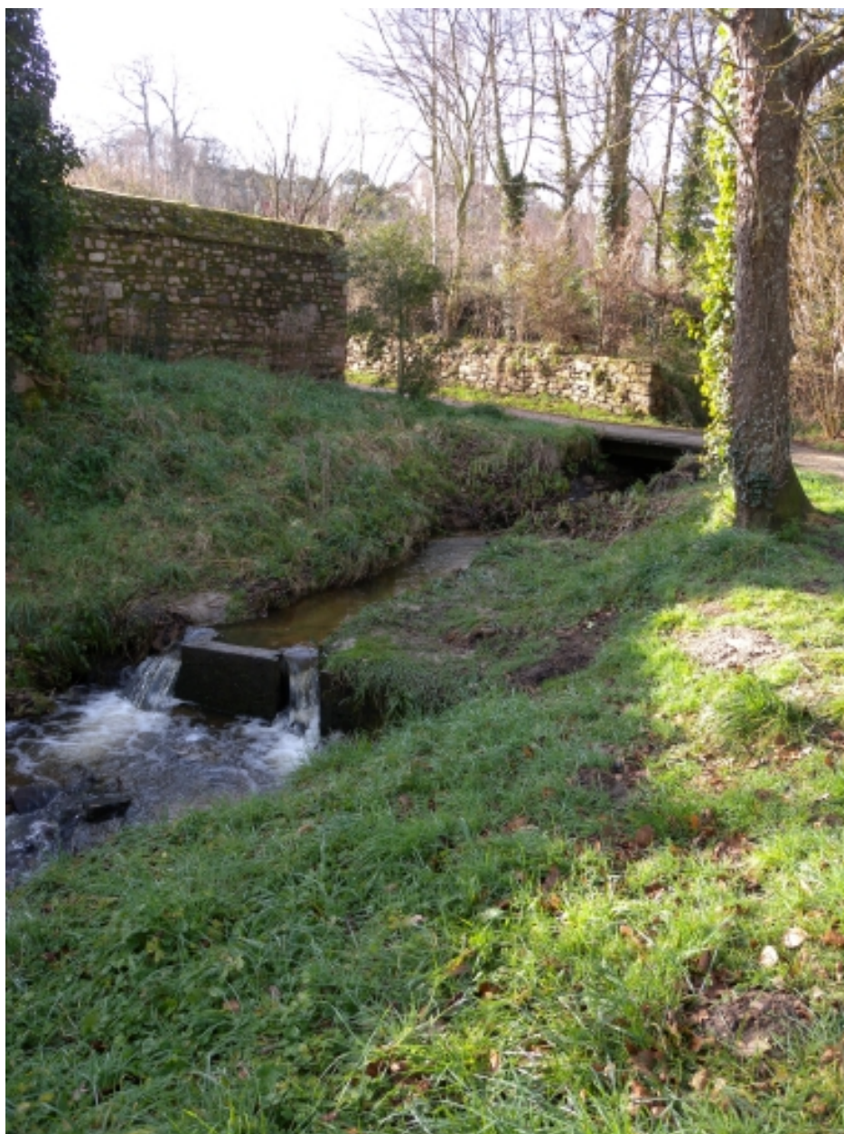
Vue des petits aménagements liés au circuit des eaux douces
