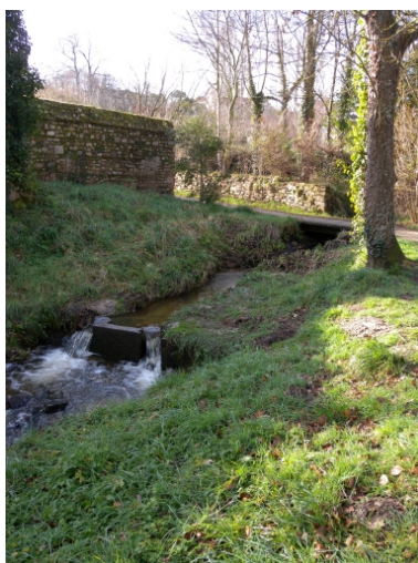
Vue des petits aménagements liés au circuit des eaux douces Phot. Guy Prigent IVR53_20092212615NUCA
