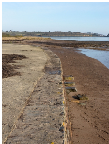
Vue de l'ancien quai rejointoillé Phot. Guy Prigent IVR53_20092212622NUCA
