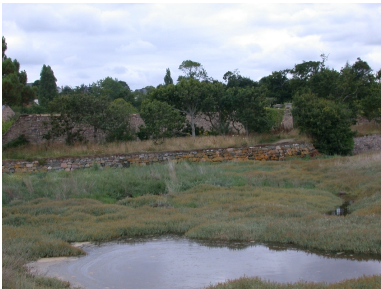
Vue des murs extérieurs de l'ancien quai dans le prolongement de la voie ferrée
