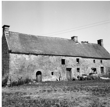
Maison II, parcelle 338 : vue d'ensemble de la façade sud Phot. Jean-Yves Veillard IVR53_19665600663X
