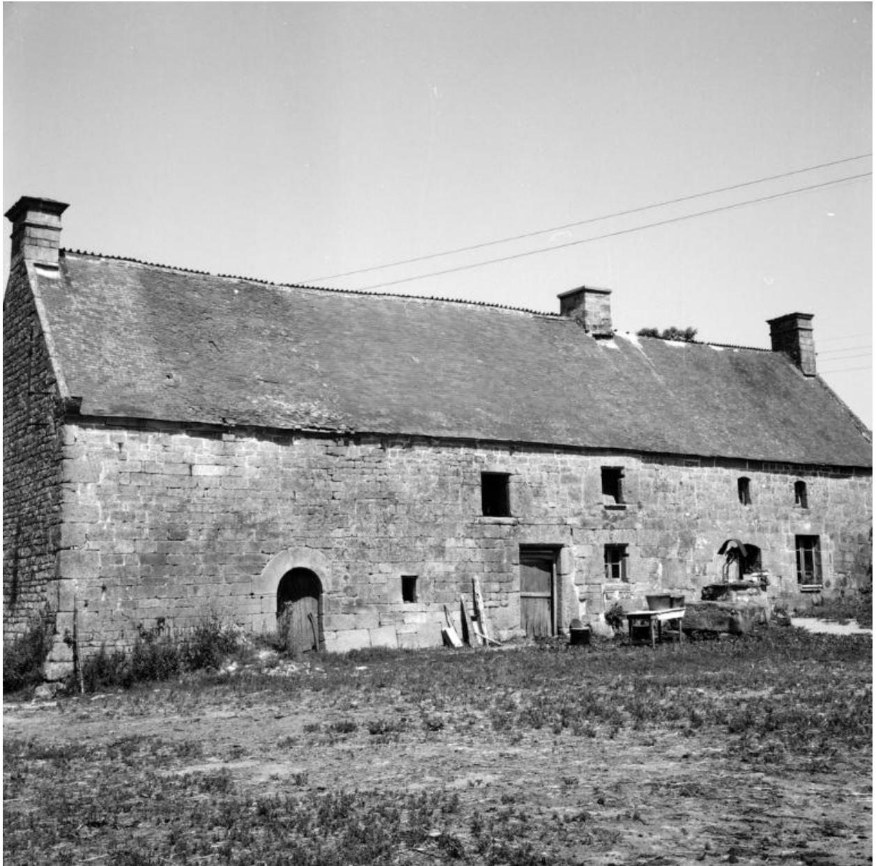
Maison II, parcelle 338 : vue d'ensemble de la façade sud
