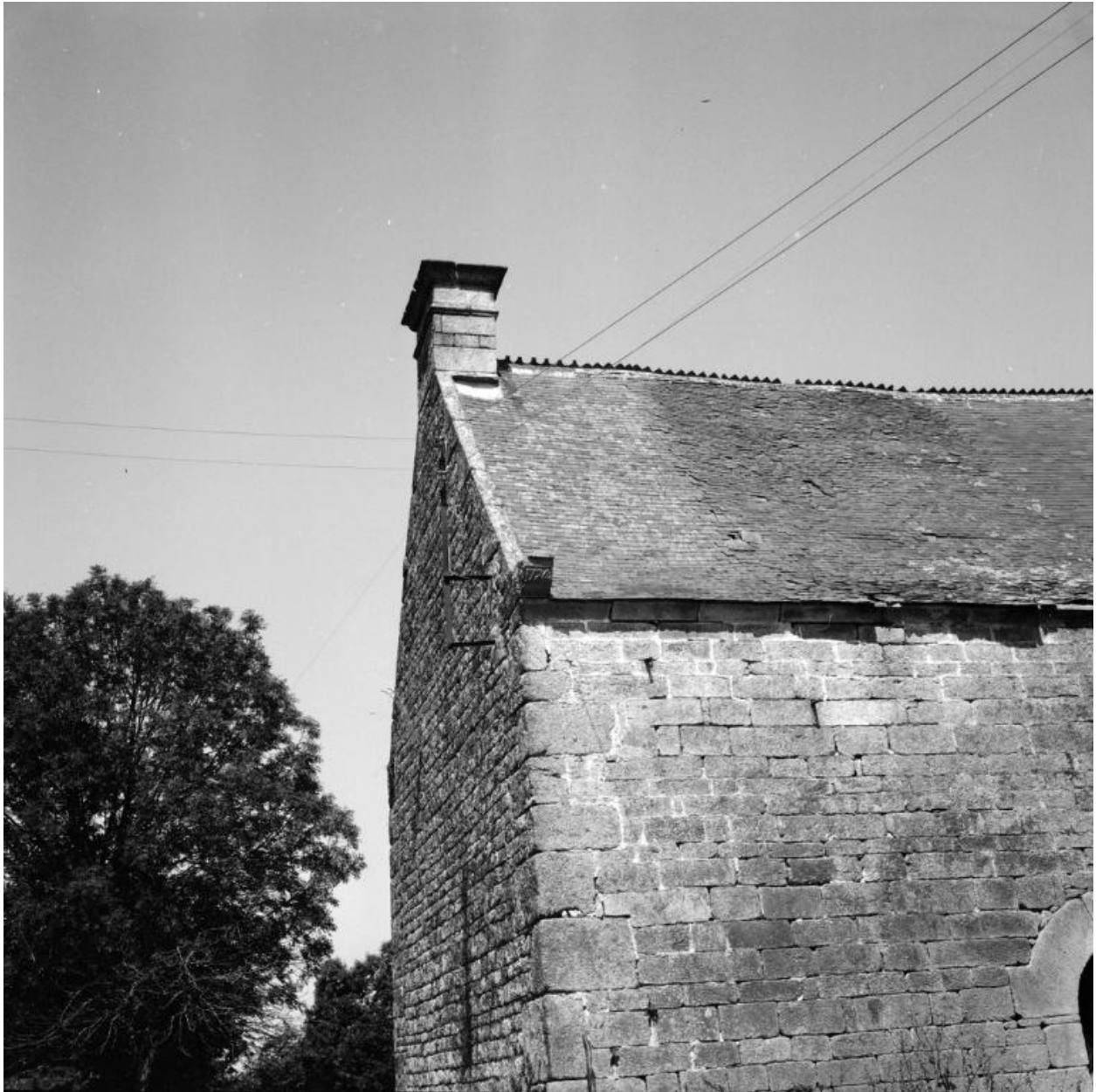
Maison II : détail de l'angle sud-ouest
