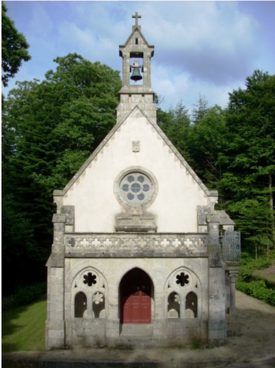
Plonéis, chapelle Sainte-Anne : élévation ouest
