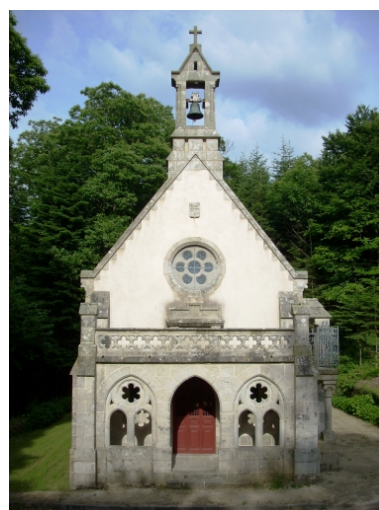
Plonéis, chapelle Sainte- Anne : élévation ouest Phot. Gwénaél Fauchille IVR53_20082906240NUCA
