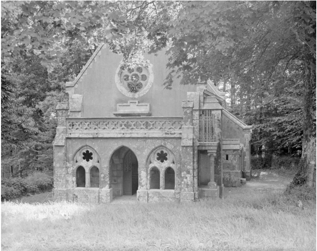
Plonéis, chapelle Sainte-Anne : vue générale de l'ensemble, état en 1983
