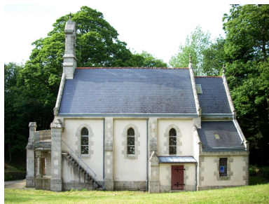
Plonéis, chapelle Sainte-Anne : élévation sud Phot. Gwénaél Fauchille IVR53_20082906241NUCA
