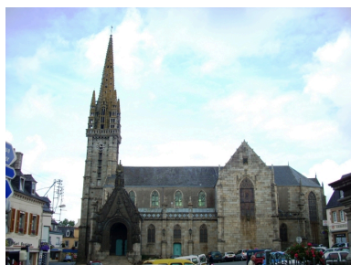
Landivisiau, église paroissiale Saint-Thuriau : élévation sud Phot. Gwénaél Fauchille IVR53_20082906504NUCA
