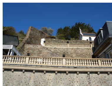
Vue des escaliers et des terrasses ouvragées conduisant à la chapelle 'Sous-la-Tour' Phot. Guy Prigent IVR53_20082213220NUCA
