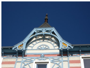
Vue de détail d'une façade d'habitation du type architecture balnéaire : remarquer le placage en bois ouvragé au niveau des ouvertures et l'épi de faîtage Phot. Guy Prigent IVR53_20082213223NUCA
