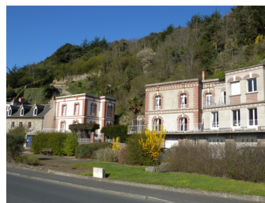
Vue du bâti littoral résidentiel 'Sous-la-Tour' : remarquer les toits en terrasse Phot. Guy Prigent IVR53_20082213227NUCA
