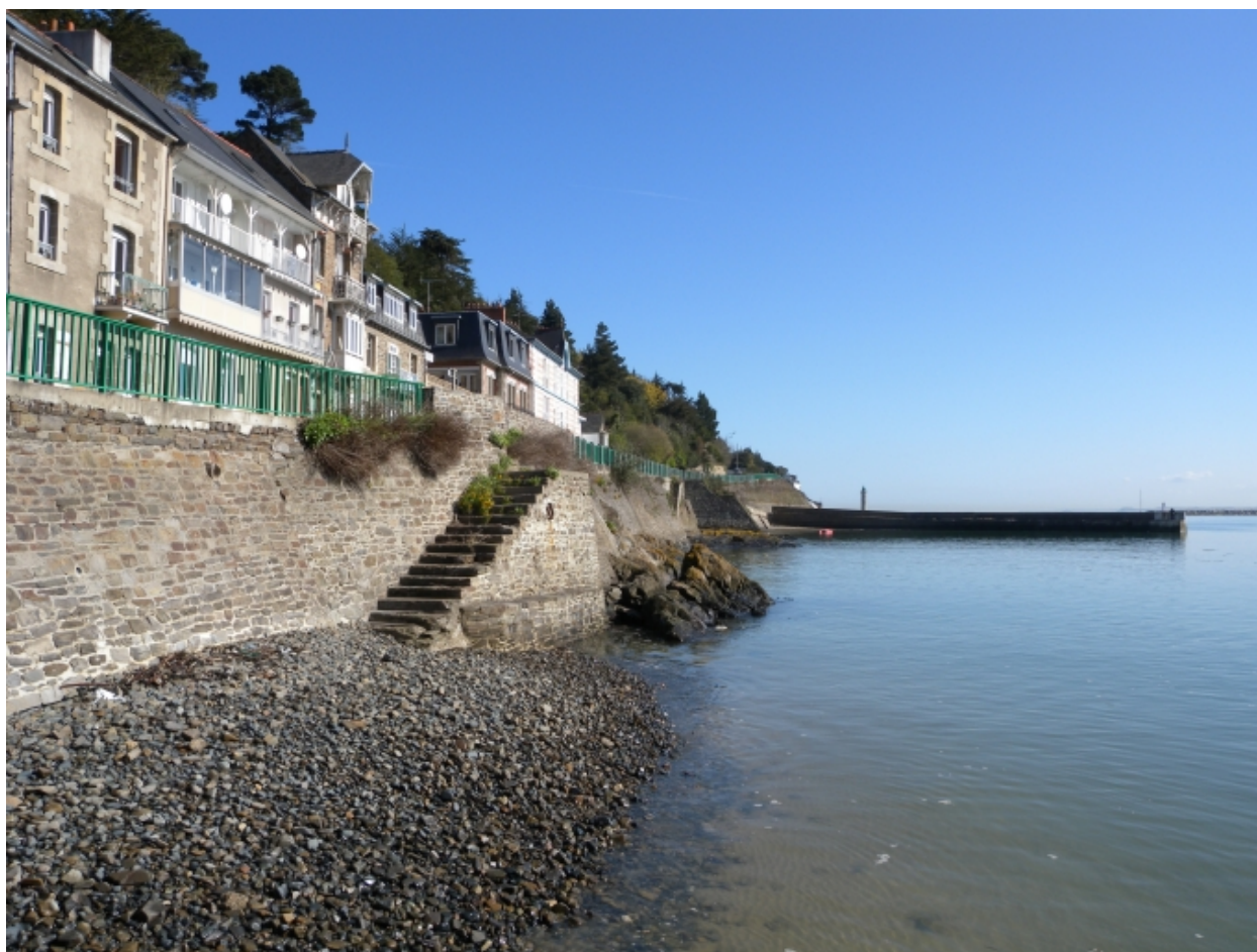
Vue des murs de soutènement et des escaliers de desserte à la grève sous le phare
