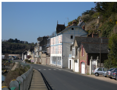
Vue du bâti littoral résidentiel 'Sous-la-Tour', en allant vers la corniche et le Chemin du phare Phot. Guy Prigent IVR53_20082213219NUCA
