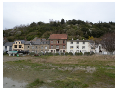
Vue du bâti littoral résidentiel 'Sous-la-Tour' Phot. Guy Prigent IVR53_20082213217NUCA
