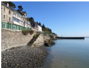
Vue des murs de soutènement et des escaliers de desserte à la grève sous le phare Phot. Guy Prigent IVR53_20082213229NUCA
