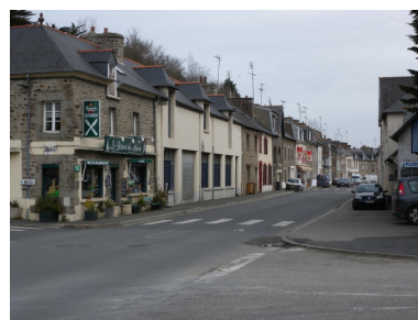
Vue générale du quartier en front de mer de 'Sous-la-Tour' Phot. Guy Prigent IVR53_20082213212NUCA
