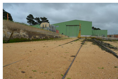
Chantier Sibiril Technologies, Grande Grève à Carantec Phot. Céline Perrine IVR53_20162905970NUCA
