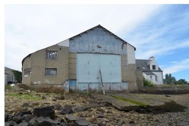
Chantier Rolland Marine, Diben à Plougasnou Phot. Céline Perrine IVR53_20162905973NUCA
