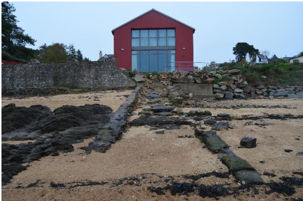
Chantier Ernest Sibiril, Ancien hangar réhabilité en gîte, Rue Duguay Trouin Carantec
