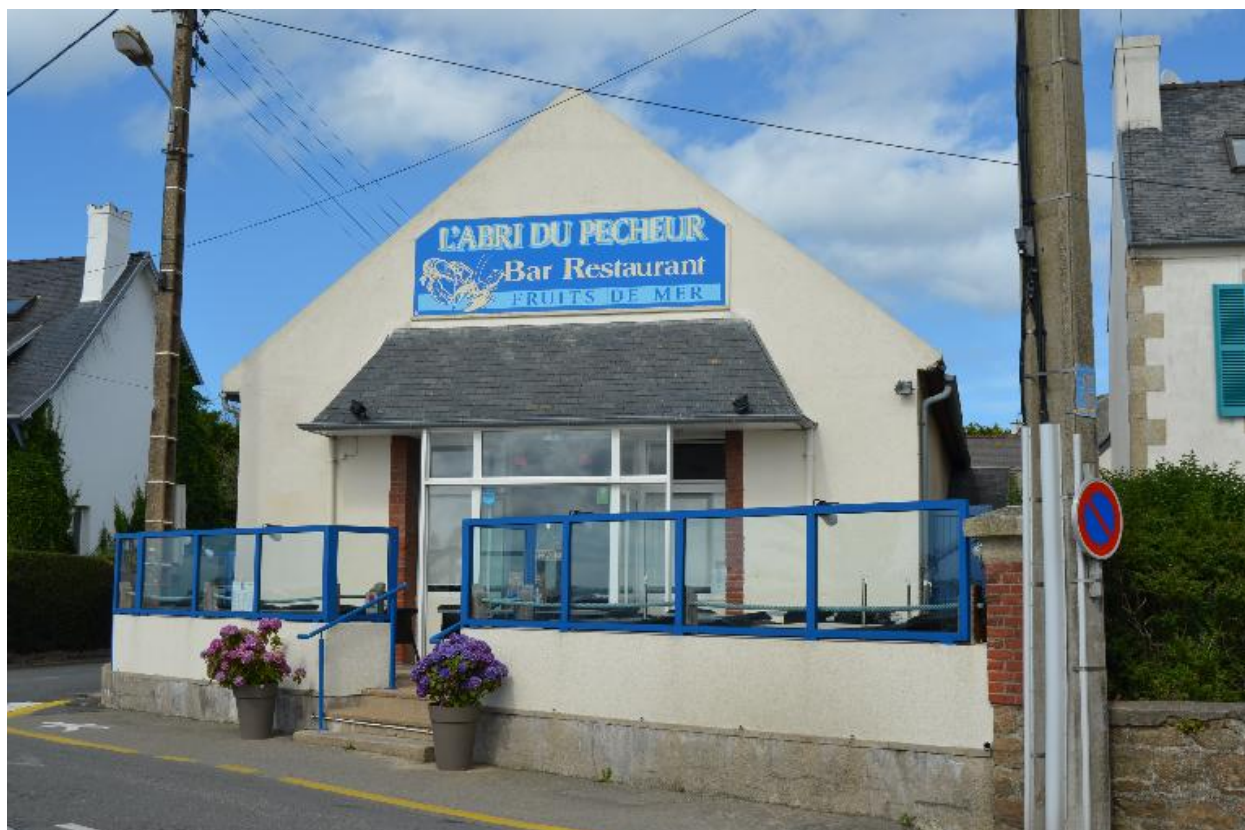
Chantier Eliès, ancien hangar, Port de Carantec
