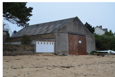
Chantier Moguérou, actuel Chantier Jézéquel, Port de Carantec Phot. Céline Perrine IVR53_20162905967NUCA
