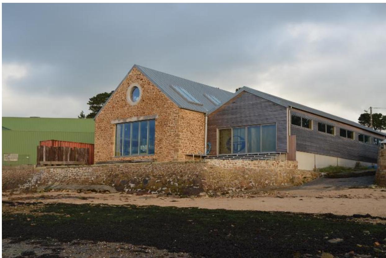
Chantier Ernest Sibiril, Ancien hangar, Grande Grève, Carantec
