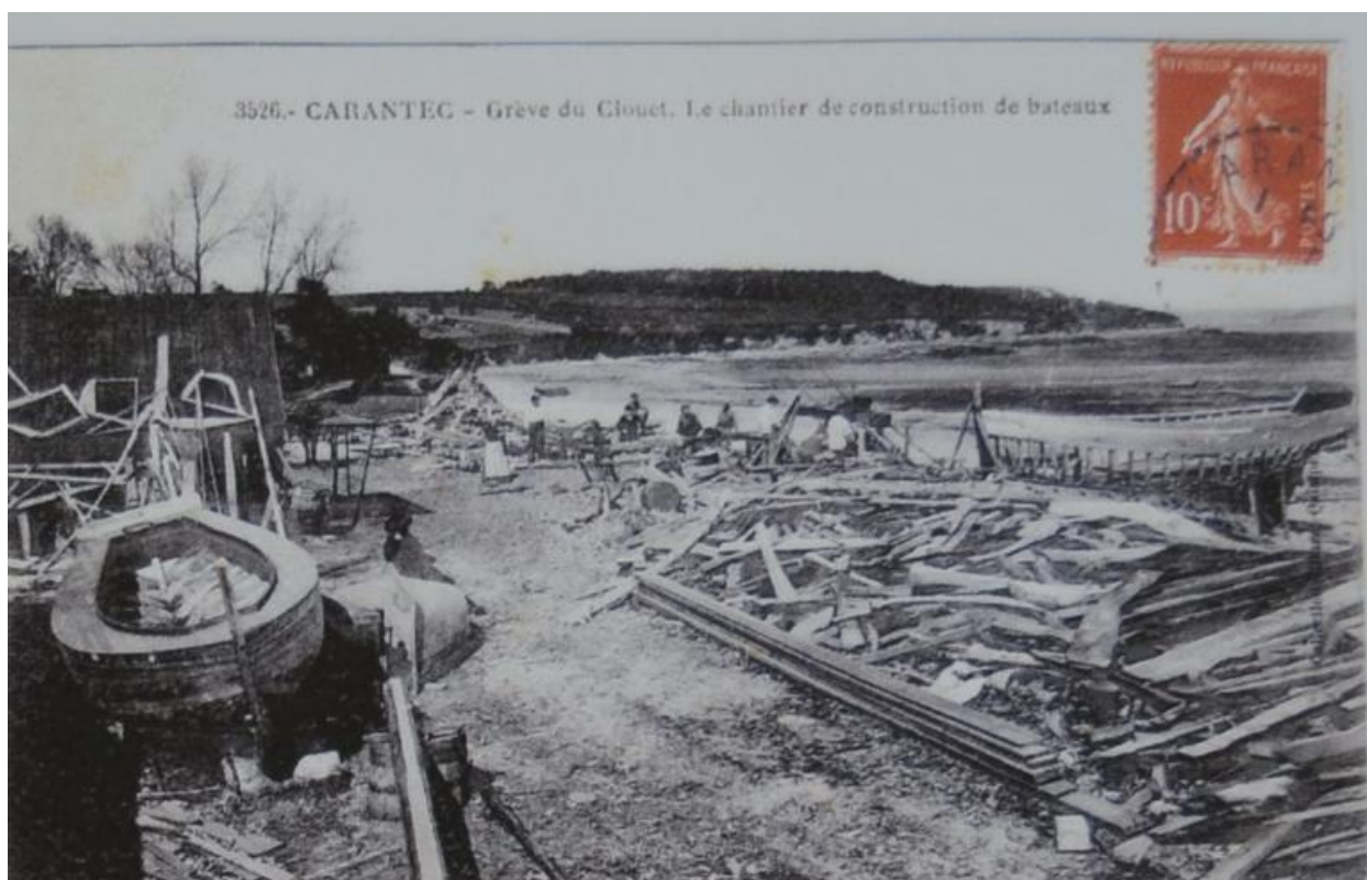
Chantier Pauvy, Clouët à Carantec
