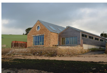
Chantier Ernest Sibiril, Ancien hangar, Grande Grève, Carantec Phot. Céline Perrine IVR53_20162905969NUCA
