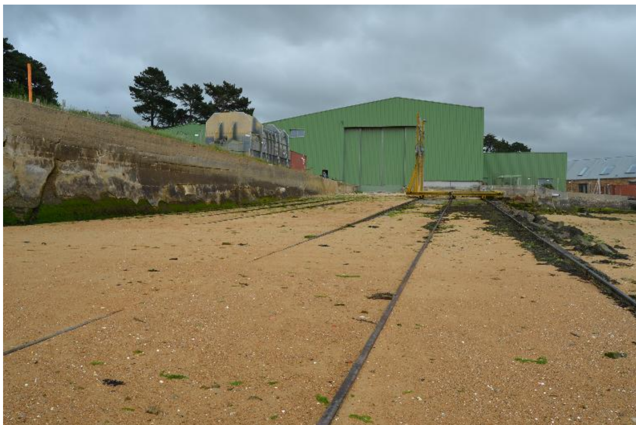
Chantier Sibiril Technologies, Grande Grève à Carantec
