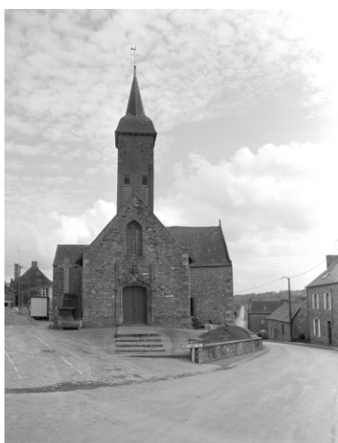
Vue générale de la façade principale Repro. Guy Artur, Repro. Norbert Lambart IVR53_19943500782X
