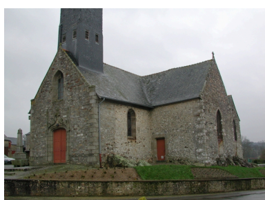
Façade latérale sud
