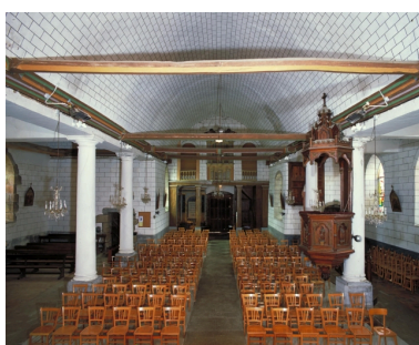
Vue intérieure prise du choeur vers la nef Phot. Frédéric Jouet IVR53_20013501034XA
