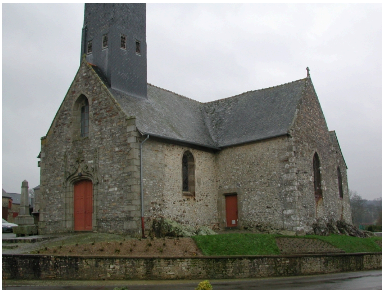
Façade latérale sud
