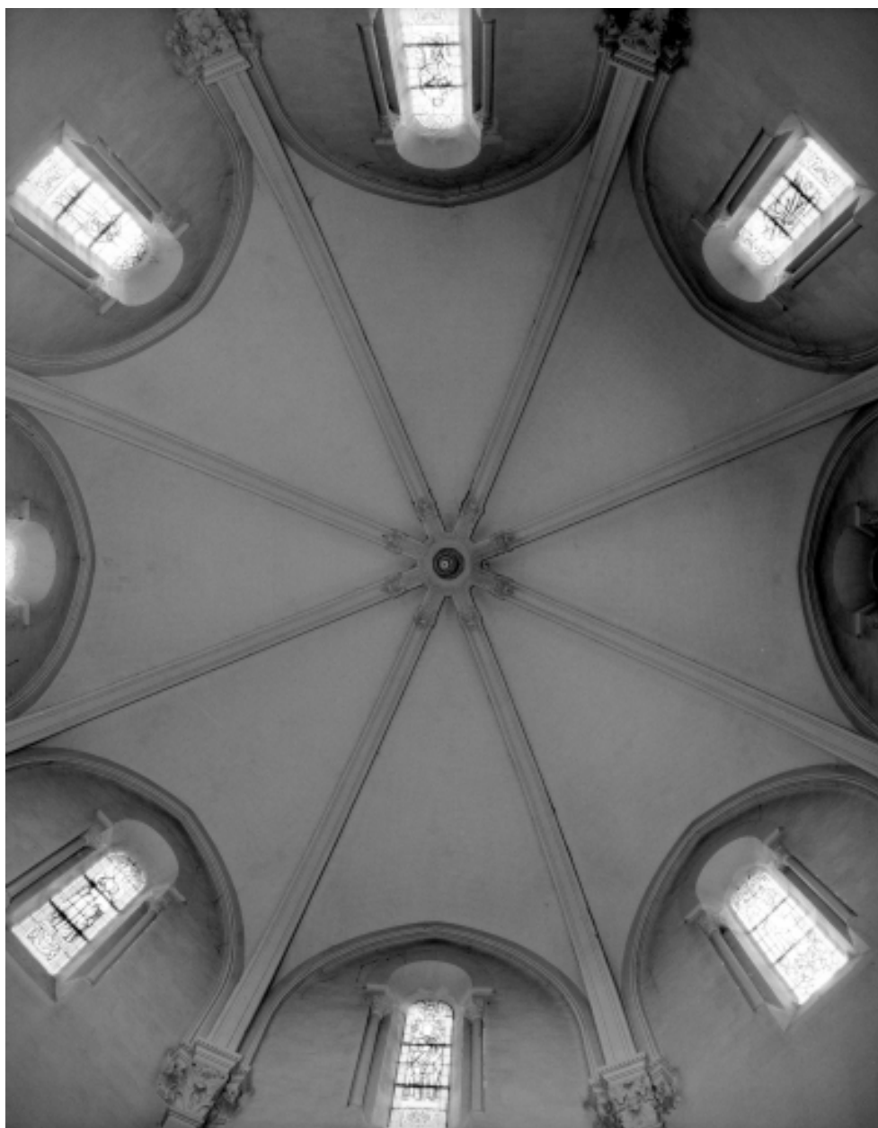
Intérieur, nef, voûtement : vue générale
