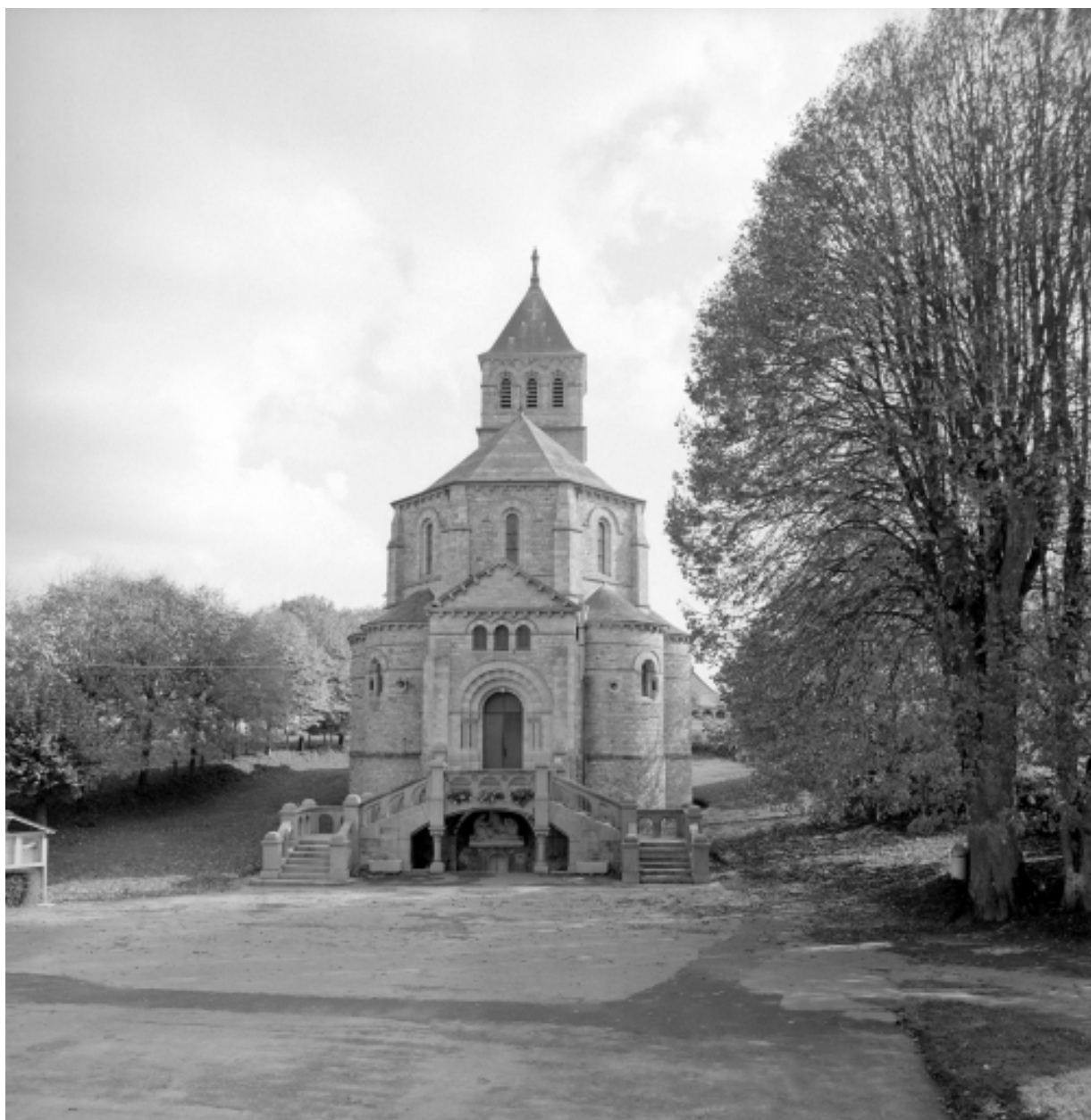
Elévation Ouest : vue de situation
