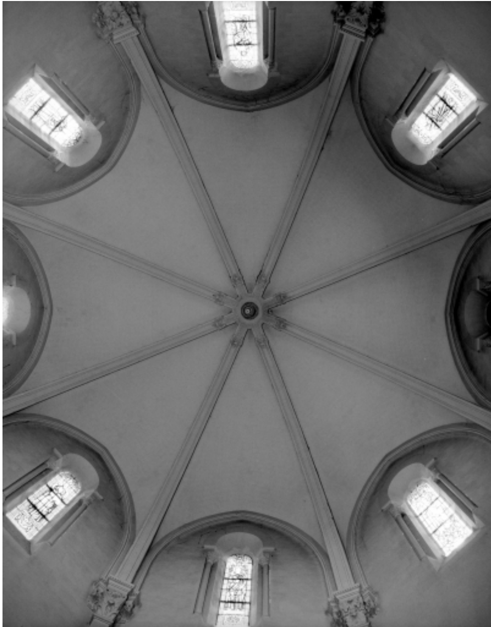
Intérieur, nef, voûtement : vue générale
