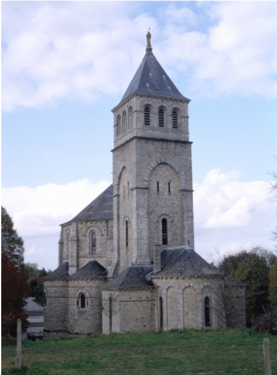
Elévation Est : vue générale
