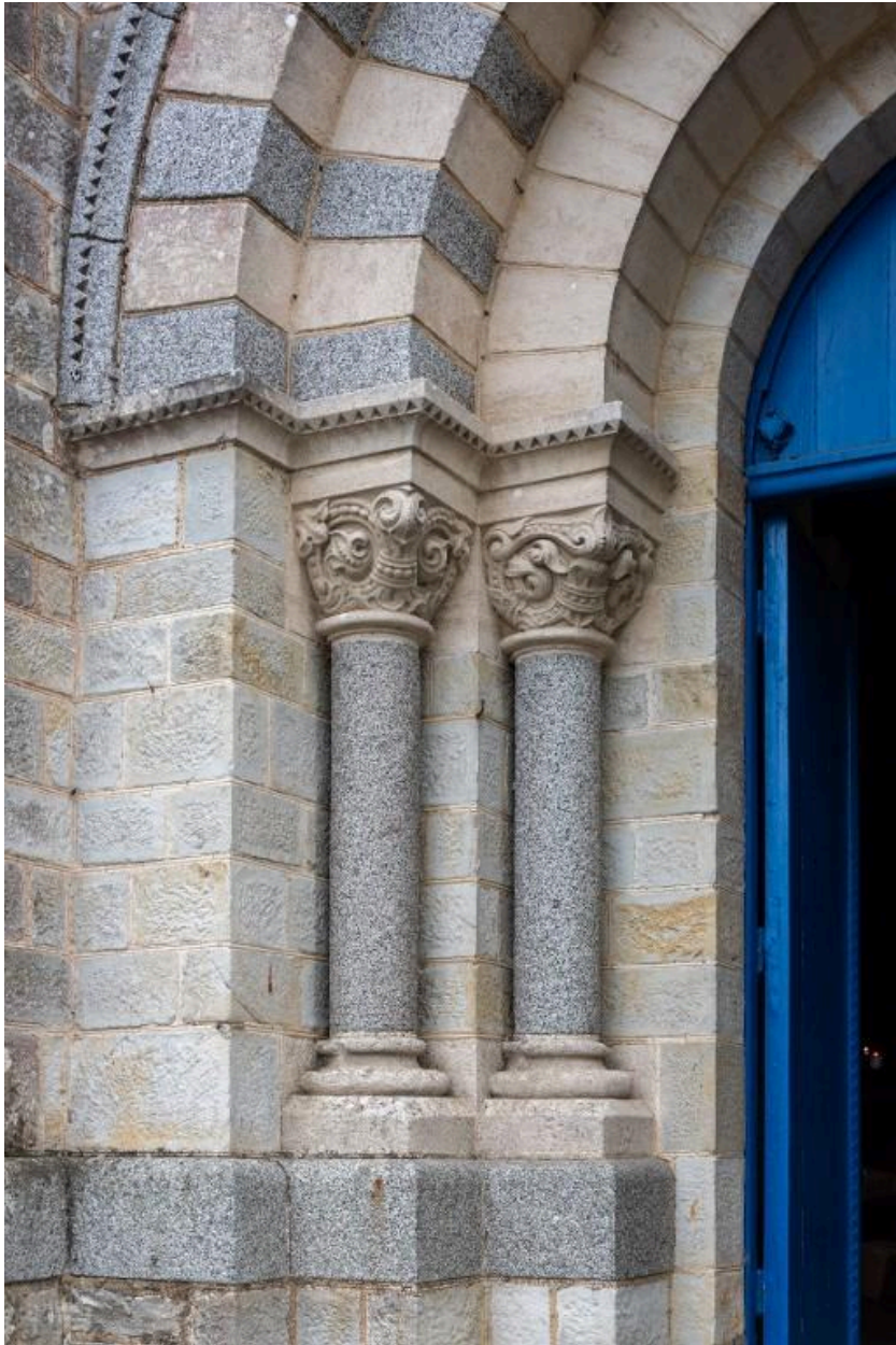
Détail des colonnes de l'ébrasement du porche d'entrée de la chapelle
