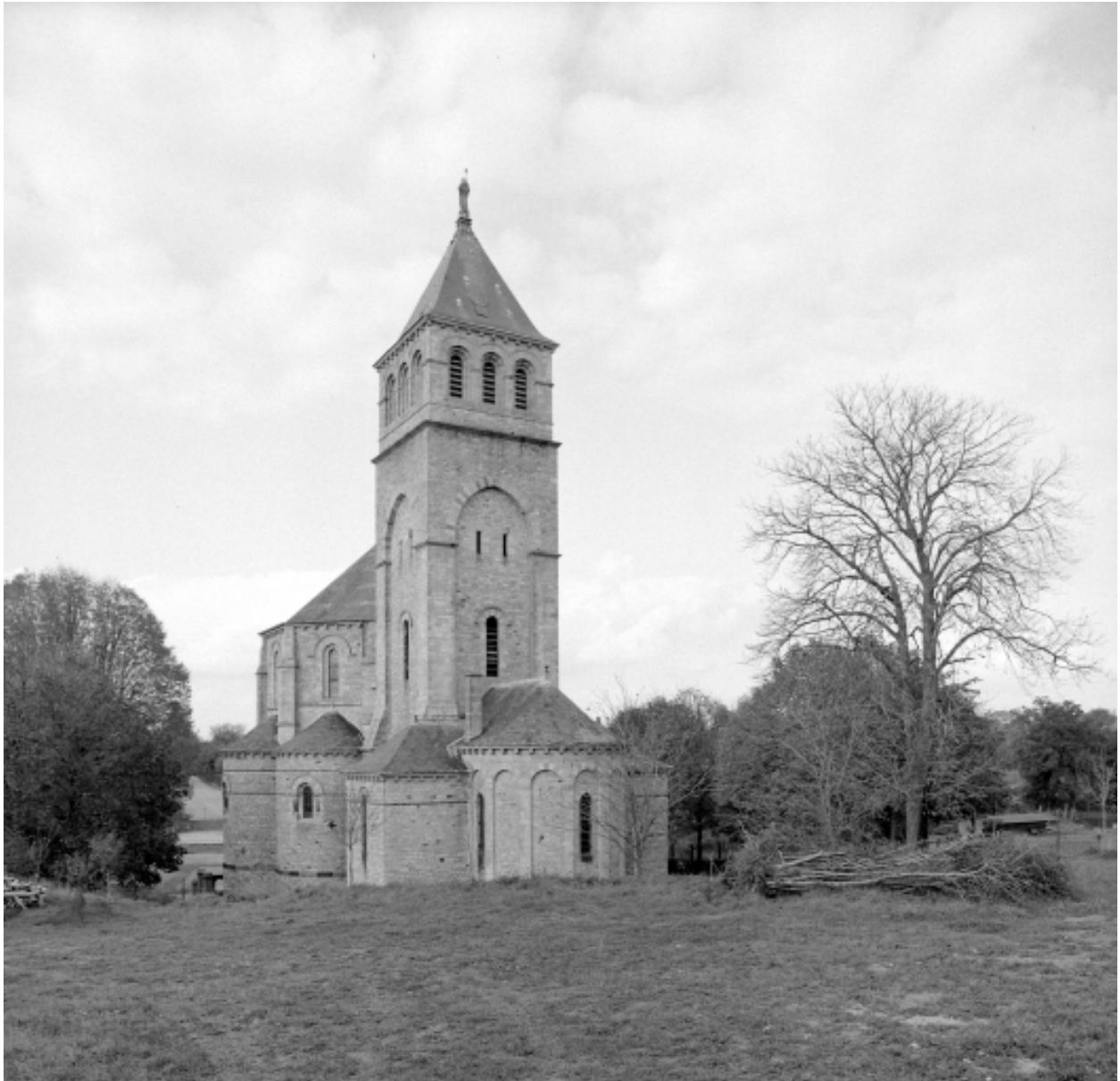
Elévation Est : vue générale
