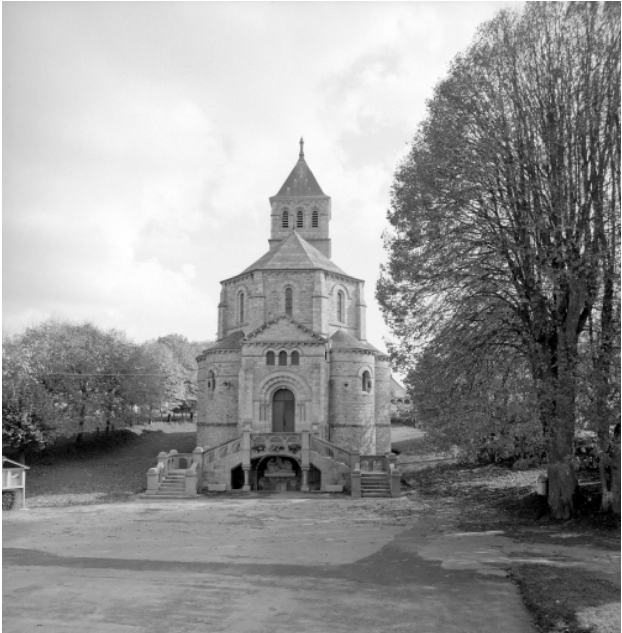
Elévation Ouest : vue de situation
