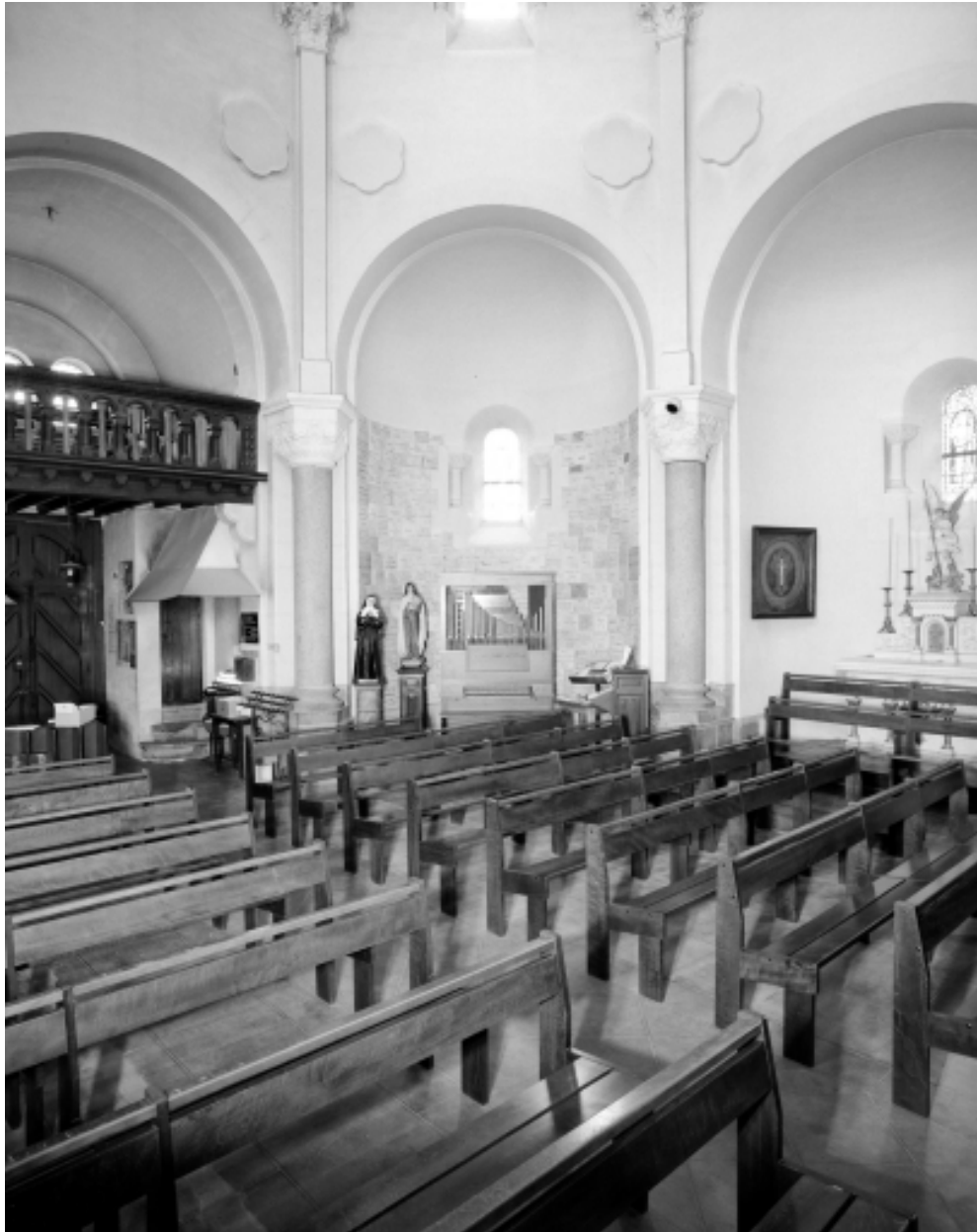
Intérieur, nef : vue générale de 3/4
