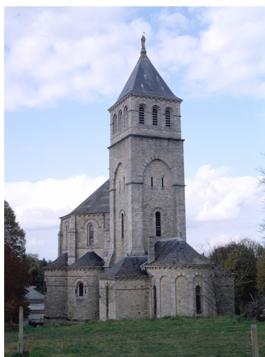
Elévation Est : vue générale Phot. Bernard Bègne, Phot. M. Loyon IVR53_19933500421XA
