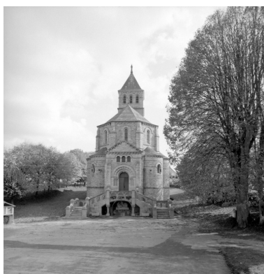
Elévation Ouest : vue de situation Phot. Bernard Bègne, Phot. M. Loyon IVR53_19923500879X
