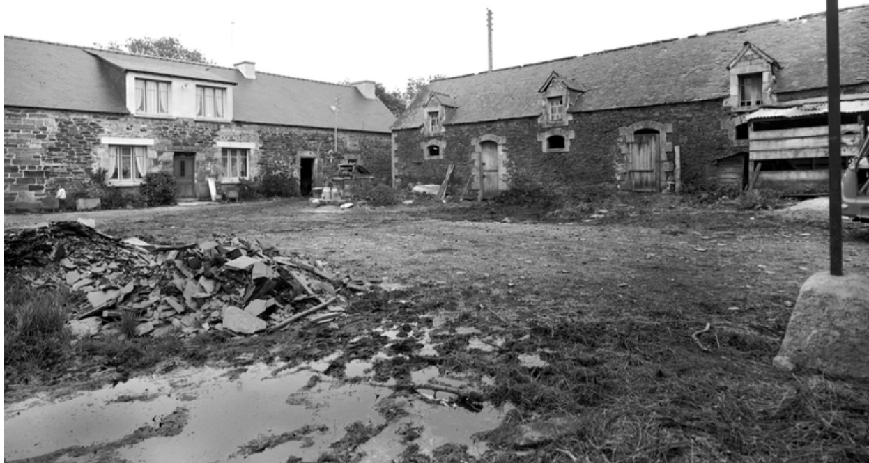
Vue générale du bâtiment avec le puits
