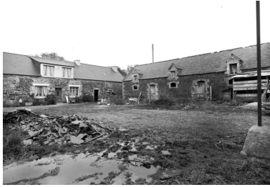
Vue générale du bâtiment avec le puits Phot. François Dagorn IVR53_19662200416V
