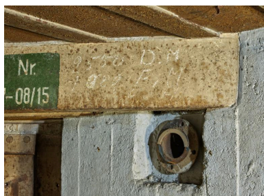
Vue de la chambre de combat : linteau du poste de tir et tuyau du système de ventilation (le clapet de surpression a disparu). On peut lire l'inscription écrite à la craie : 2550 D.M ; 1080 F.M Phot. Bernard Bègne
