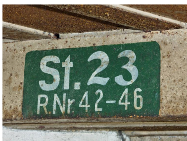
Vue de la chambre de combat : l'un des deux cartouches avec marquage. On peut lire : St. 23 R.Nr. 42-46 Phot. Bernard Bègne IVR53_20235600725NUCA
