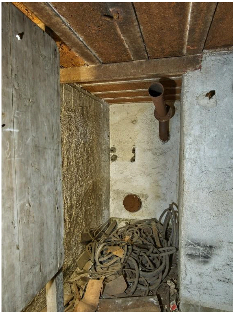
Vue de la chambre de combat : face à l'entrée, emplacement du système de ventilation
