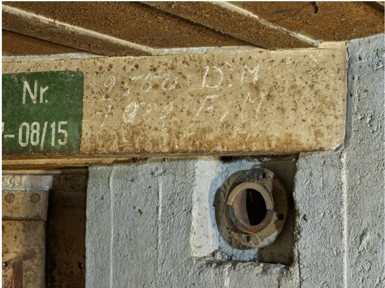
Vue de la chambre de combat : linteau du poste de tir et tuyau du système de ventilation (le clapet de surpression a disparu). On peut lire l'inscription écrite à la craie : 2550 D.M ; 1080 F.M
