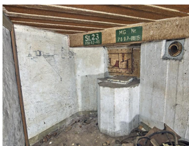
Vue de la chambre de combat : support d'affût de la mitrailleuse et créneau blindé. Au-dessus du poste de tir, cartouches avec marquage. A gauche, panorama et instruction de tir. A droite, tuyau du système de ventilation Phot. Bernard Bègne IVR53_20235600719NUCA
