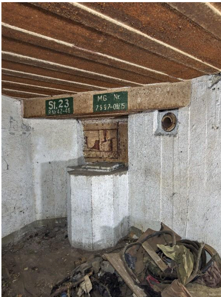
Vue de la chambre de combat : support d'affût de la mitrailleuse et créneau blindé. Au-dessus du poste de tir, deux cartouches avec marquage. A droite, tuyau du système de ventilation (le clapet de surpression a disparu)
