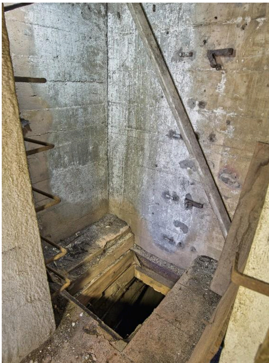
Vue du puits vertical : doté d'échelons, il permet à la fois l'accès à la casemate aménagée au-dessus de la porte sud-est du bunker KIII et à la galerie technique du bunker KIII
