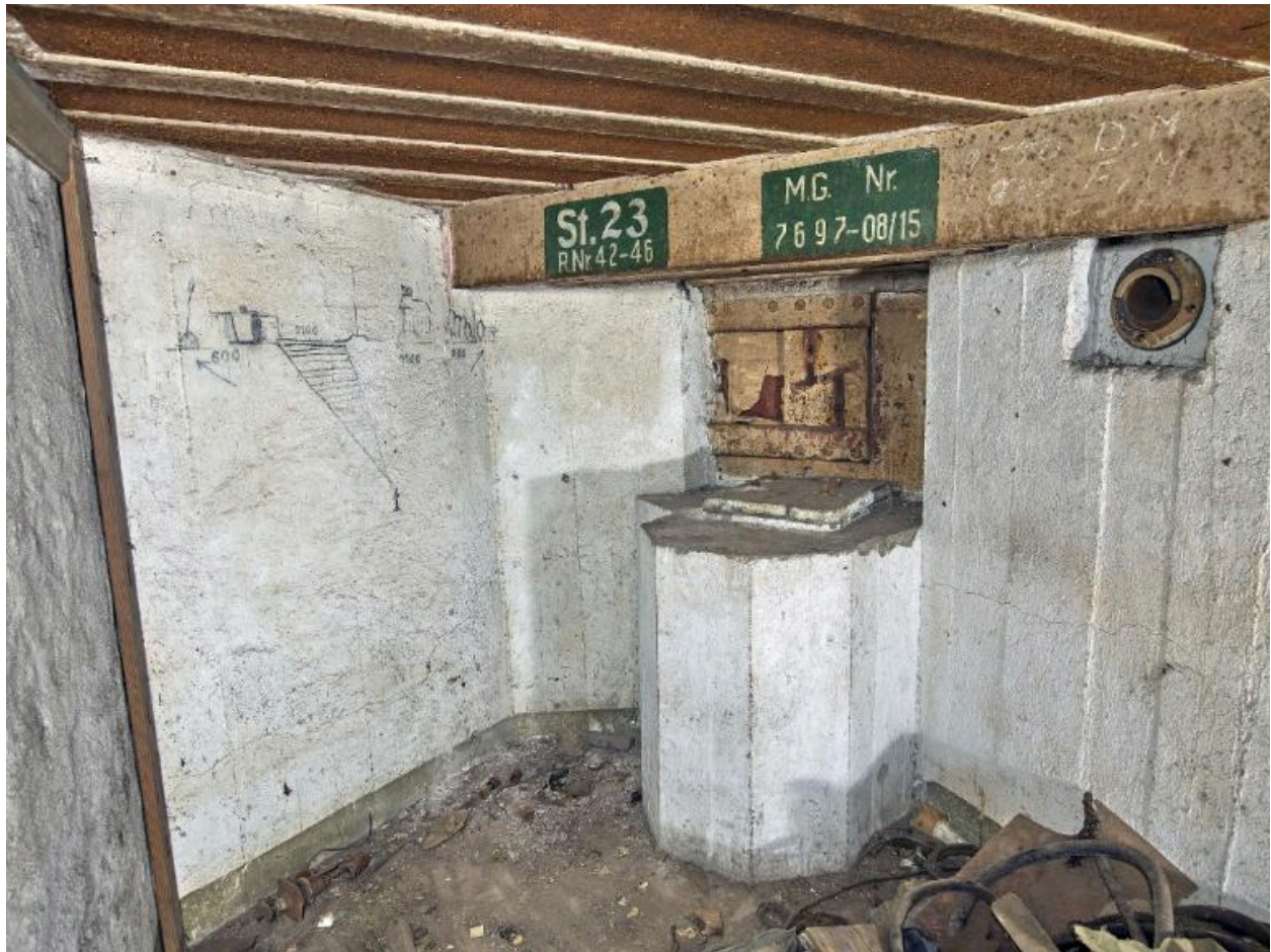
Vue de la chambre de combat : support d'affût de la mitrailleuse et créneau blindé. Au-dessus du poste de tir, cartouches avec marquage. A gauche, panorama et instruction de tir. A droite, tuyau du système de ventilation
