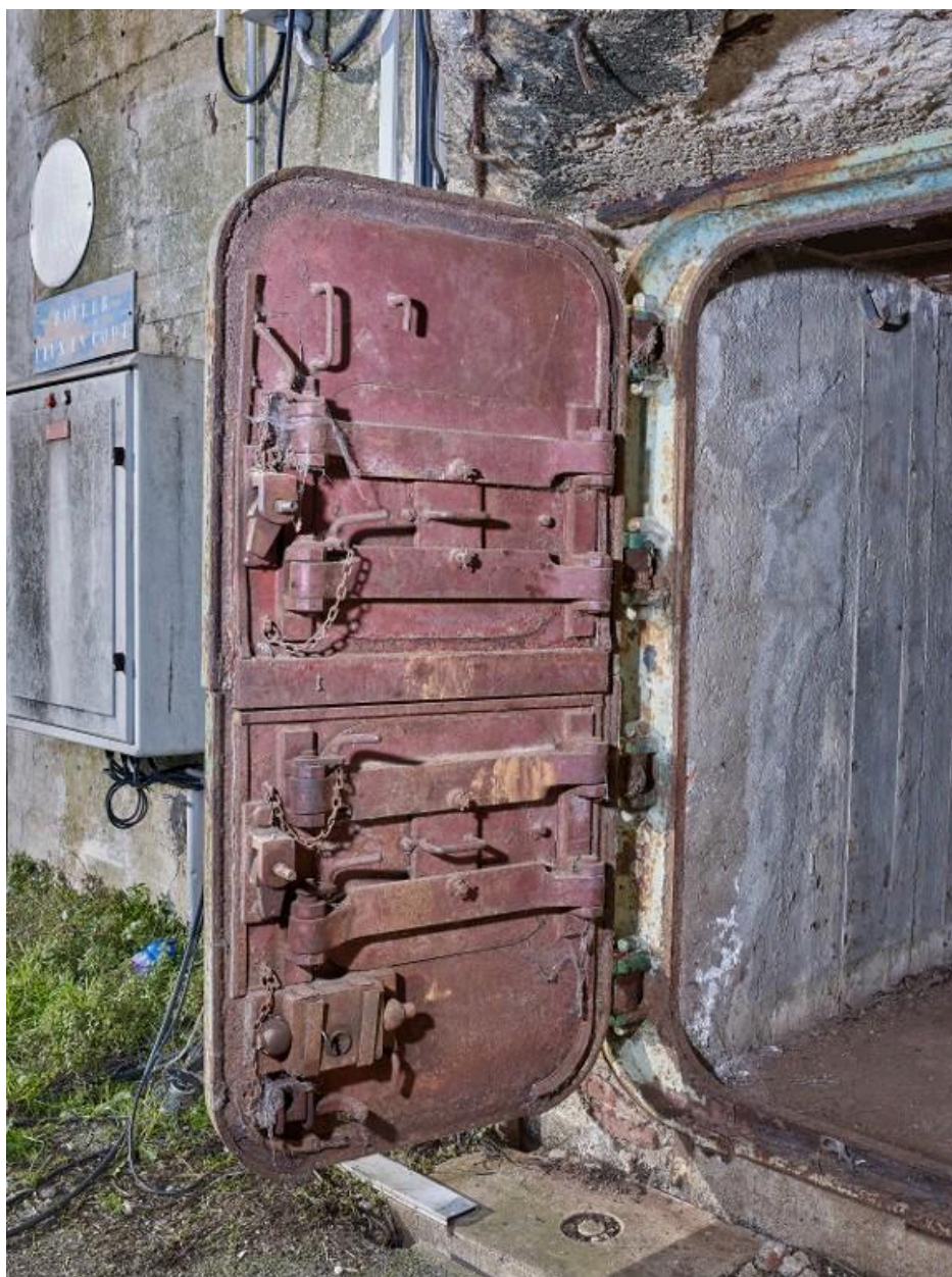
Vue de l'entrée : porte blindée à deux vantaux (ouverte)
