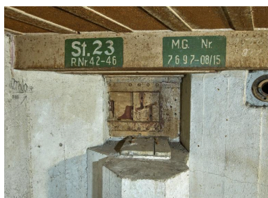
Vue de la chambre de combat : support d'affût de la mitrailleuse et créneau blindé. Au-dessus du poste de tir, deux cartouches avec marquage. A droite, tuyau du système de ventilation (le clapet de surpression a disparu) Phot. Bernard Bègne IVR53_20235600722NUCA
