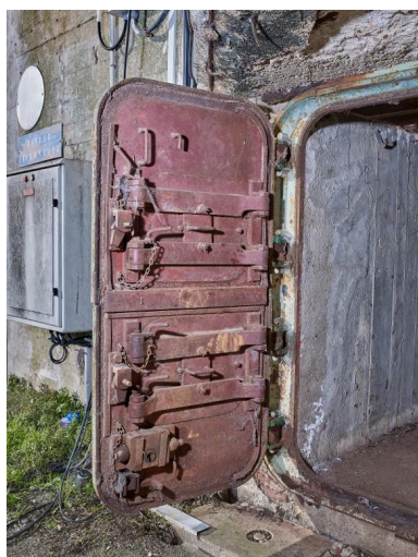
Vue de l'entrée : porte blindée à deux vantaux (ouverte) Phot. Bernard Bègne IVR53_20235600731NUCA
