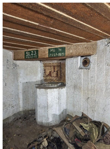
Vue de la chambre de combat : support d'affût de la mitrailleuse et créneau blindé. Au-dessus du poste de tir, deux cartouches avec marquage. A droite, tuyau du système de ventilation (le clapet de surpression a disparu) Phot. Bernard Bègne IVR53_20235600720NUCA
