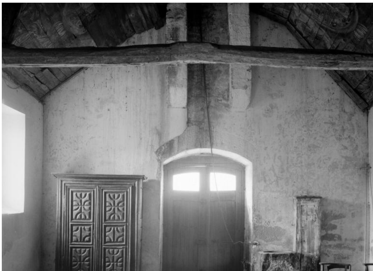
Nef : vue d'ensemble du mur ouest
