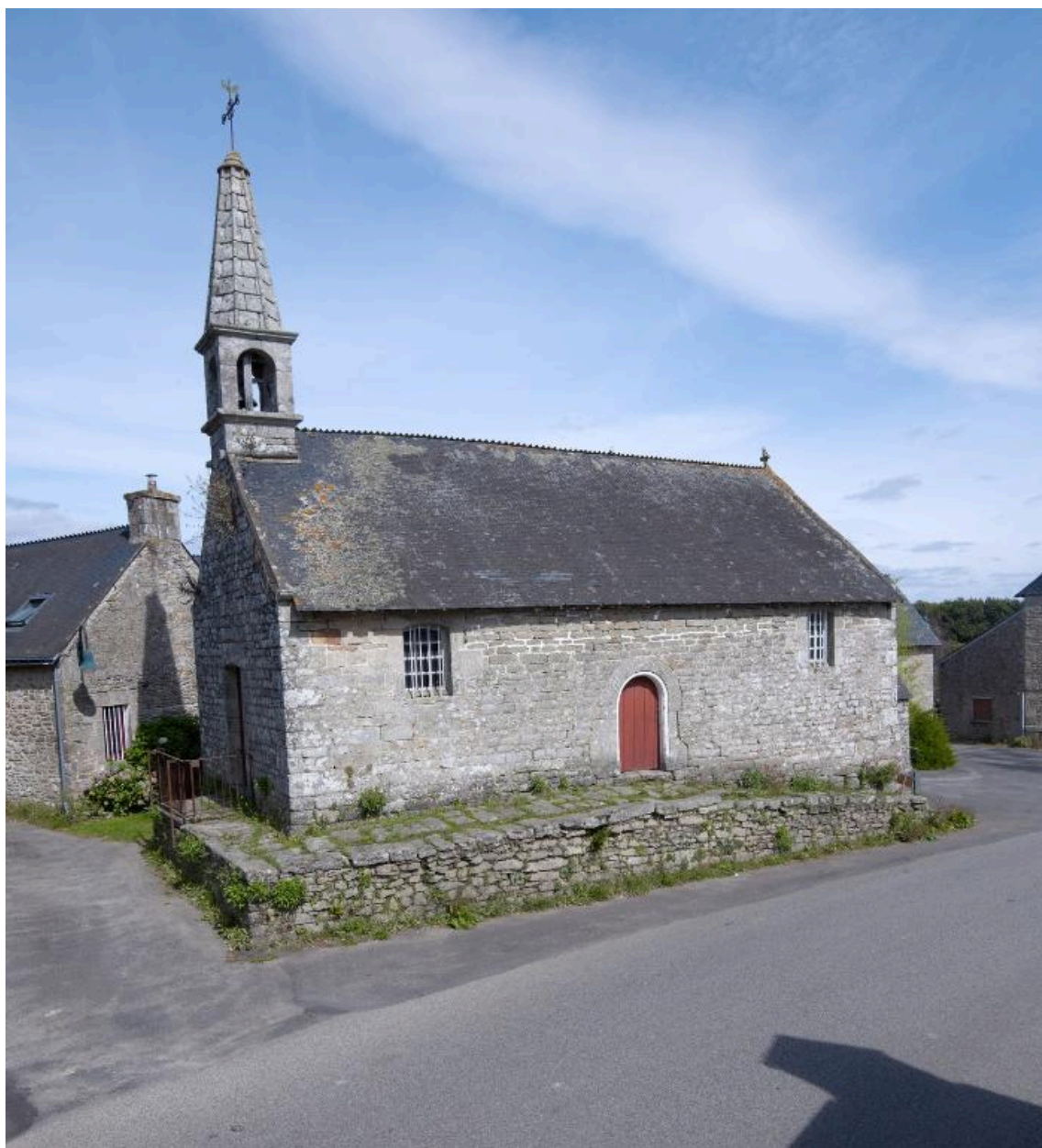
La façade sud de la chapelle
