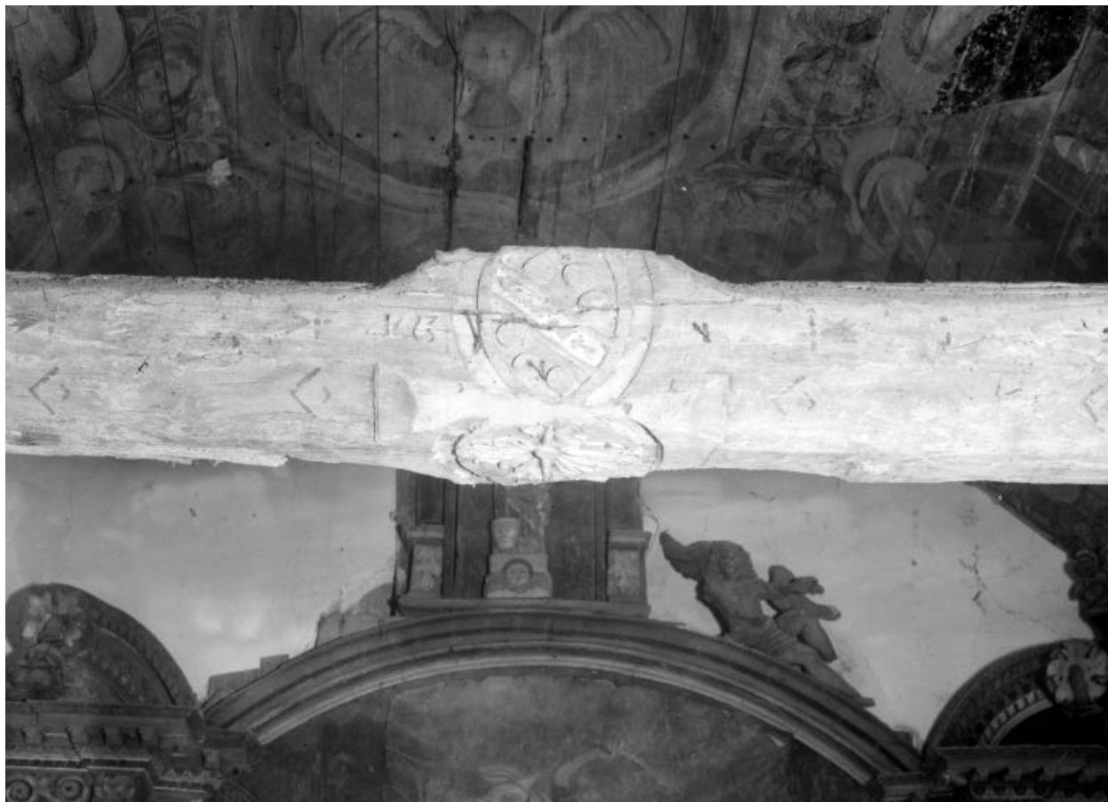
Charpente : détail d'un entrain armorié daté 1623
