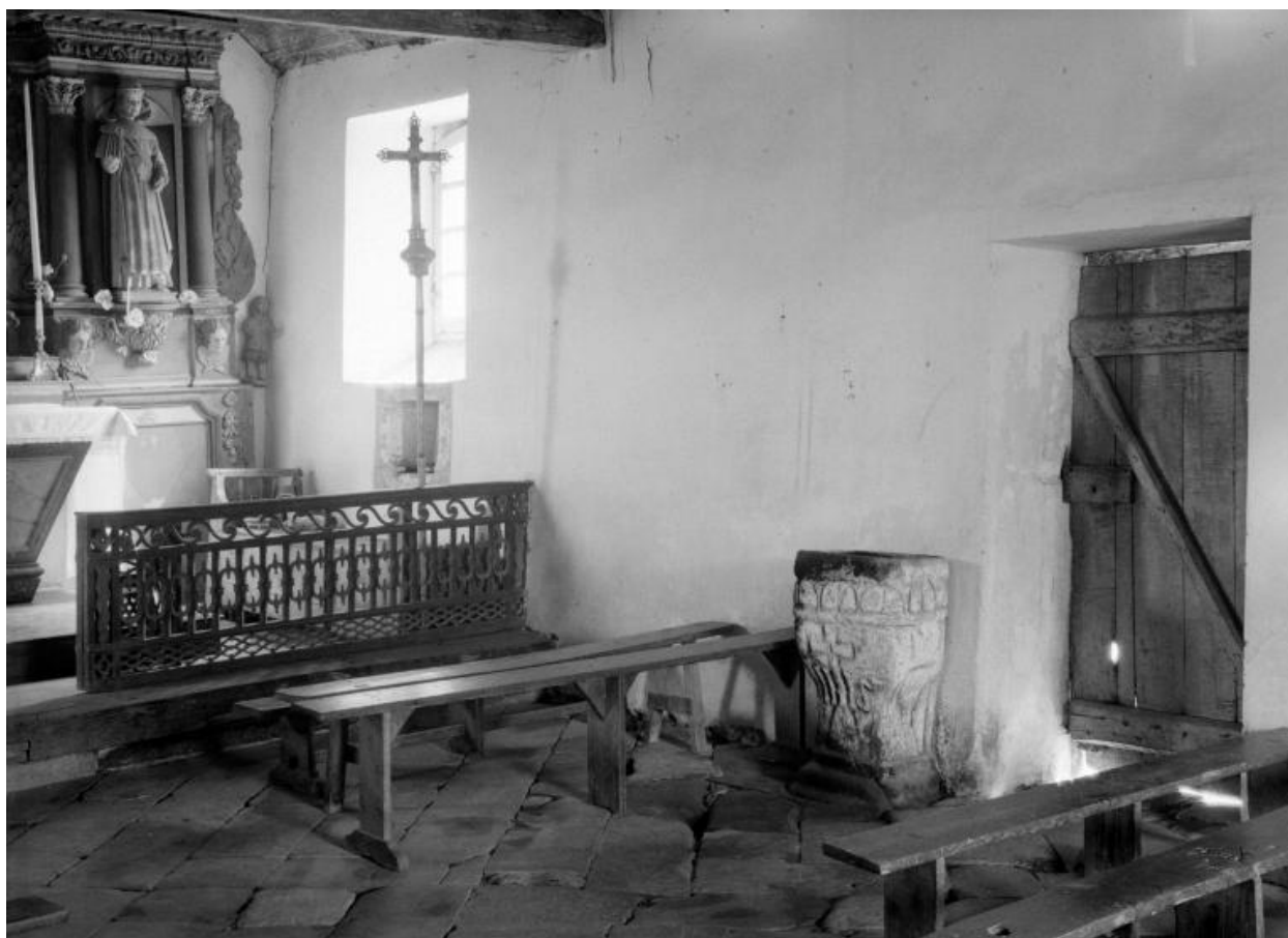
Nef : vue d'ensemble du mur sud
