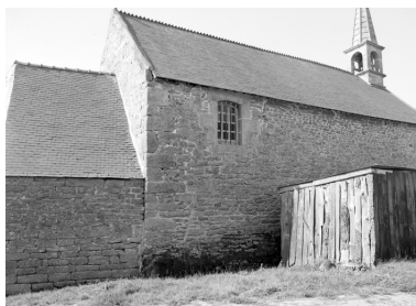
Vue du côté nord Phot. François Dagorn IVR53_19745600474X
