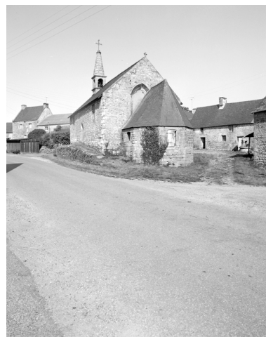
Vue générale du chevet Phot. François Dagorn IVR53_19745600473X
