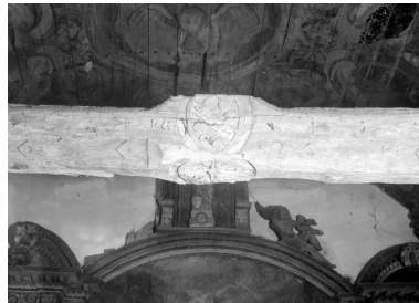
Charpente : détail d'un entrait armorié daté 1623 Phot. Armand Pâris IVR53_19665600941V
