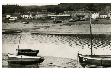
Carte postale, scènes de réparation et carénage Phot. Auteur inconnu IVR53_20262210287NUCA
