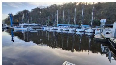
L'ancienne aire d'évitage, ancien gril de carénage, actuellement port de plaisance Phot. Erwana L'Haridon IVR53_20262210291NUCA
