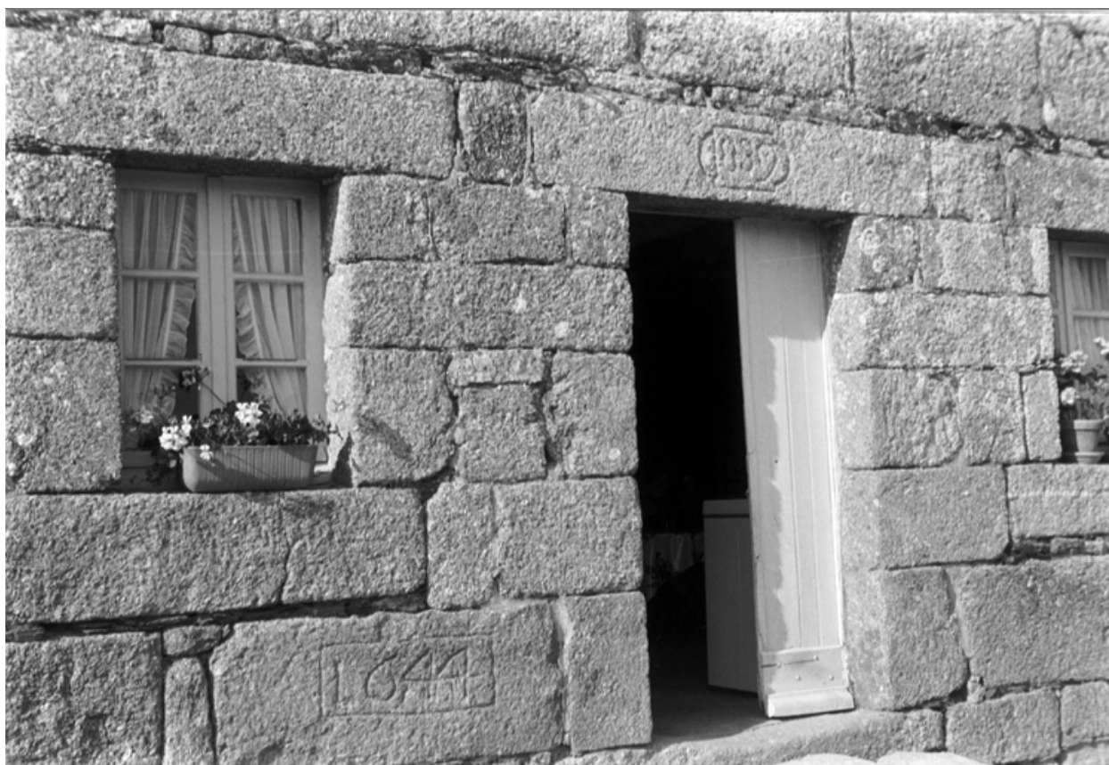
Façade sud, 1er niveau : détail des ouvertures
