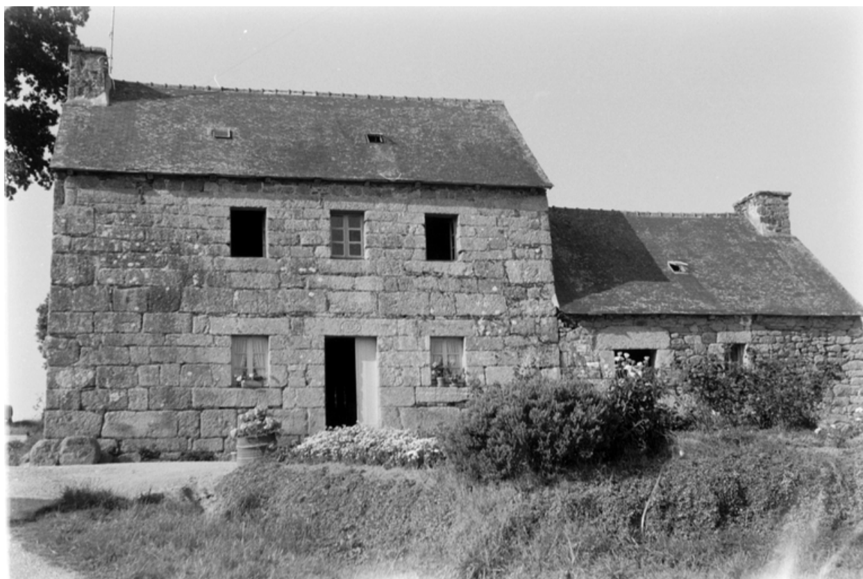
Vue de situation prise du sud
