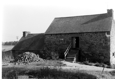
Elévation nord Phot. Jean-Pierre Ducouret IVR53_19662200711Z
