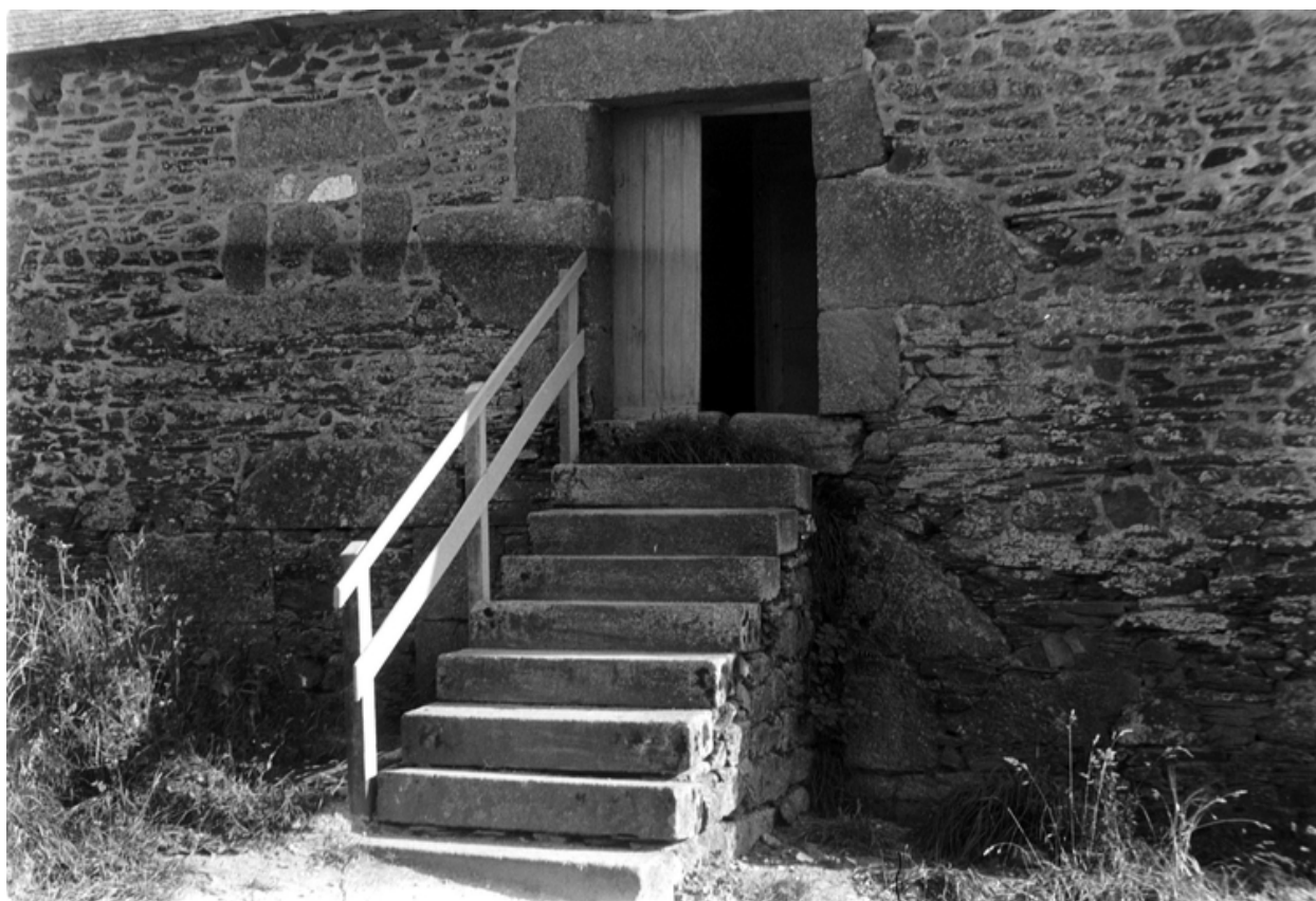
Détail des ouvertures obstruées, face nord
