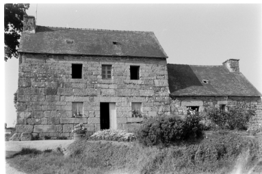
Vue de situation prise du sud Phot. Jean-Pierre Ducouret IVR53_19662200708Z
