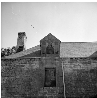
Lucarne à l'est, sur la façade nord du bâtiment ancien Phot. Jean-Yves Veillard IVR53_19665600667X
