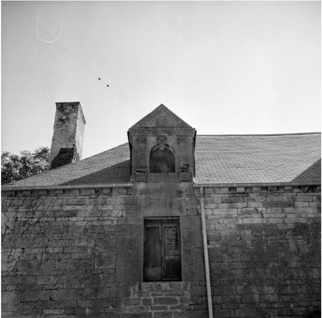
Lucarne à l'est, sur la façade nord du bâtiment ancien
