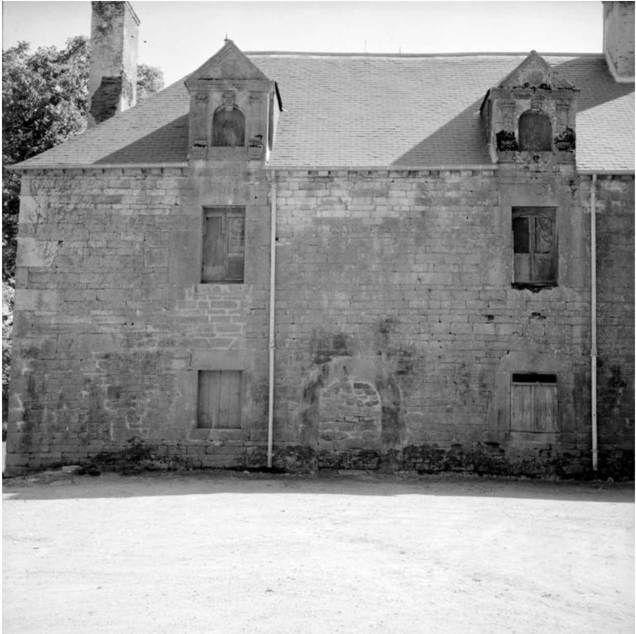
Vue d'ensemble de la façade nord du bâtiment ancien
