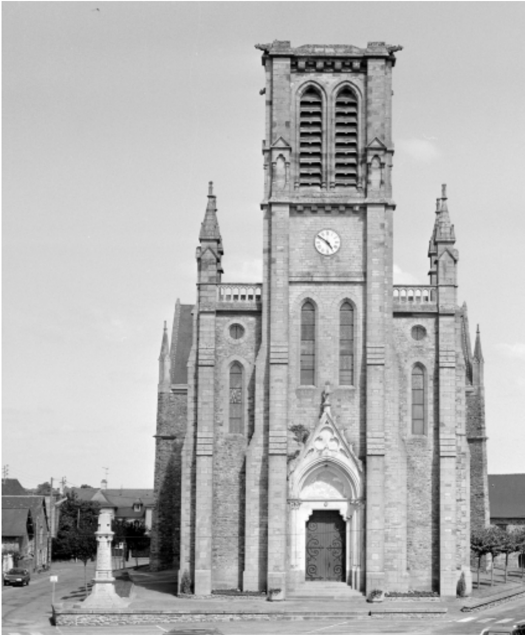
Elévation ouest : vue générale.
