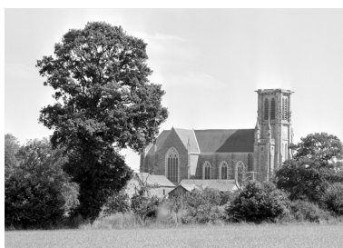
Elévation nord : vue générale. Phot. Guy Artur, Phot. Norbert Lambart IVR53_19943501356X
