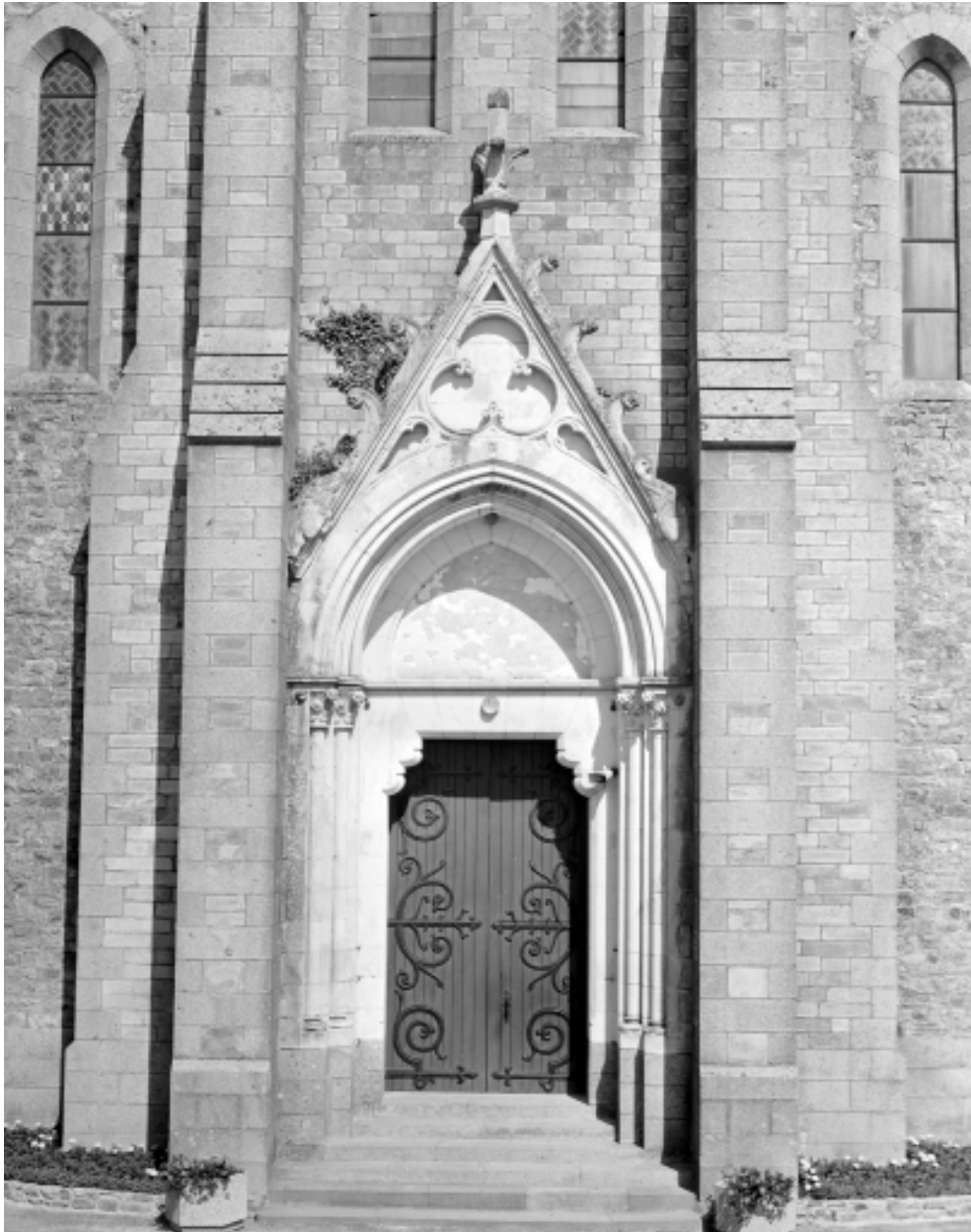
Elévation ouest, portail : vue générale.
