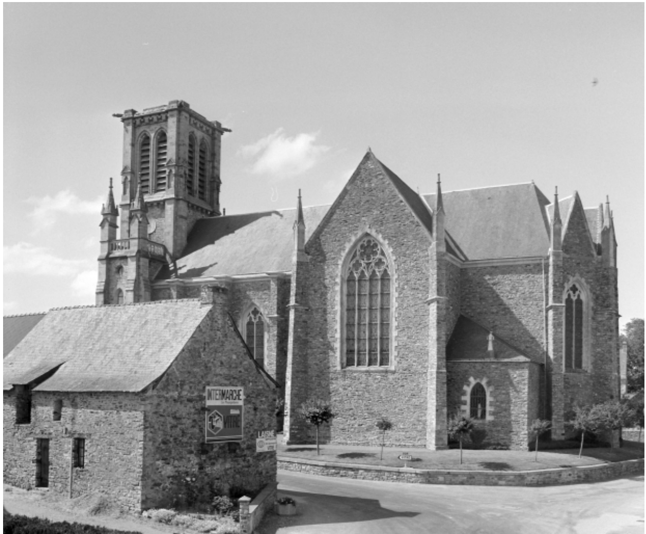
Elévation sud, vue générale prise de l'est.
