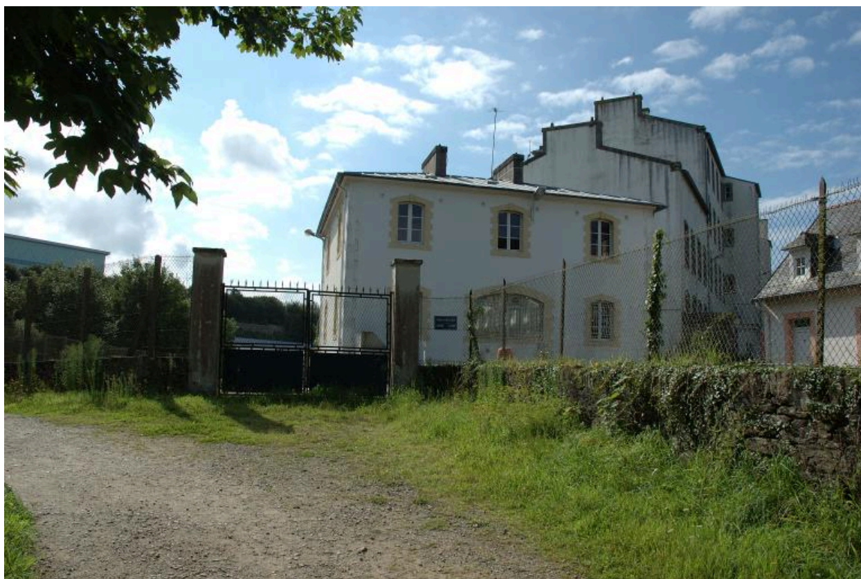
Vue du pavillon d'entrée : élévation est (état en 2005)
