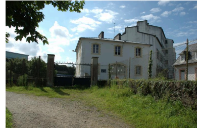
Vue du pavillon d'entrée : élévation est (état en 2005)
