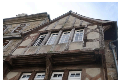
Des mortaises orphelines dans les poteaux corniers des combles attestent de consoles disparues qui soutenaient probablement l'avancée du toit, destinée à protéger le pan de bois. Phot. Fanny Gosselin IVR53_20252210427NUCA
