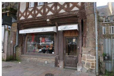
Le rez-de-chaussée est divisé en deux baies. Le poteau central a été déplacé pour agrandir la vitrine commerciale. Phot. Fanny Gosselin IVR53_20252210425NUCA
