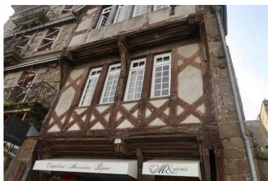
Des croix de Saint-André contreventent la partie basse du premier étage, dont les fenêtres sont modifiées. Phot. Fanny Gosselin IVR53_20252210426NUCA
