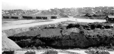
Vue de Brest vers 1950 : le Landais. Travaux d'arasement et de terrassement des fortifications. Installation des baraques pour le relogement des sinistrés. Au premier plan : vestiges de fortification Repro. Archives municipales et communautaires. Brest Métropole Océane, Phot. Guillaume (retouche) Lécueillier, Autr. Auteur inconnu IVR53_20082908992NUC
