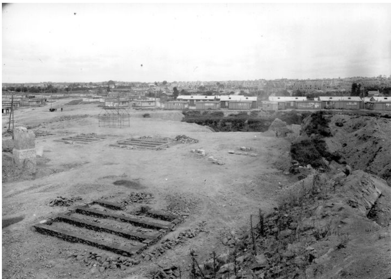
Vue de Brest vers 1950 : le Bouguen. Travaux d'arasement et de terrassement des fortifications. Installation des baraques pour le logement des sinistrés. Fondation d'une baraque au premier plan
