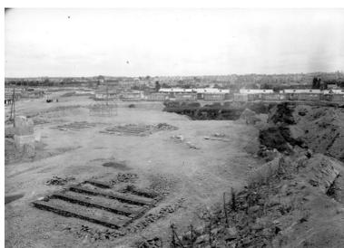
Vue de Brest vers 1950 : le Bouguen. Travaux d'arasement et de terrassement des fortifications. Installation des baraques pour le relogement des sinistrés. Fondation d'une baraque au premier plan
