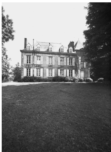
Vue générale de la façade nord Phot. Guy Artur IVR53_19685600208V
