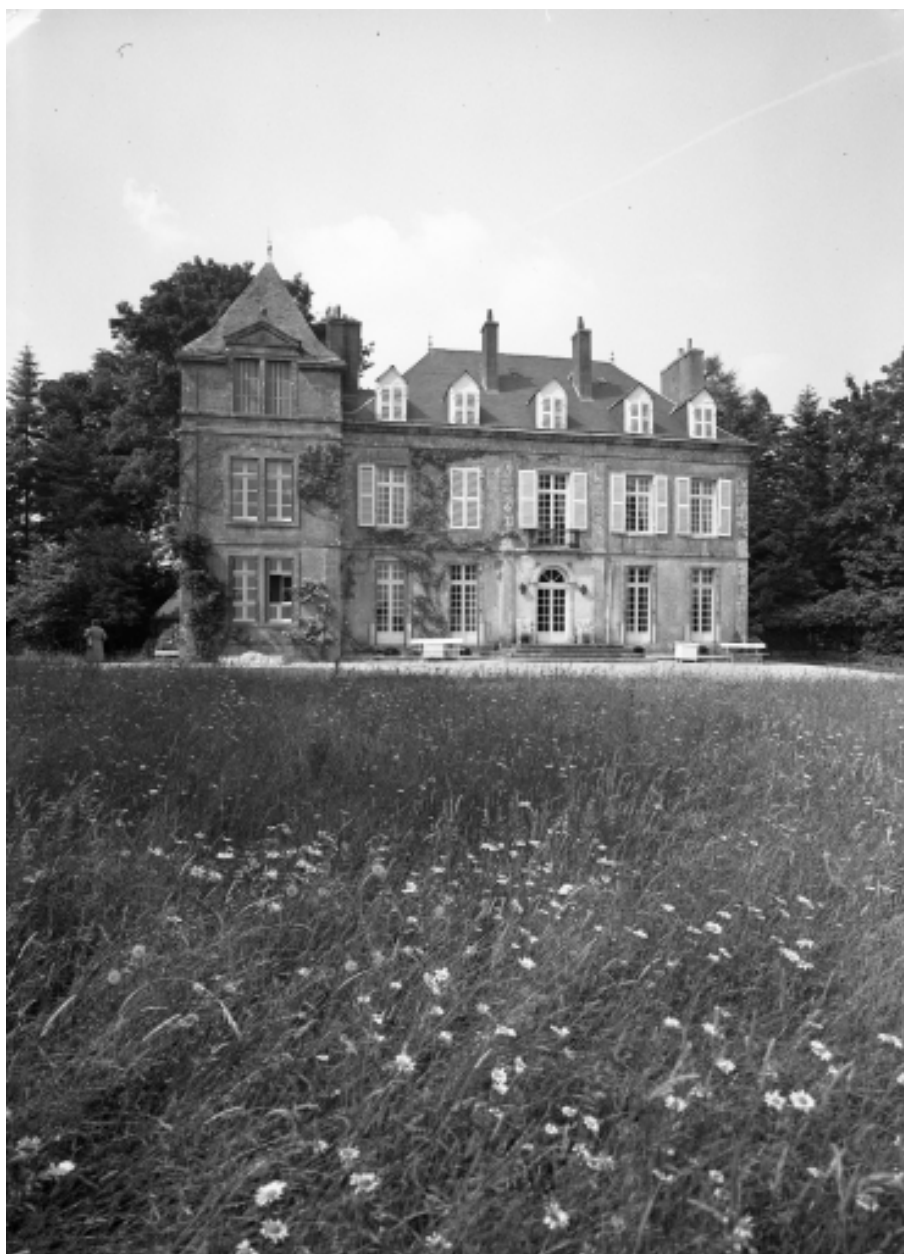
Vue générale de la façade sud
