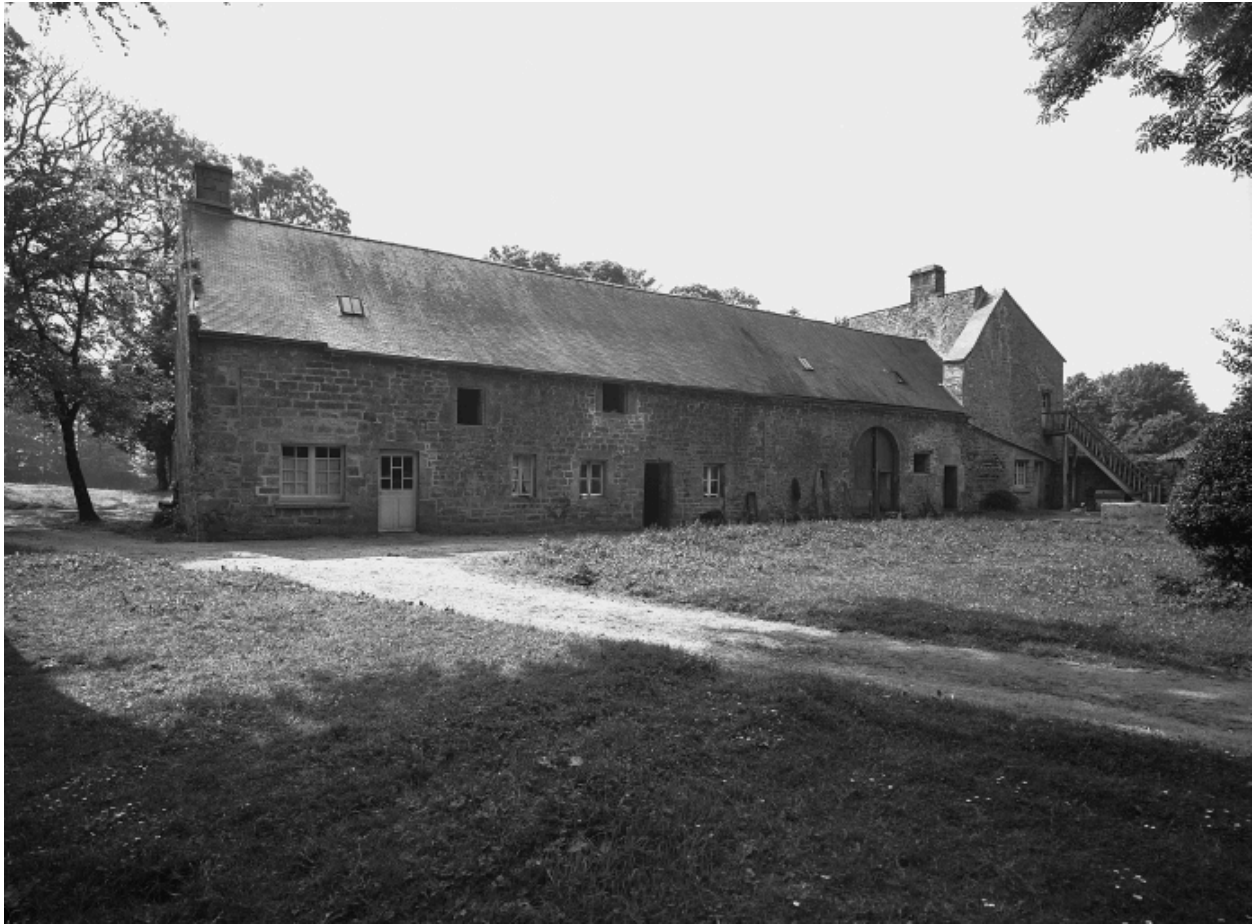
Communs : vue générale sud est de la façade principale
