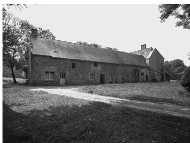
Communs : vue générale sud est de la façade principale Phot. Guy Artur IVR53_19685600207V
