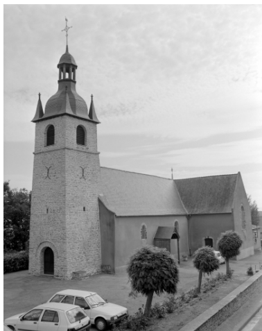
Elévation sud-ouest : vue générale Phot. Guy Artur, Phot. Norbert Lambart IVR53_19943501394X
