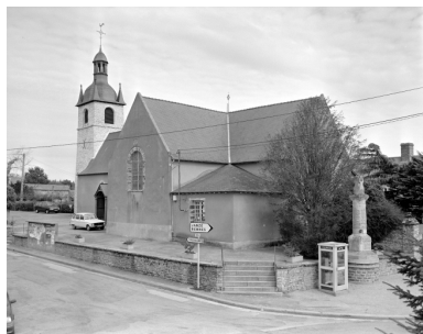
Elévation sud-est : vue générale Phot. Guy Artur, Phot. Norbert Lambart IVR53_19943501395X
