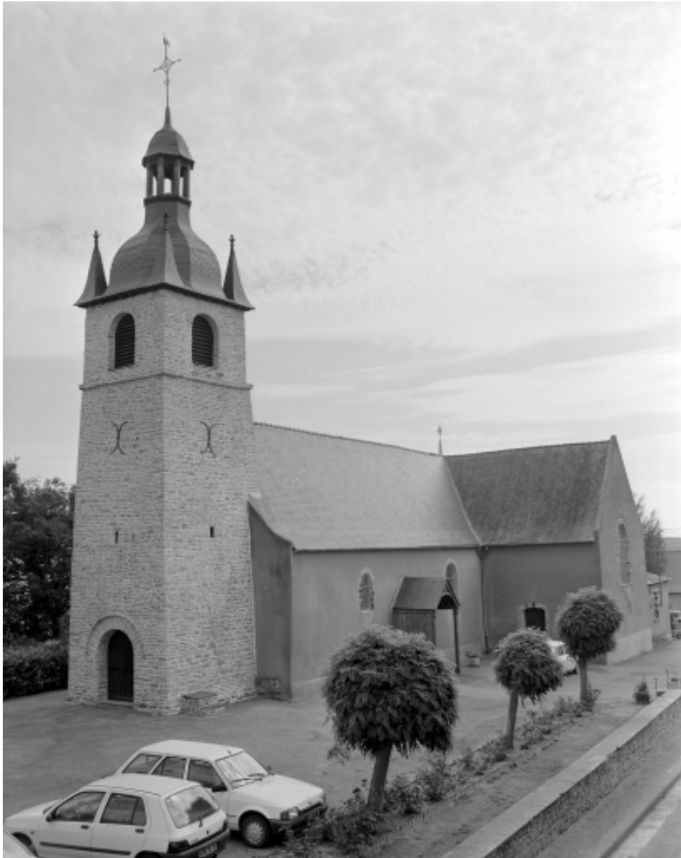
Elévation sud-ouest : vue générale
