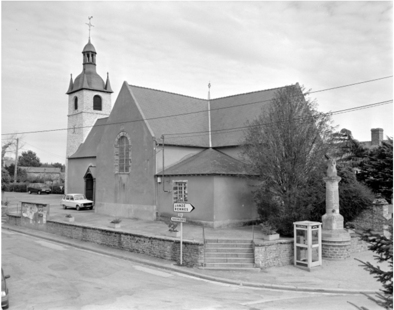
Elévation sud-est : vue générale
