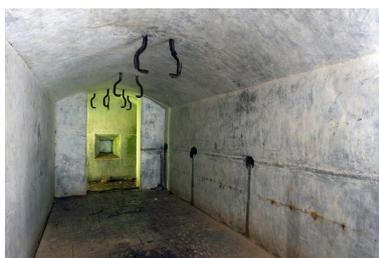
Vue intérieure du magasin à munitions (vers l'entrée) : vestibule d'entrée et créneau à lampe. Il conserve du matériel de second œuvre : fixations du rail pour la manutention des obus via un palan. Sur le mur, les traces d'étagères de stockage et marques laissées par le frottement des obus
