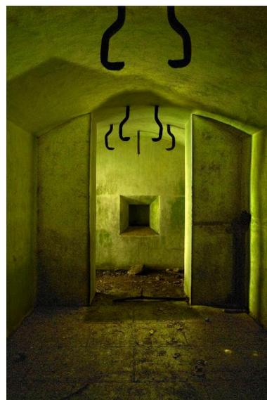
Vue intérieure du magasin à munitions (vers l'entrée) : vestibule d'entrée et créneau à lampe. Il conserve du matériel de second œuvre : fixations du rail pour la manutention des obus par un palan
