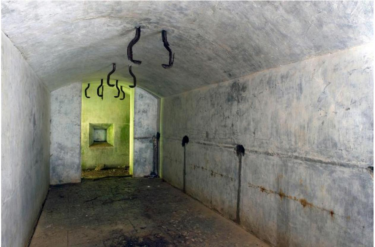
Vue intérieure du magasin à munitions (vers l'entrée) : vestibule d'entrée et créneau à lampe. Il conserve du matériel de second oeuvre : fixations du rail pour la manutention des obus via un palan. Sur le mur, les traces d'étagères de stockage et marques laissées par le frottement des obus
