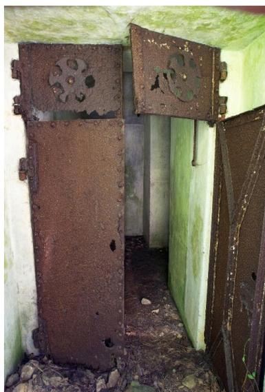
Vue de l'entrée du magasin à munitions. Il conserve du matériel de second œuvre : battants de porte et volets, gonds avec ventilation réglable
