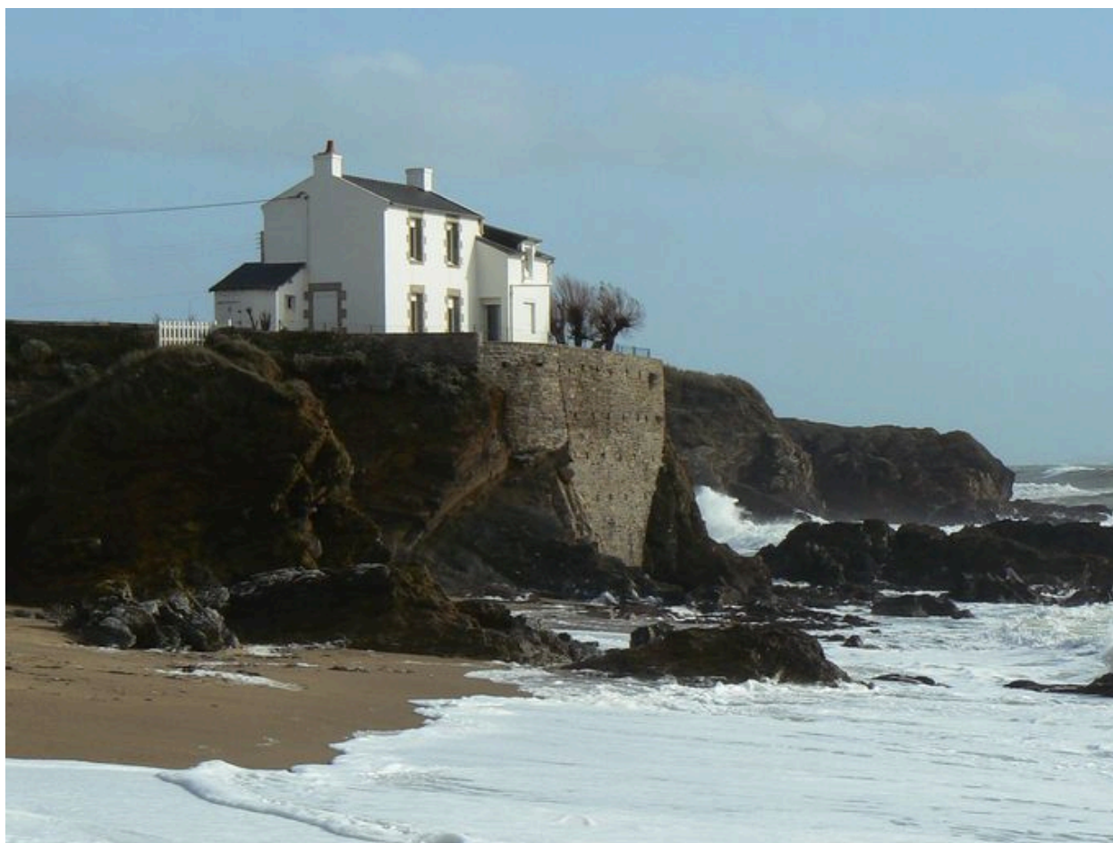
Façade de la Maison isolée, côté mer et pignon ouest
