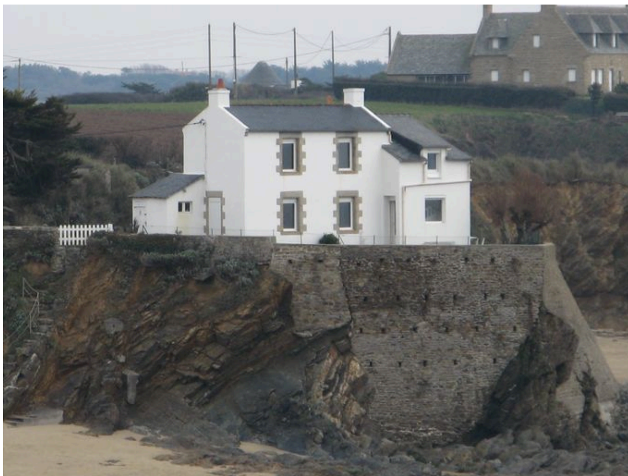
Vue générale de la Maison isolée
