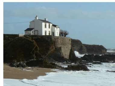
Façade de la Maison isolée, côté mer et pignon ouest Phot. Johan Vincent IVR53_20072909039NUCA
