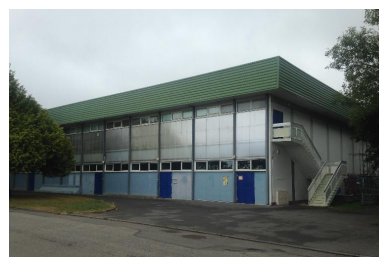
Vue générale Phot. Simon Vely IVR53_20162905532NUCA
