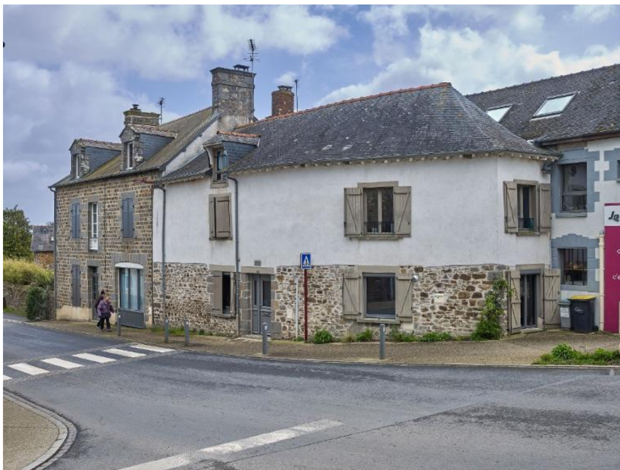
Vue générale de l'élévation antérieure.
