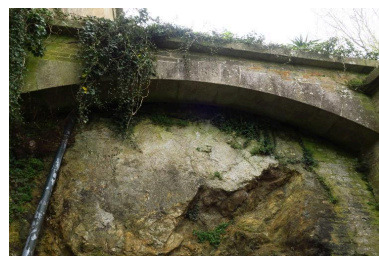
Le Palais, enceinte urbaine, porte de Locmaria, créneau de pied.
