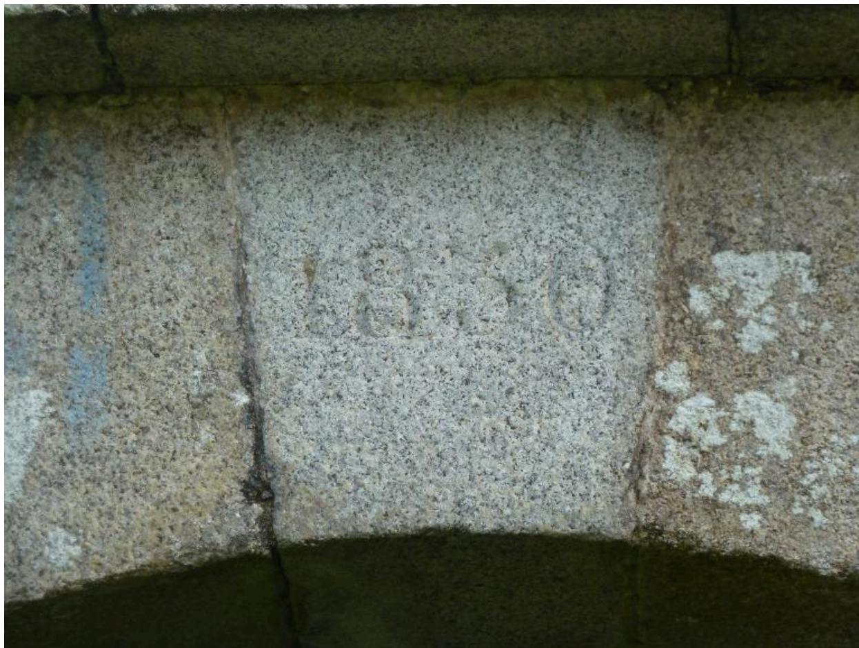
Le Palais, enceinte urbaine, porte de Locmaria, débouché côté ville, détail.
