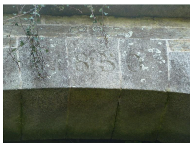
Le Palais, enceinte urbaine, porte de Locmaria, créneau de pied, détail.
