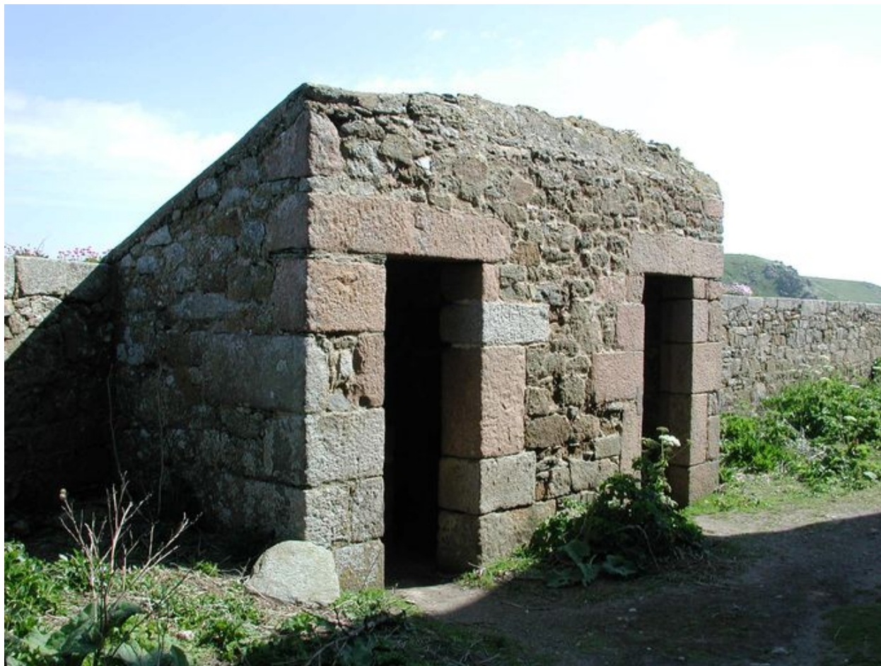
Vue générale (état en 2002). Elles sont dotées de deux portes orientées vers le sud
