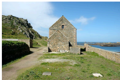
Vue de situation (état en 2006). Les latrines sont adossées au parapet du mur de soutènement Phot. Guillaume Lécueillier IVR53_20062210052NUCA
