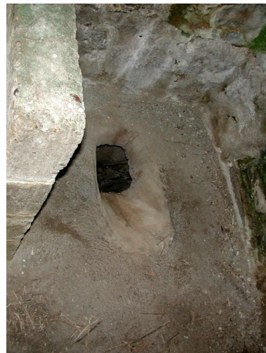
Vue intérieure (état en 2002) Phot. Guillaume Lécueillier IVR53_20022202471NUCA
