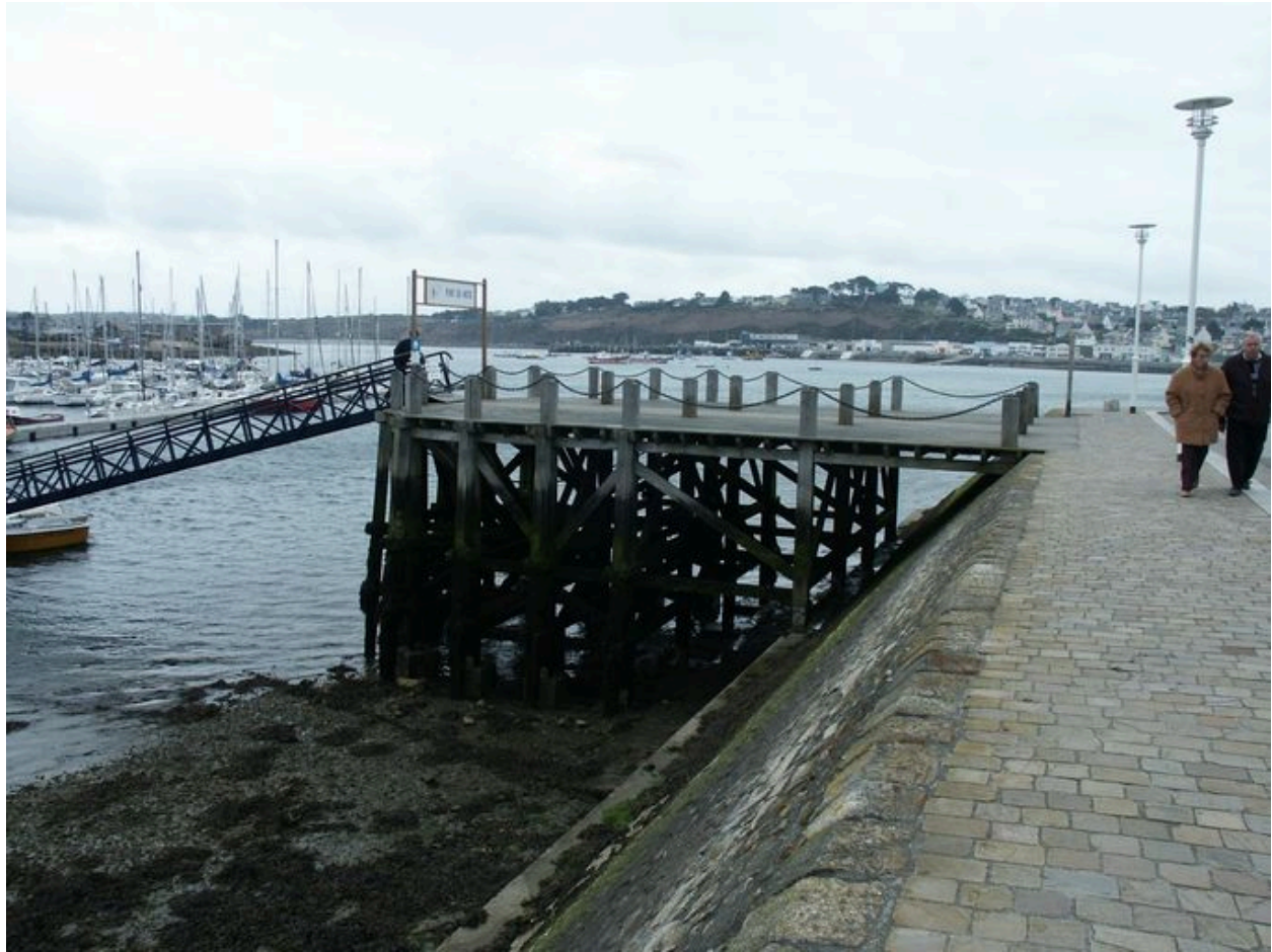
Estacade en bois
