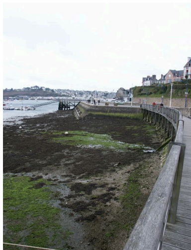
Vue générale du Quai Vauban Phot. Agnès Galifot IVR53_20062908360NUCA
