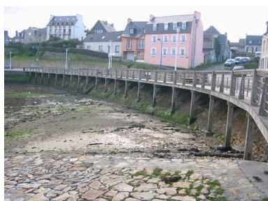
Promenade en bois du quai Vauban Phot. Guillaume Marie IVR53_20062908434NUCA
