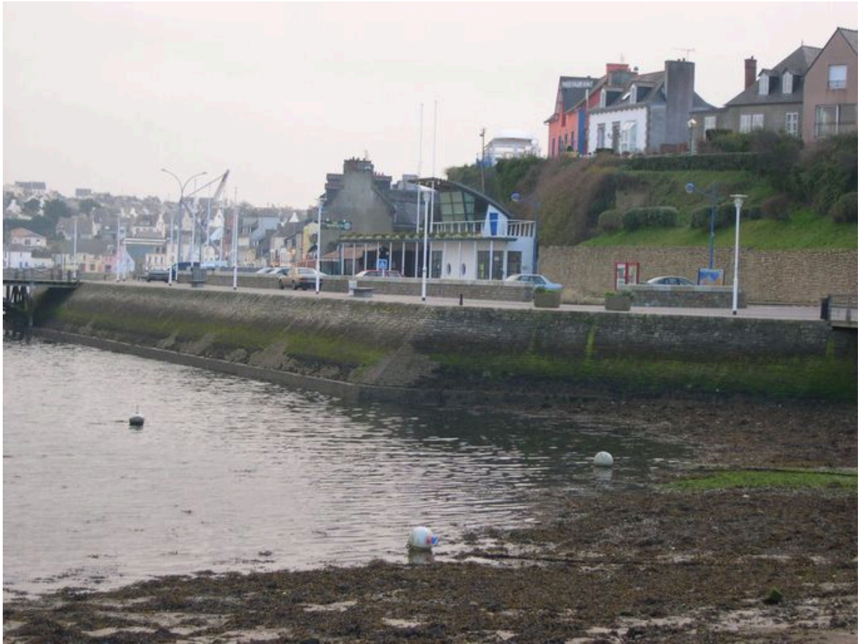
Vue du quai Vauban vers le sud
