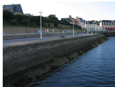
Vue du quai Vauban vers le nord Phot. Guillaume Marie IVR53_20062908344NUCA
