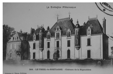
Vue générale de la façade principale au début du 20e siècle Phot. Elise Lauranceau, Autr. Armand Waron IVR53_20033517758NUCB
