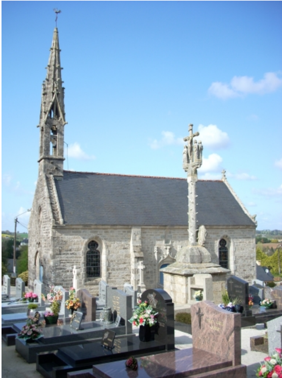
Chapelle Saint-Guénolé : vue générale sud
