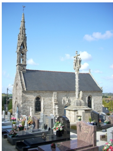
Chapelle Saint-Guénoùlé : vue générale sud Phot. Gwénaél Fauchille IVR53_20082905497NUCA
