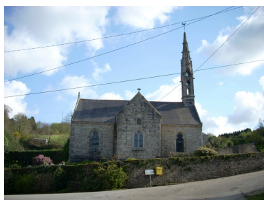
Chapelle Saint- Guérolé : élévation nord Phot. Gwénaél Fauchille IVR53_20082905500NUCA
