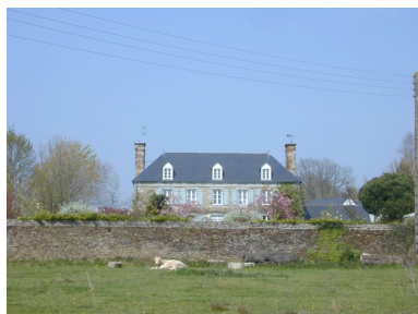
Vue de situation sud-ouest Phot. Xavier Gilbert IVR53_20013518863NUCA
