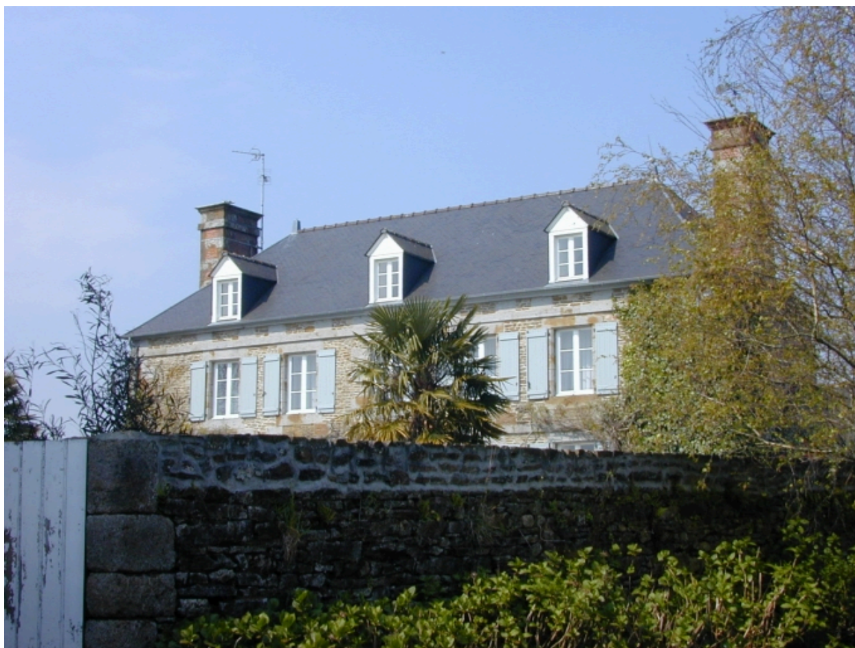
Vue partielle sud-est
