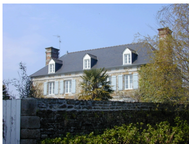
Vue partielle sud-est Phot. Xavier Gilbert IVR53_20013518864NUCA
