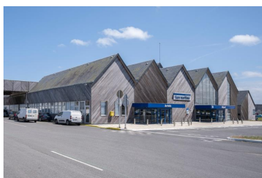
Gare maritime du Blosson, vue générale Phot. Charlotte Barraud IVR53_20252901087NUCA
