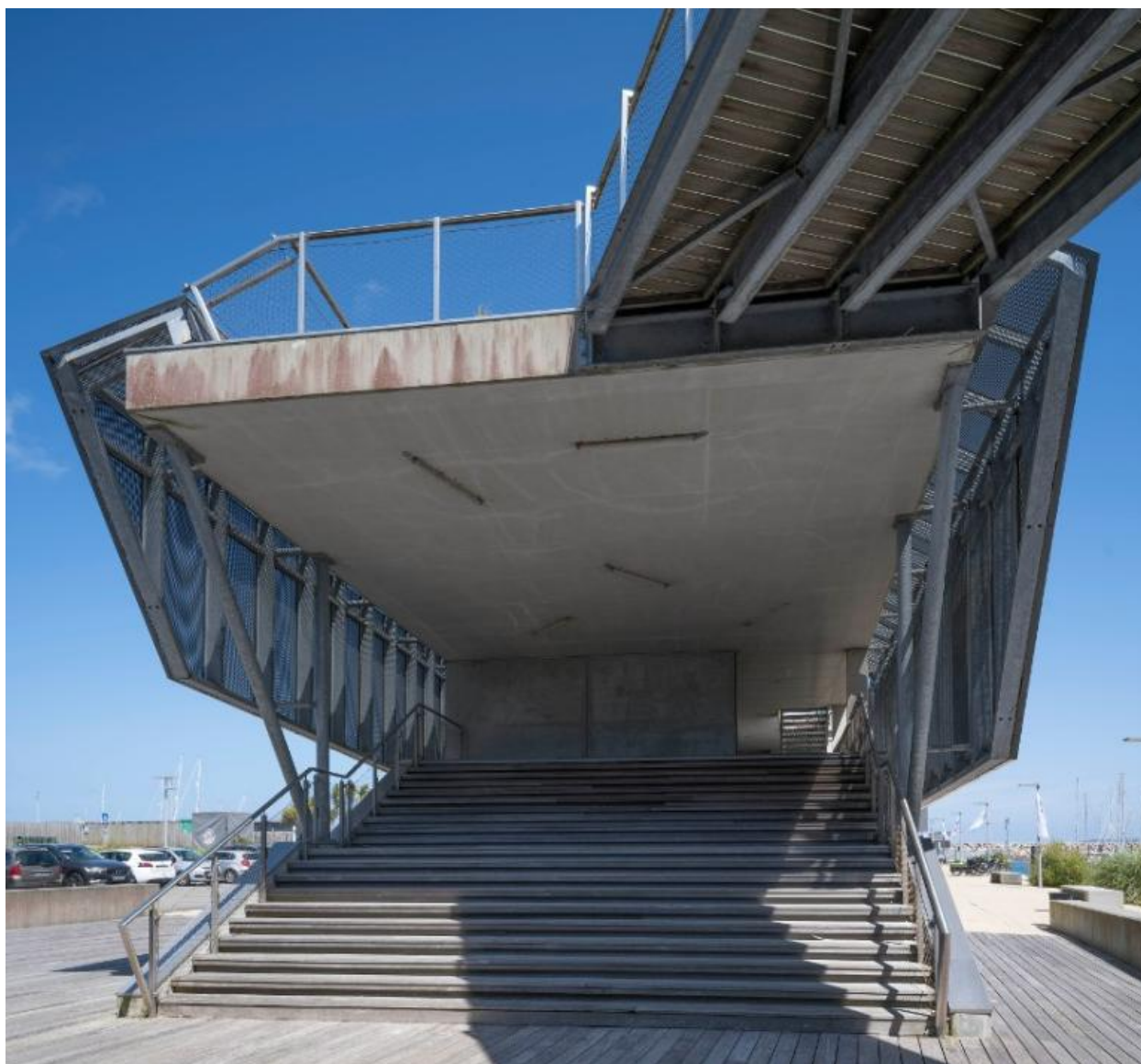
Escaliers et passerelle du bâtiment de la zone d'animation du port (S.A.B.H.)
