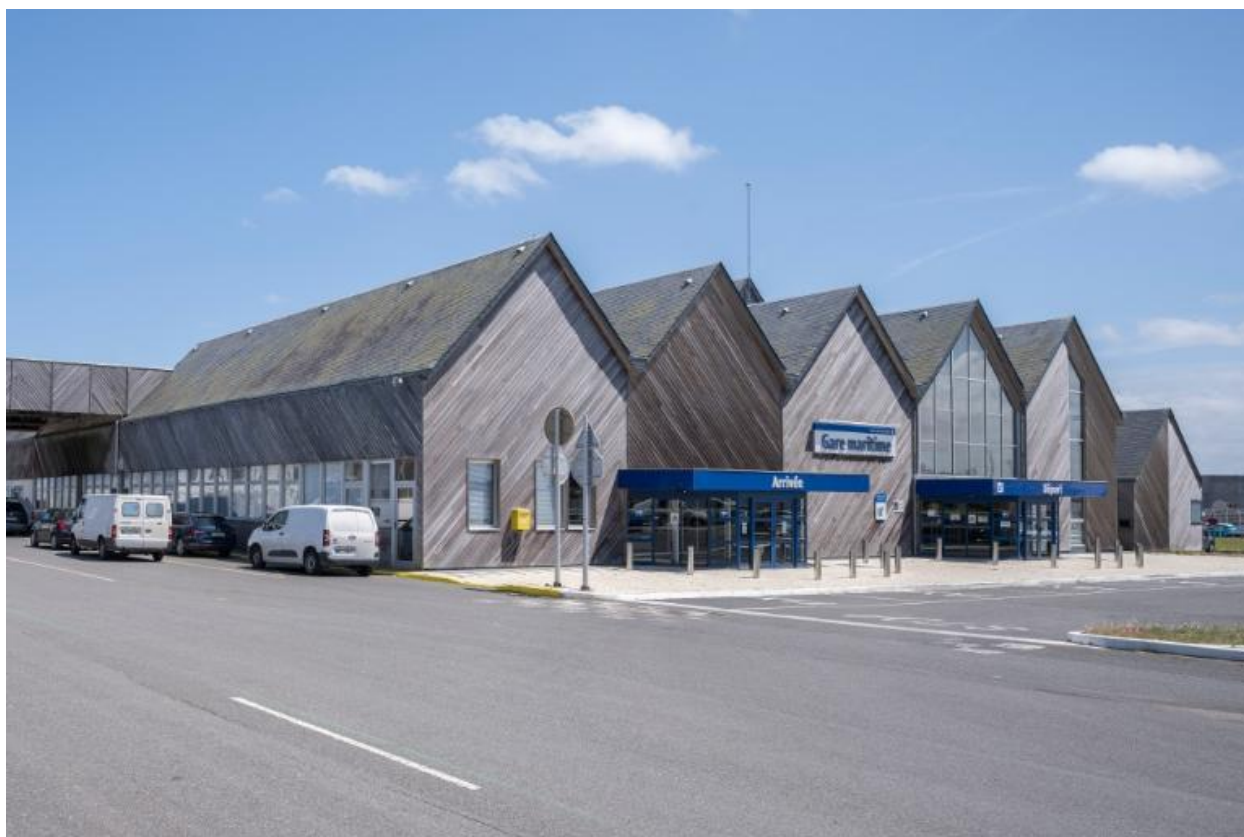
Gare maritime du Blosson, vue générale
