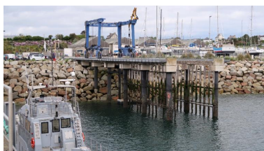
Darse de levage et élévateur à sangles Phot. Erwana L'Haridon IVR53_20252910461NUCA
