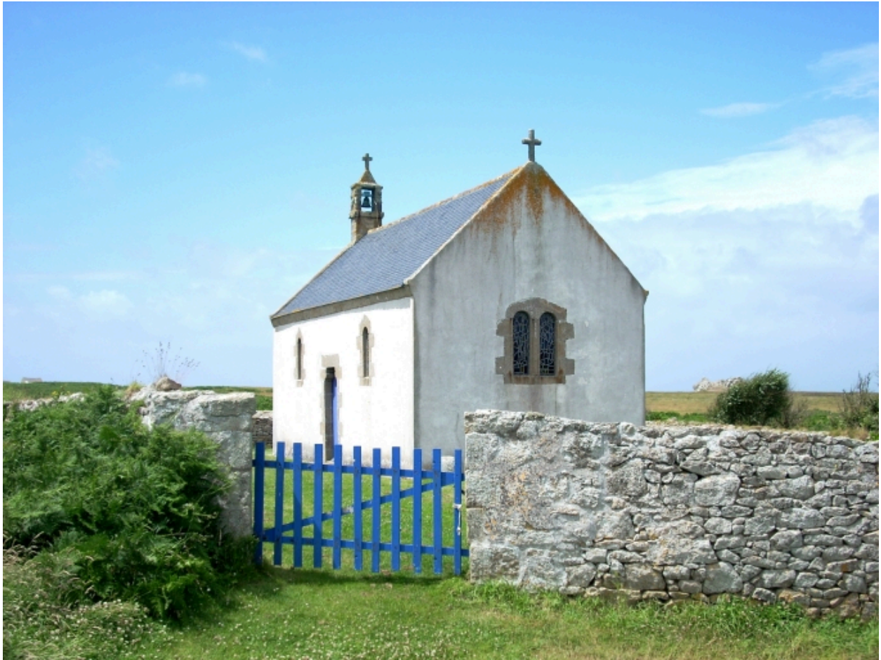
Ouessant, chapelle de Locqueltas : vue générale sud-est
