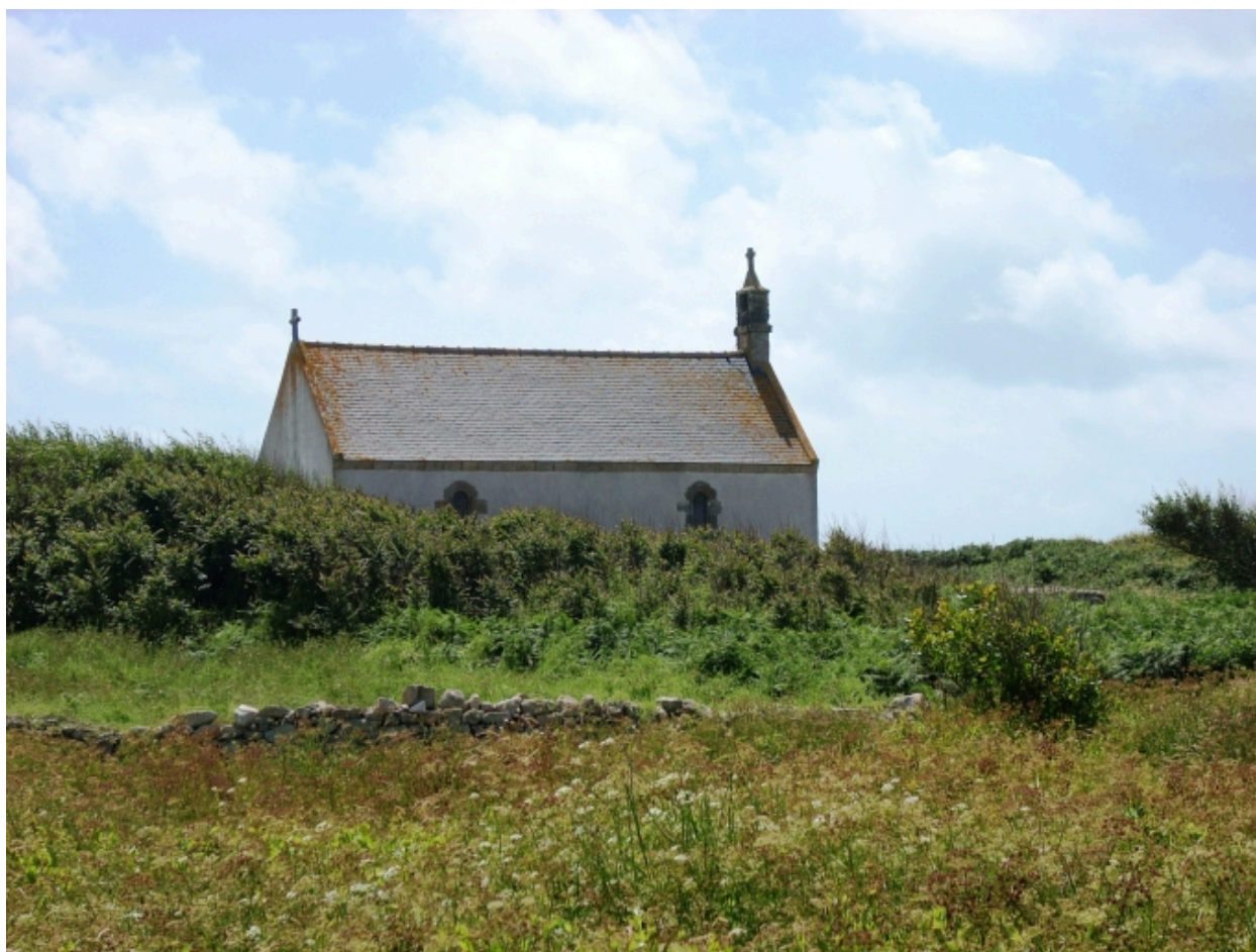
Ouessant, chapelle de Locqueltas : vue générale nord-est
