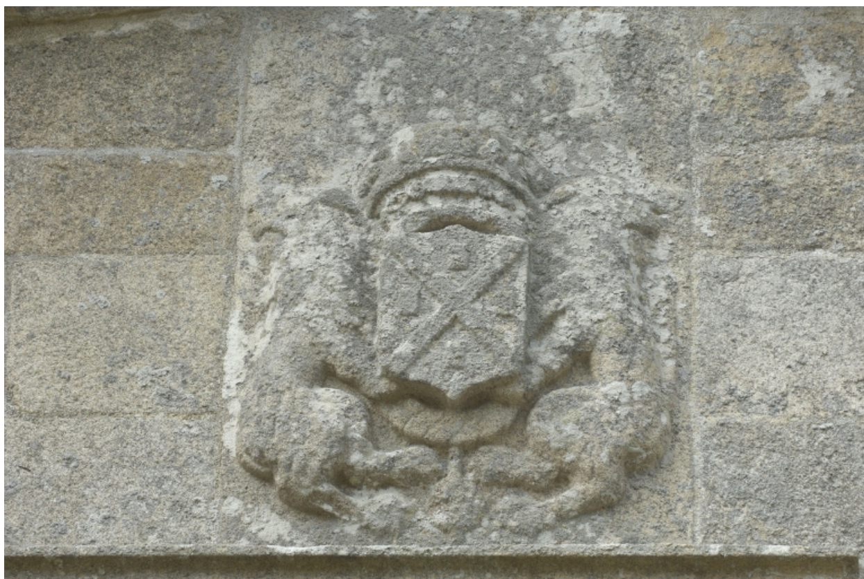
Portail du corps de passage, armoiries sculptées
