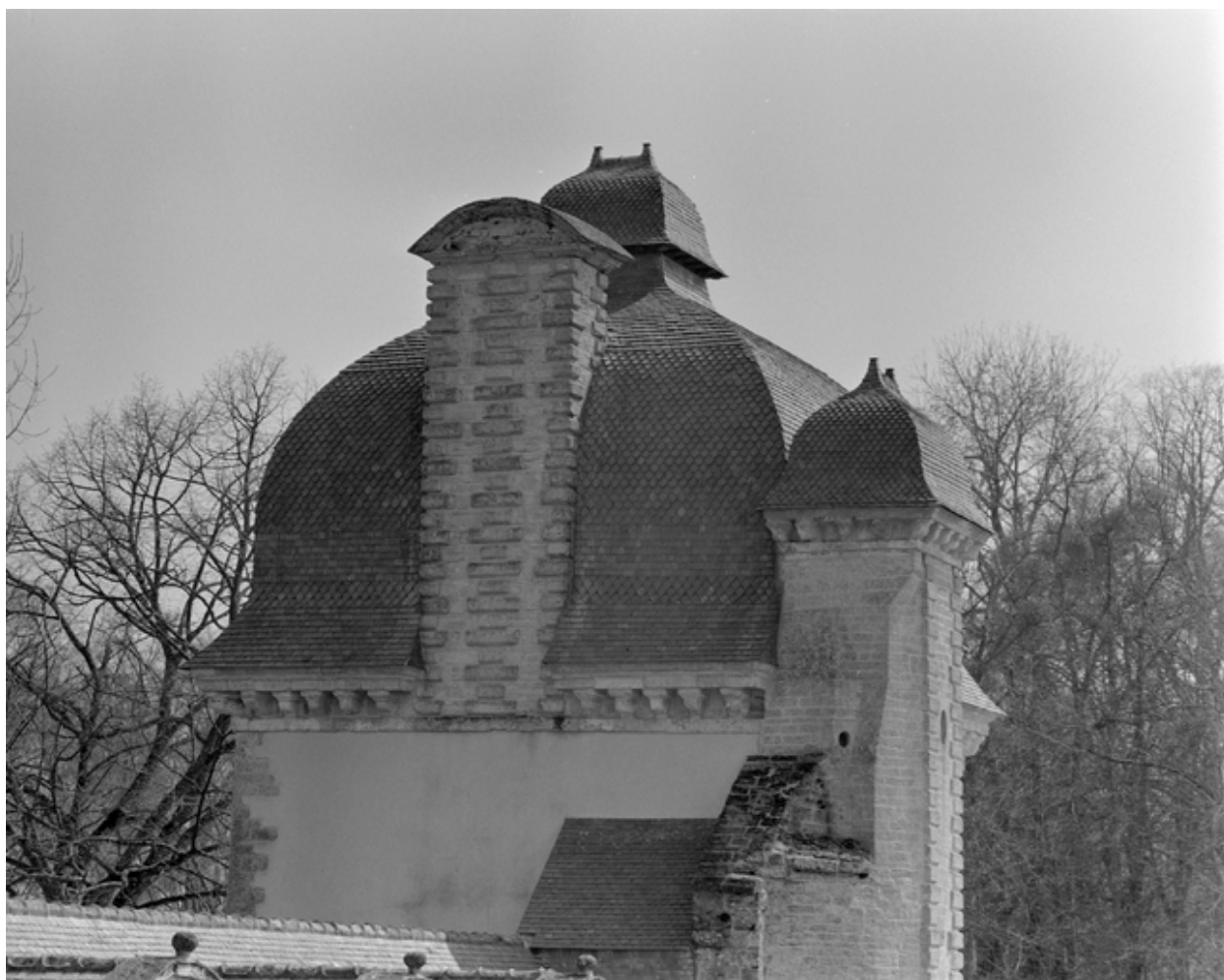
Pavillon droit : toit
