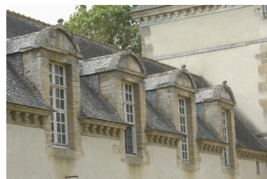
Aile occidentale sur cour, détail des lucarnes Phot. Norbert Lambart IVR53_20112200720NUCA
