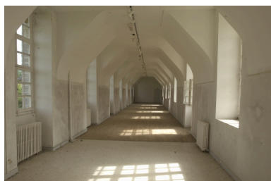
Aile est, étage de comble Phot. Norbert Lambart IVR53_20112200732NUCA
