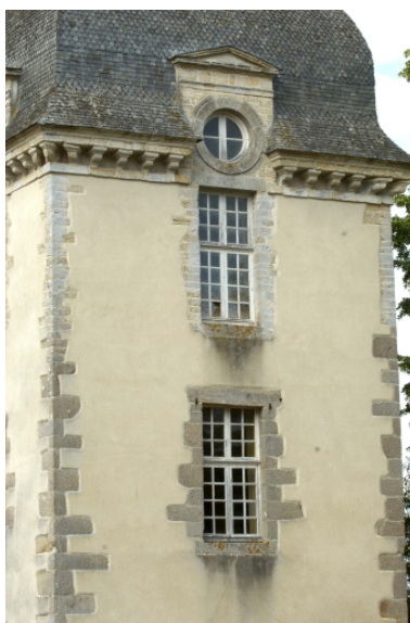
Le pavillon oriental, détail de l'élévation Phot. Norbert Lambart IVR53_20112200714NUCA
