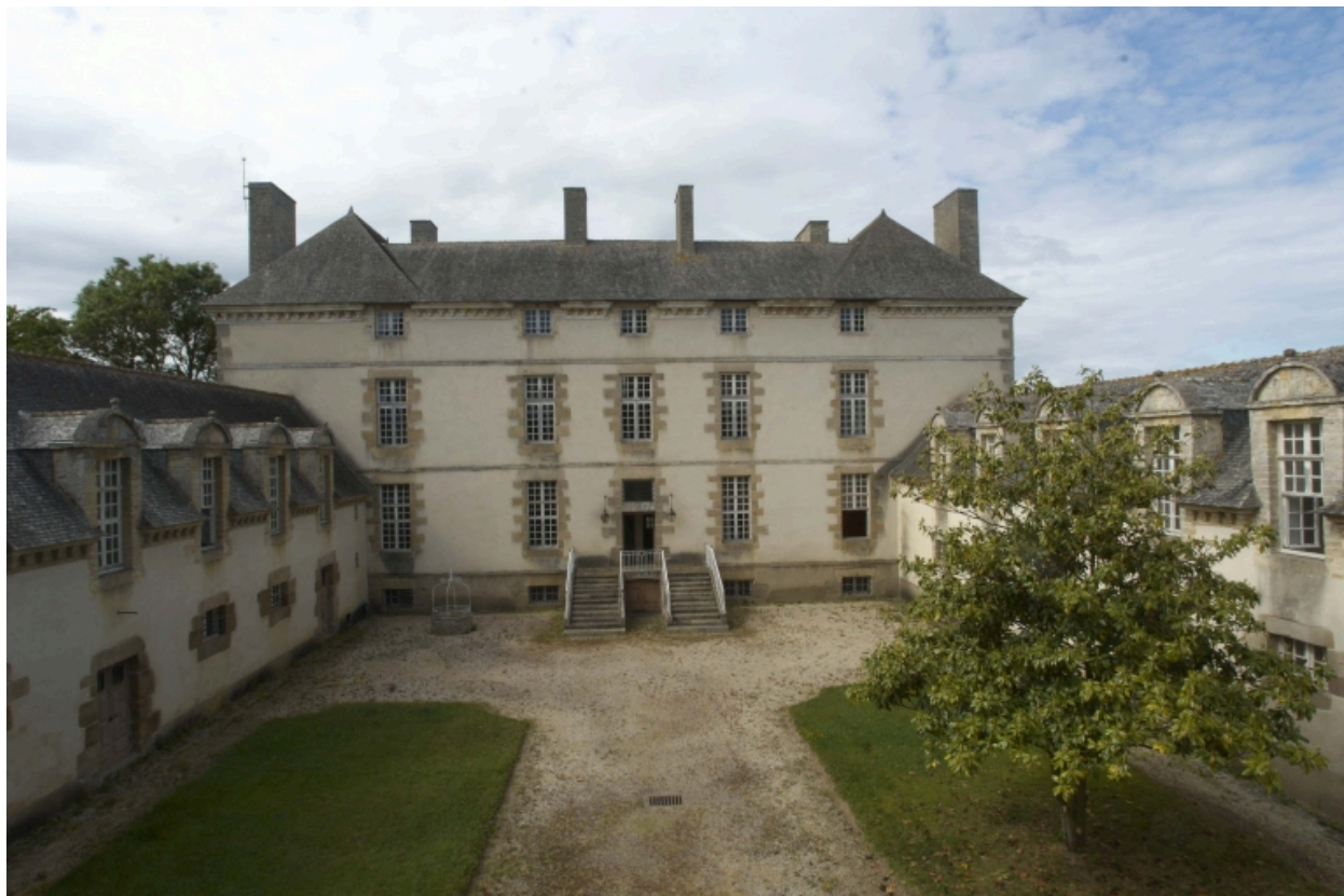
Château : vue générale prise de la cour
