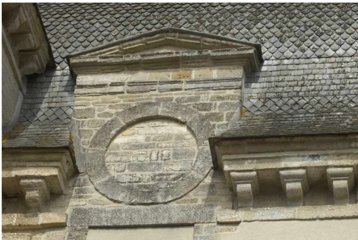
Pavillon d'angle, détail : lucarne
