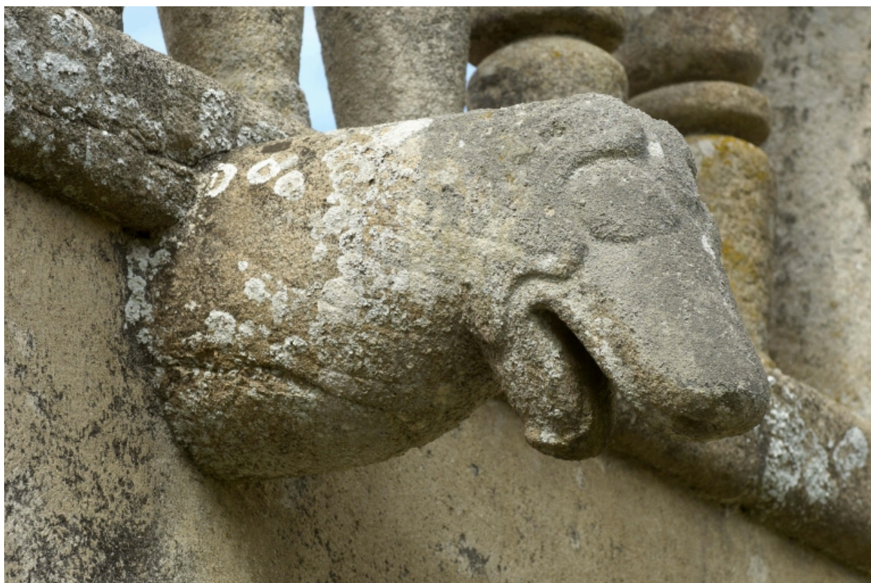
Corps de passage, détail gargouille
