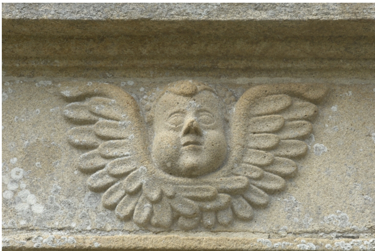
Portail, du corps de passage, détail, tête d'ange
