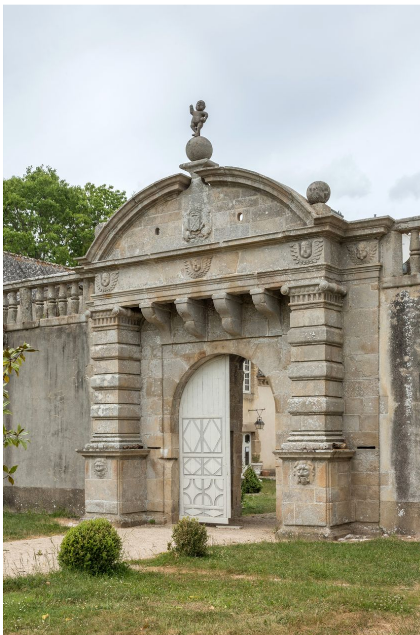
Corps de passage au sud, vue d'ensemble
