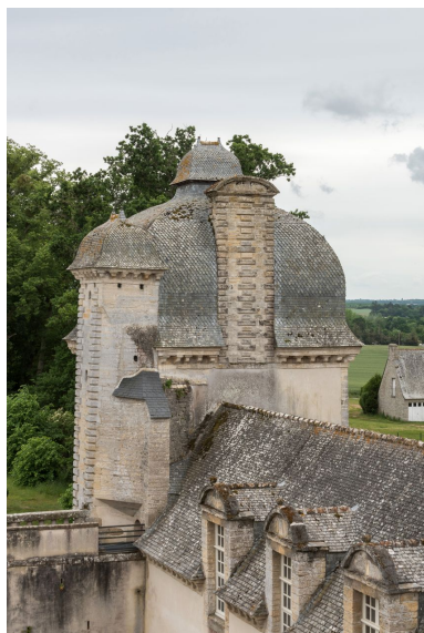
Le pavillon ouest et l'aile occidentale Phot. Charlotte Barraud IVR53_20222200683NUCA
