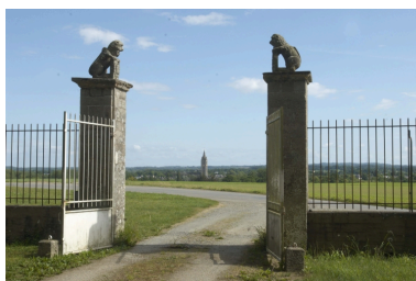
1er portail d'entrée Phot. Norbert Lambart IVR53_20112200753NUCA
