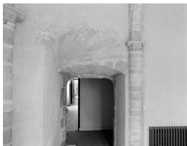
Chapelle : voussure de la porte d'entrée Phot. Guy Artur, Phot. Norbert Lambart IVR53_19872200269X
