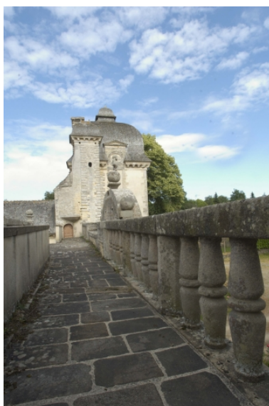
Corps de passage, partie supérieure accédant au pavillon d'angle Phot. Norbert Lambart IVR53_20112200744NUCA
