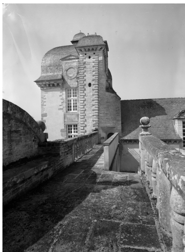
Galerie : vue générale Phot. Guy Artur, Phot. Norbert Lambart IVR53_19872200264V
