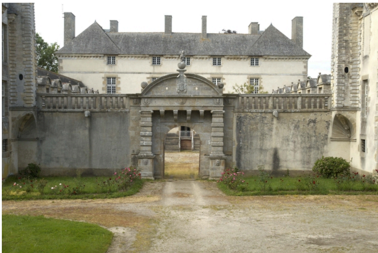
Corps de passage, vue d'ensemble
