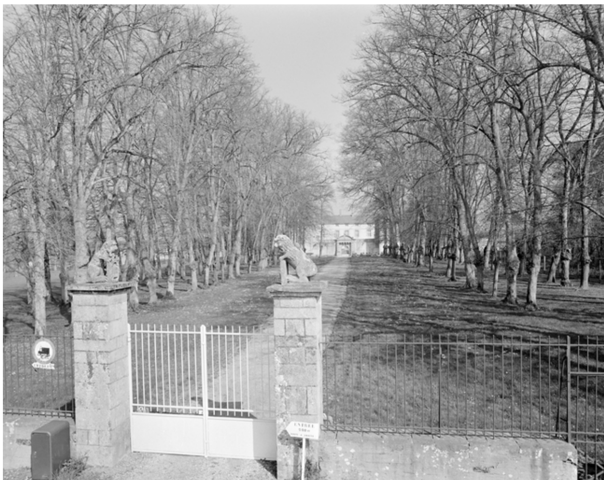
Portail : vue générale
