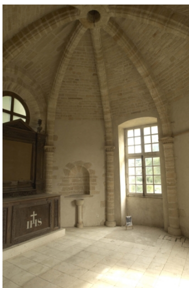
Chapelle, vue générale intérieure Phot. Norbert Lambart IVR53_20112200736NUCA
