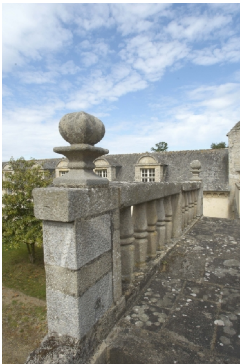
Corps de passage, détail du garde-corps
