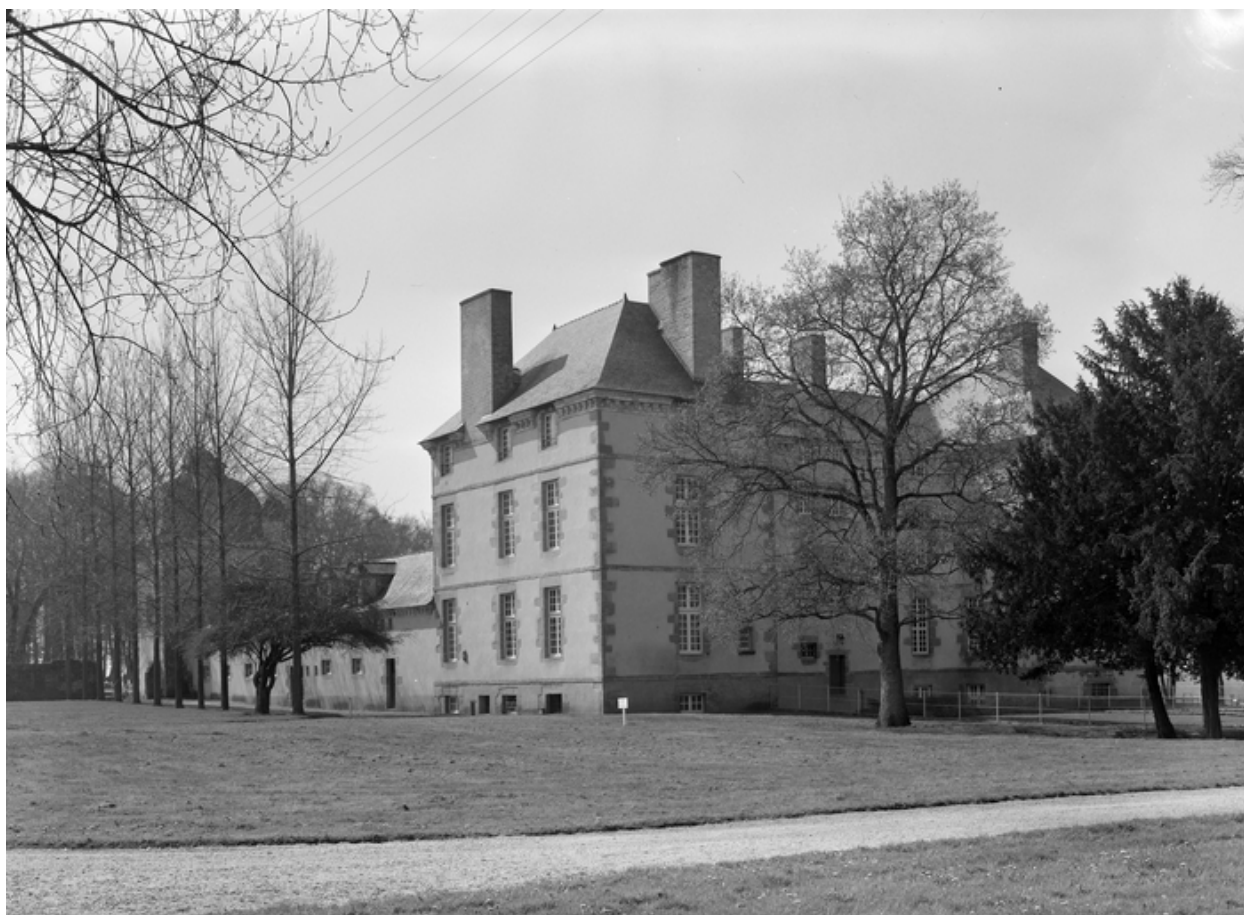
Vue générale prise du Nord
