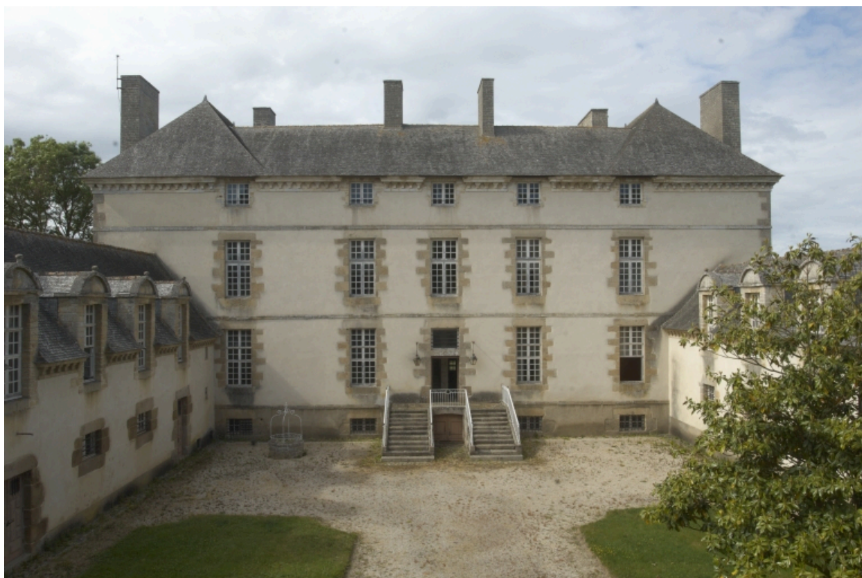
Château : vue générale du corps principal
