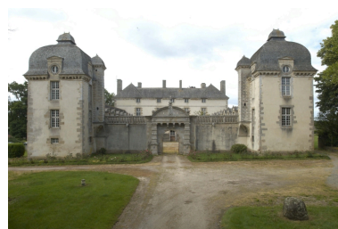
Château, vue générale Phot. Norbert Lambart IVR53_20112200710NUCA
