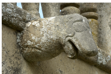
Corps de passage, détail gargouille Phot. Norbert Lambart IVR53_20112200747NUCA
