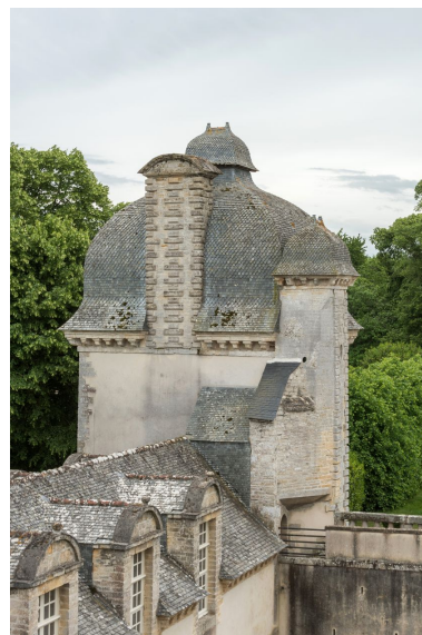
Le pavillon est et son toit à l'impériale Phot. Charlotte Barraud IVR53_20222200684NUCA
