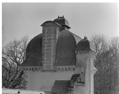
Pavillon droit : toit Phot. Guy Artur, Phot. Norbert Lambart IVR53_19872200273X
