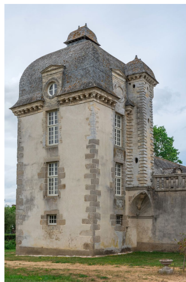
Le pavillon occidental, vue d'ensemble Phot. Charlotte Barraud IVR53_20222200672NUCA
