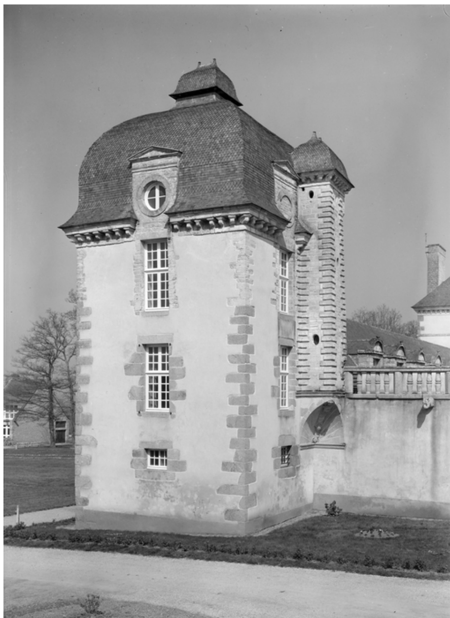
Pavillon gauche : vue générale.
