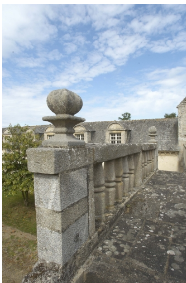
Corps de passage, détail du garde-corps Phot. Norbert Lambart IVR53_20112200745NUCA
