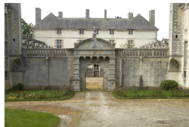
Corps de passage, vue d'ensemble Phot. Norbert Lambart IVR53_20112200712NUCA
