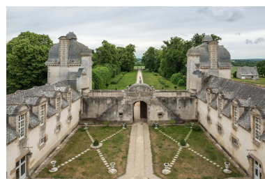
Perspective depuis le château vers la cour et le corps de passage, état en 2022 Phot. Charlotte Barraud IVR53_20222200682NUCA
