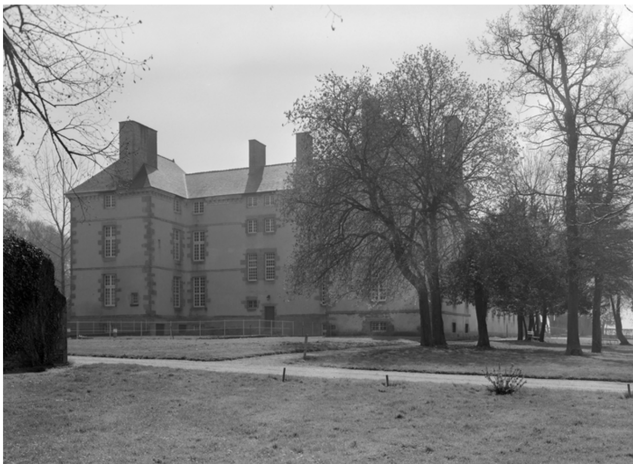
Vue générale façade nord
