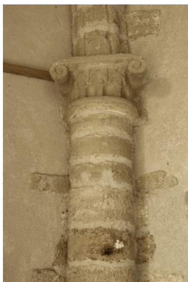
Chapelle, détail, retombée du voûtement Phot. Norbert Lambart IVR53_20112200738NUCA
