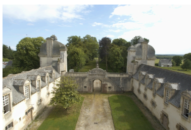
Cour et allée, vue prise de l'étage du château, état en 2011 Phot. Norbert Lambart IVR53_20112200725NUCA
