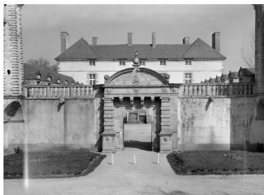
Galerie et portail. Phot. Guy Artur, Phot. Norbert Lambart IVR53_19872200261V
