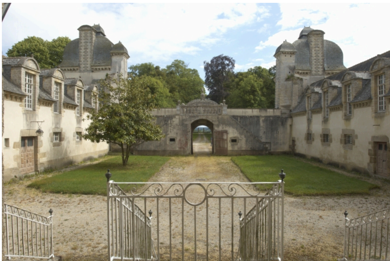
Cour, vue générale
