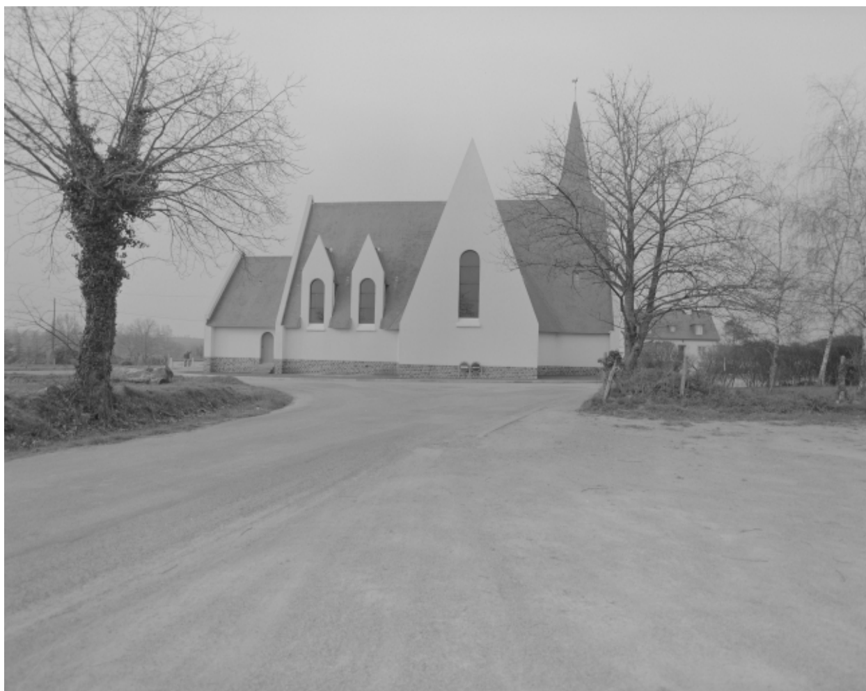
Elévation Ouest : vue générale
