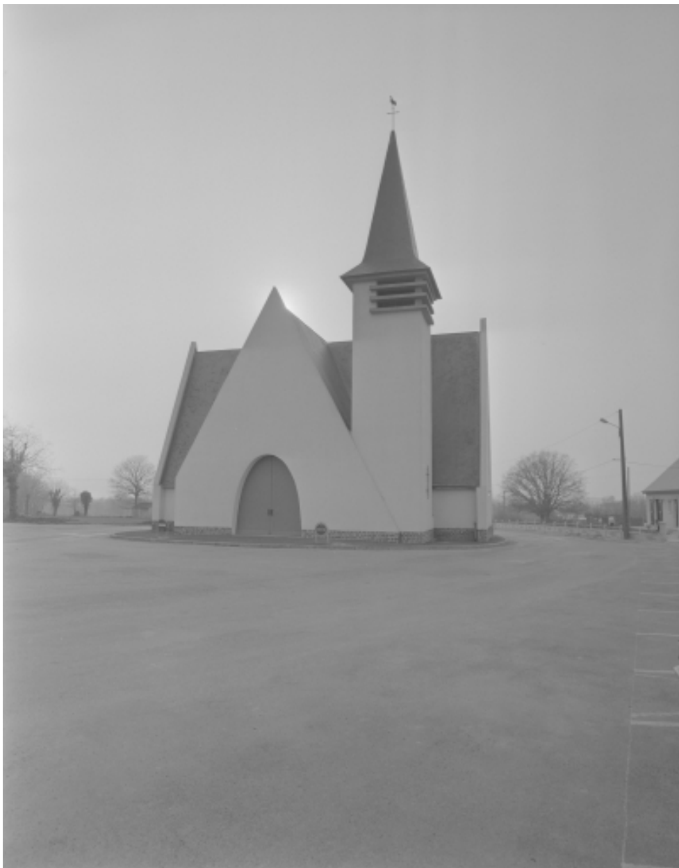
Elévation Sud : vue générale
