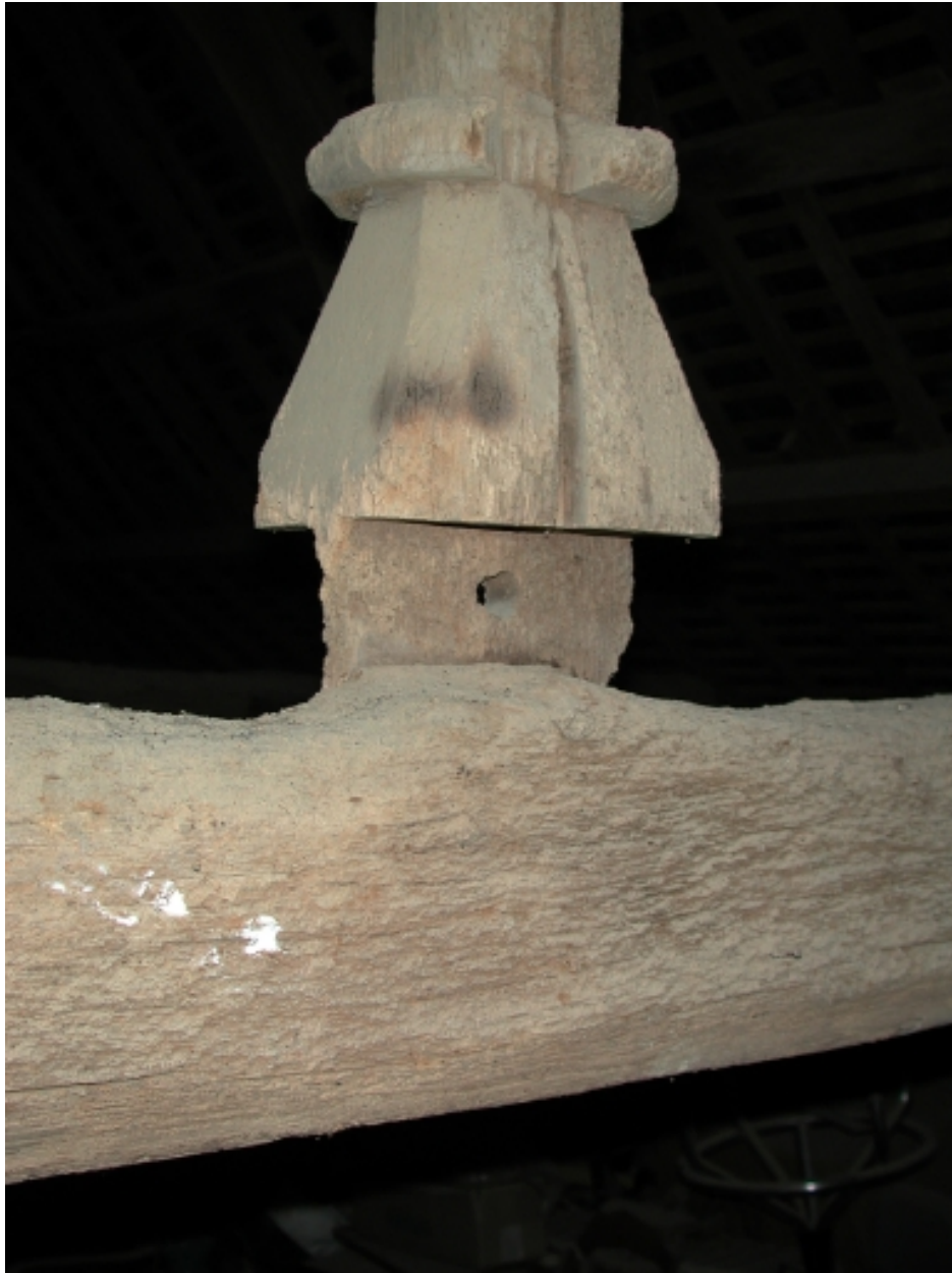
Charpente ; poinçon, partie basse
