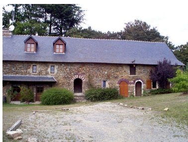
Vue partielle sud est Phot. Elise Lauranceau IVR53_20003513582NUCA
