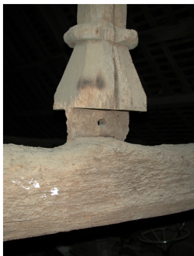
Charpente ; poinçon, partie basse Phot. Claude Quillivic IVR53_20003513749NUCA
