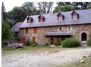
Vue partielle sud ouest Phot. Elise Lauranceau IVR53_20003513584NUCA
