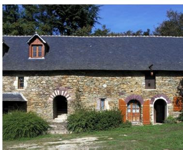
Vue partielle sud Phot. Guy Artur, Phot. Norbert Lambart IVR53_20003502418XA
