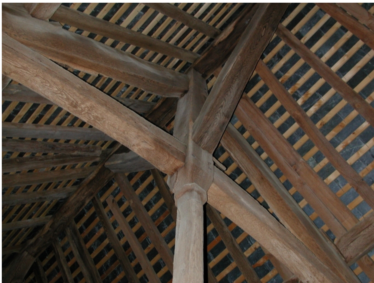
Charpente ; poinçon, partie haute
