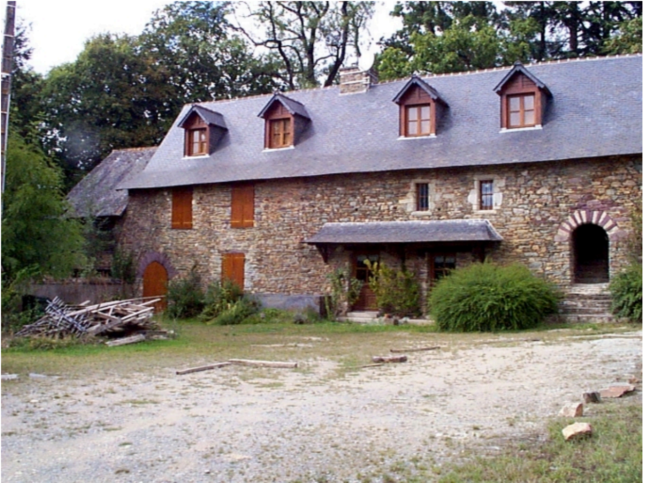
Vue partielle sud ouest
