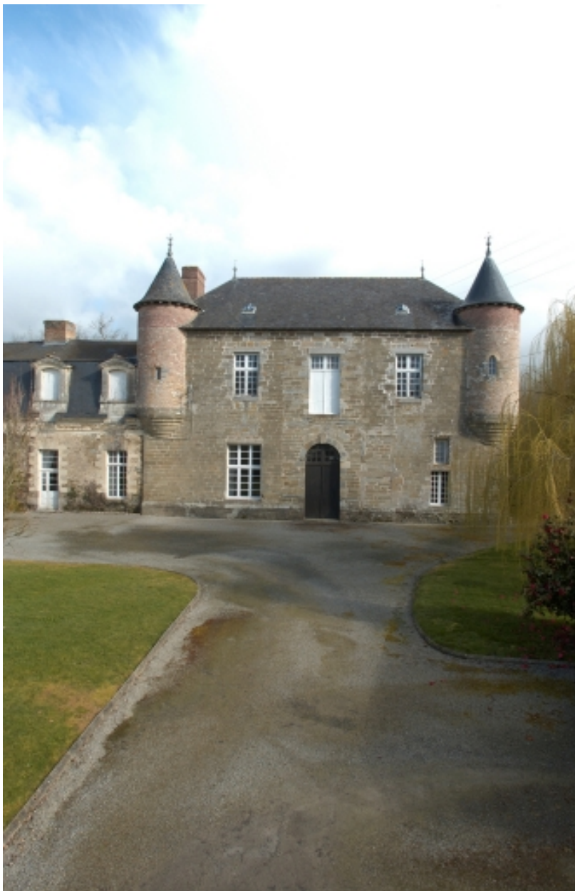
Vue sud de la partie la plus ancienne
