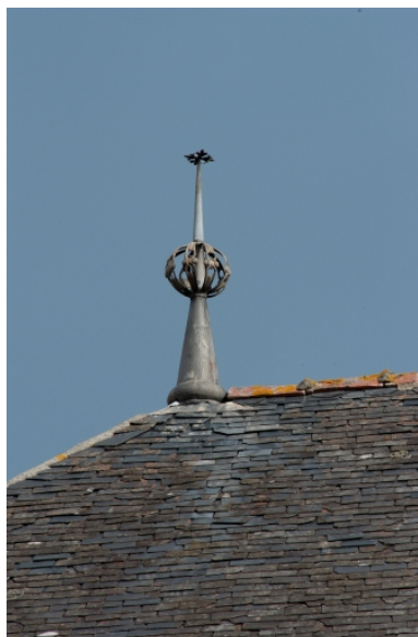
Détail d'un épi de faîtage Phot. Norbert Lambart IVR53_20043500372NUCA
