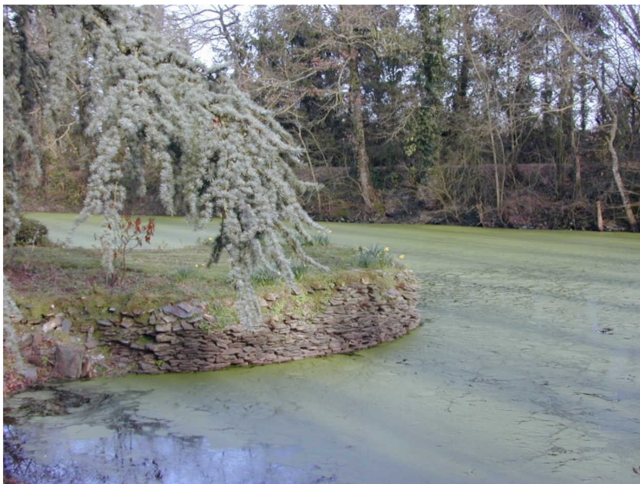
Angle sud-est de l'ancienne forteresse
