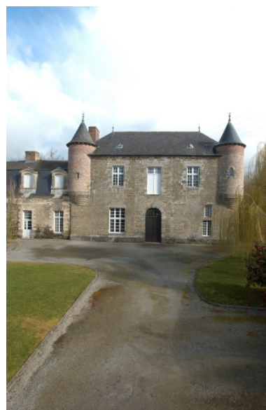
Vue sud de la partie la plus ancienne Phot. Norbert Lambart IVR53_20043500371NUCA
