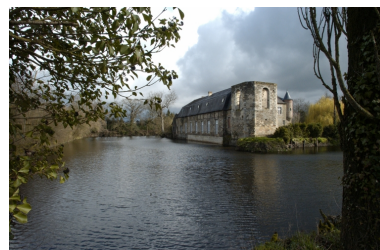
Vue sud-ouest Phot. Norbert Lambart IVR53_20043500374NUCA
