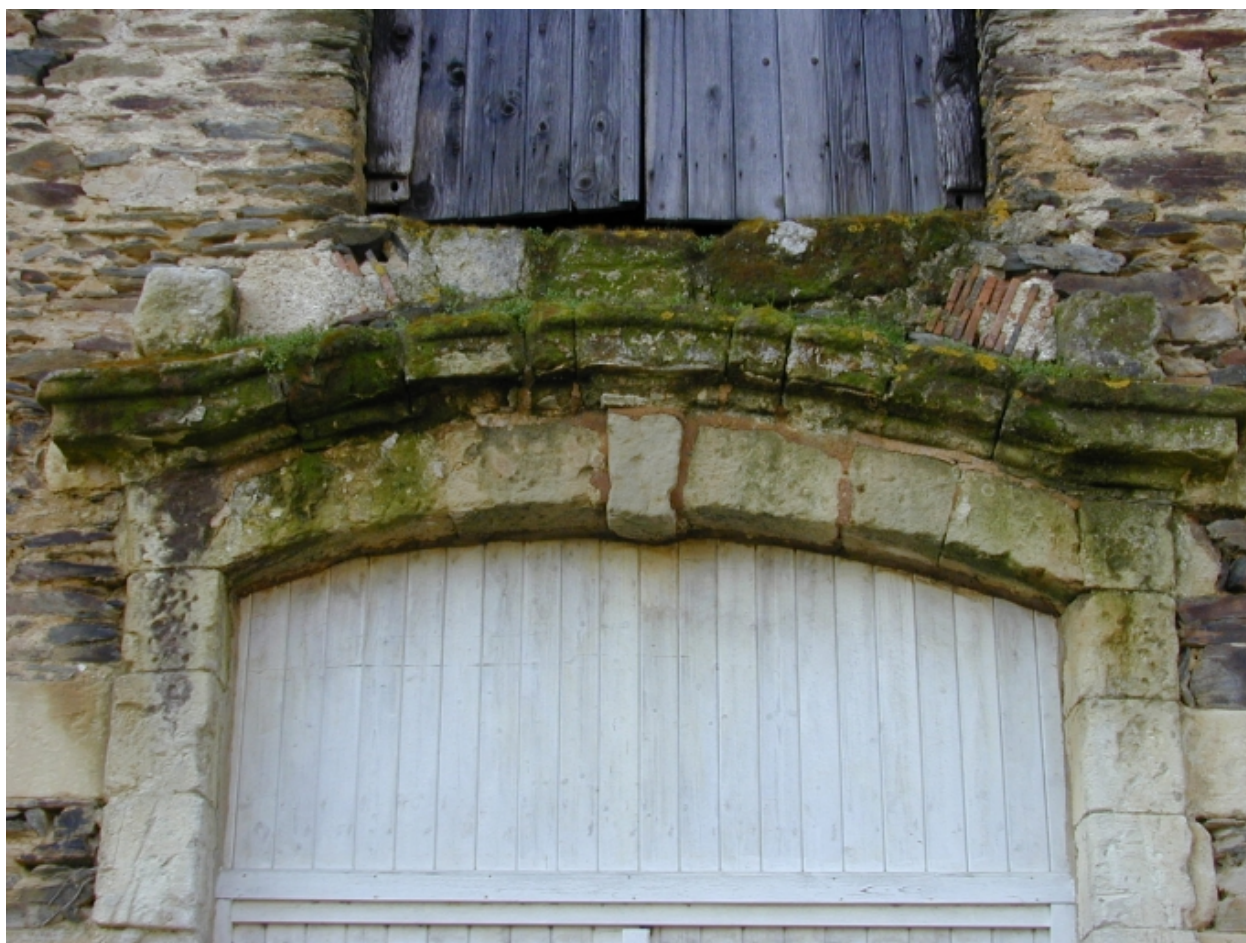
Détail de l'ouverture centrale des écuries
