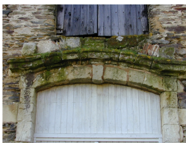
Détail de l'ouverture centrale des écuries Phot. Sabrina Dalibard IVR53_20043508212NUCA
