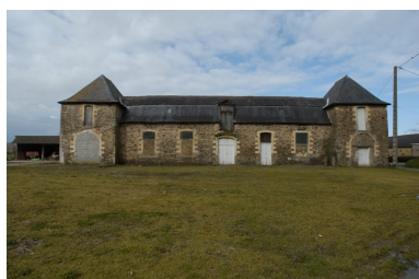
Les écuries Phot. Norbert Lambart IVR53_20043500376NUCA
