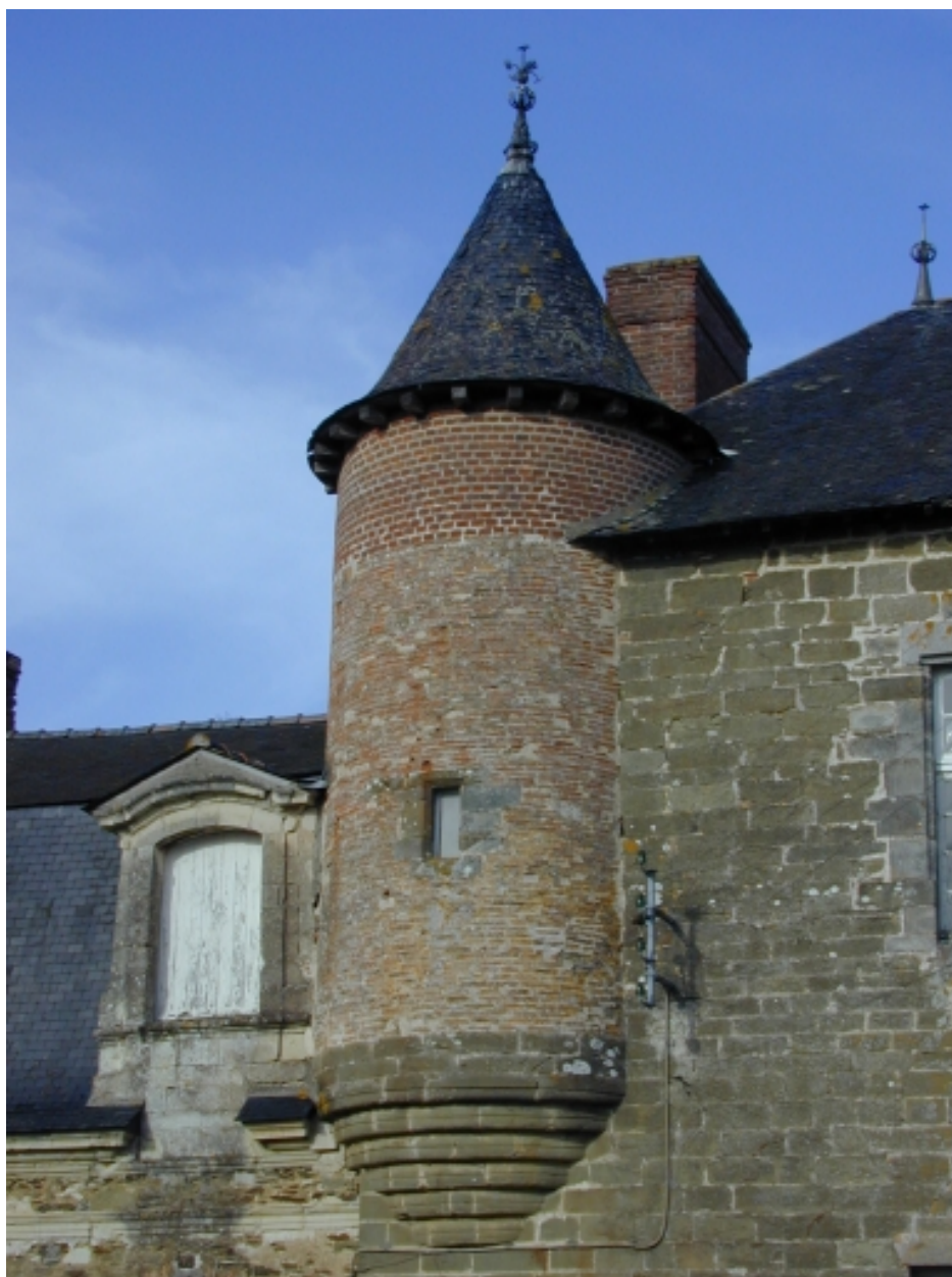
Détail de l'une des tourelles en encorbellement
