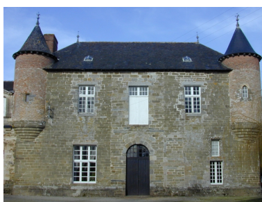
Vue générale sud Phot. Sabrina Dalibard IVR53_20043508203NUCA
