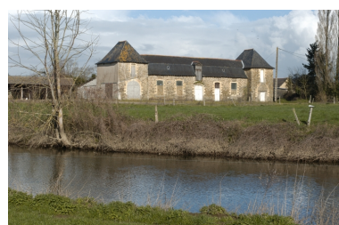
Les écuries Phot. Norbert Lambart IVR53_20043500365NUCA
