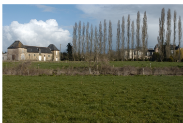
Le château et les écuries Phot. Norbert Lambart IVR53_20043500367NUCA
