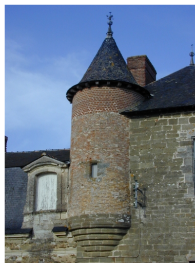
Détail de l'une des tours en encorbellement Phot. Sabrina Dalibard IVR53_20043508206NUCA
